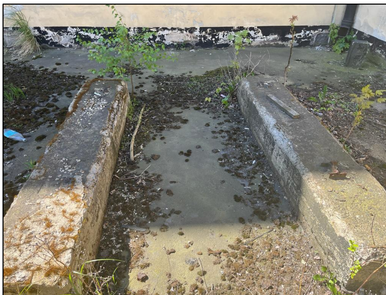
Fot. 2 Nawierzchnia utwardzona w planowanym miejscu wykonania otworu OW1
