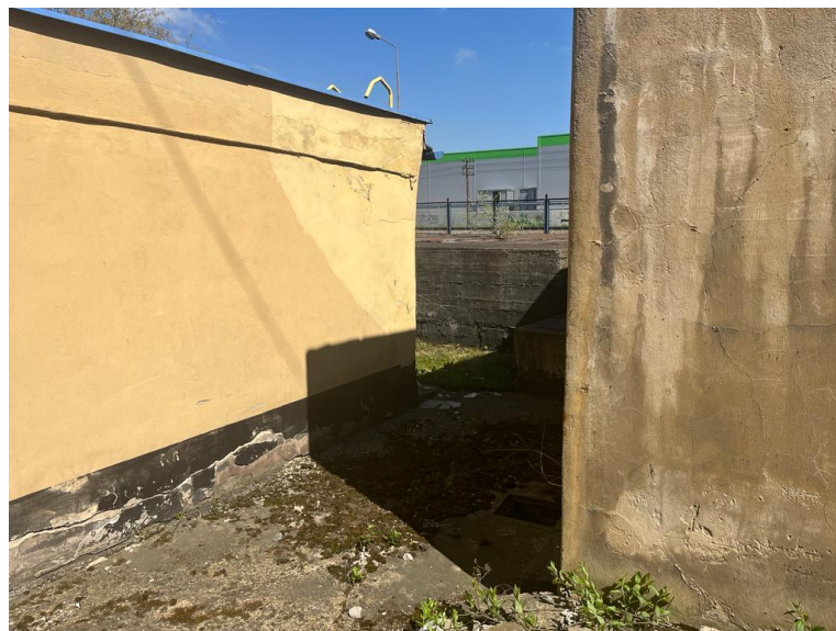
Fot. 4 Uniemożliwiony dojazd wiertnicą do planowanego miejsca wykonania otworu OW1
