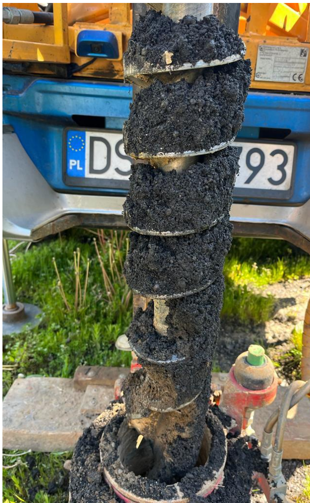
Przykład próby gruntu OW1 głębokość 0,0-0,5 m p.p.t. – nasyp niekontrolowany w składzie: szlaka, fragmenty cegła
