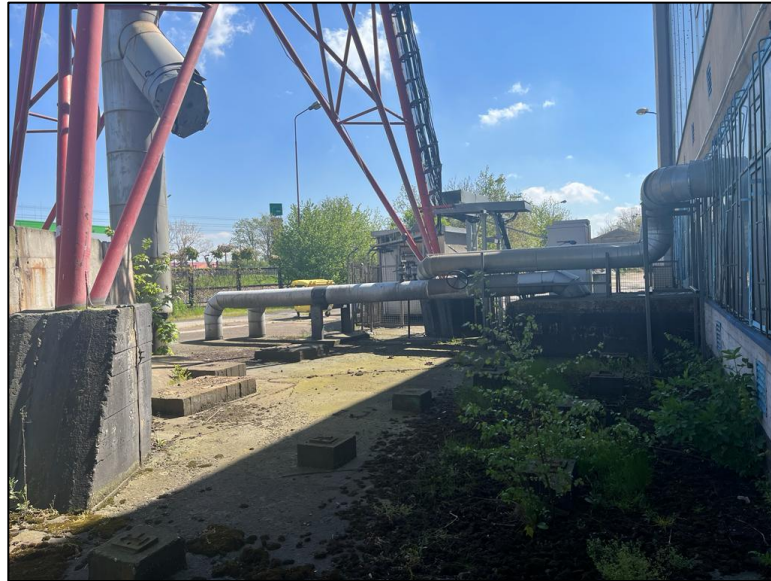
Fot. 3 Infrastruktura naziemna uniemożliwiająca dojazd wiertnicą do planowanej lokalizacji otworu OW1
