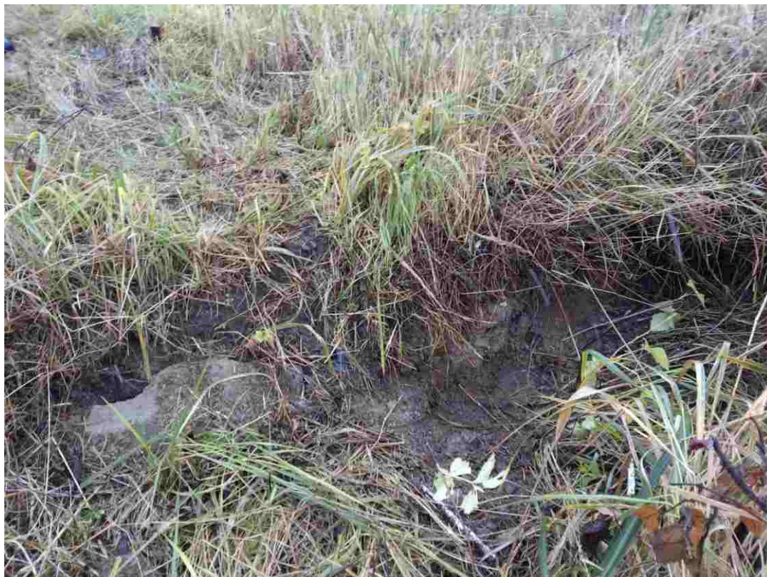
Pęknięcie w górnej części zbocza
