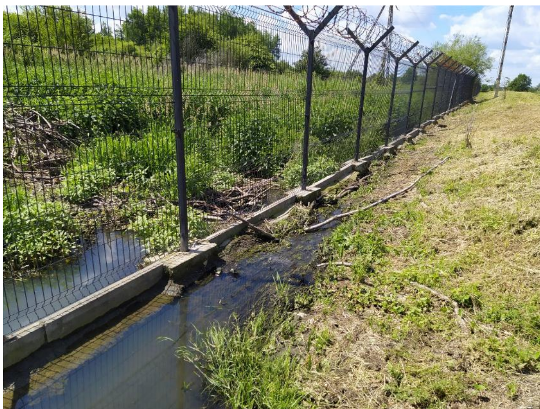
Przęsło 87-96: poprawa 2szt. podmurówki, dowóz gruntu
