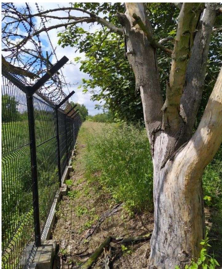
Przęsło 299-308: wstawienie zabezpieczenia, zasypanie grobli i ubytków gruntem, usunięcie martwego drzewa
