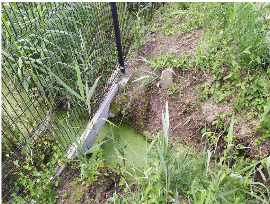
Przęsło 268-277: wstawienie zabezpieczenia, zasypanie grobli i ubytków gruntem
