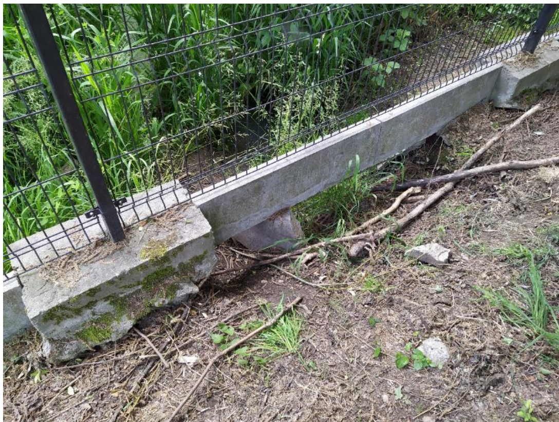
Przęsto 216-225: wstawić zabezpieczenie, poprawić podmurówki, dowieźć grunt
