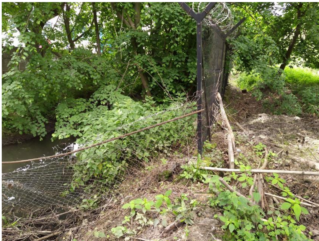
Przęsło 509-513: wymiana ostatniego panelu, wypoziomowanie ostatniego słupka
