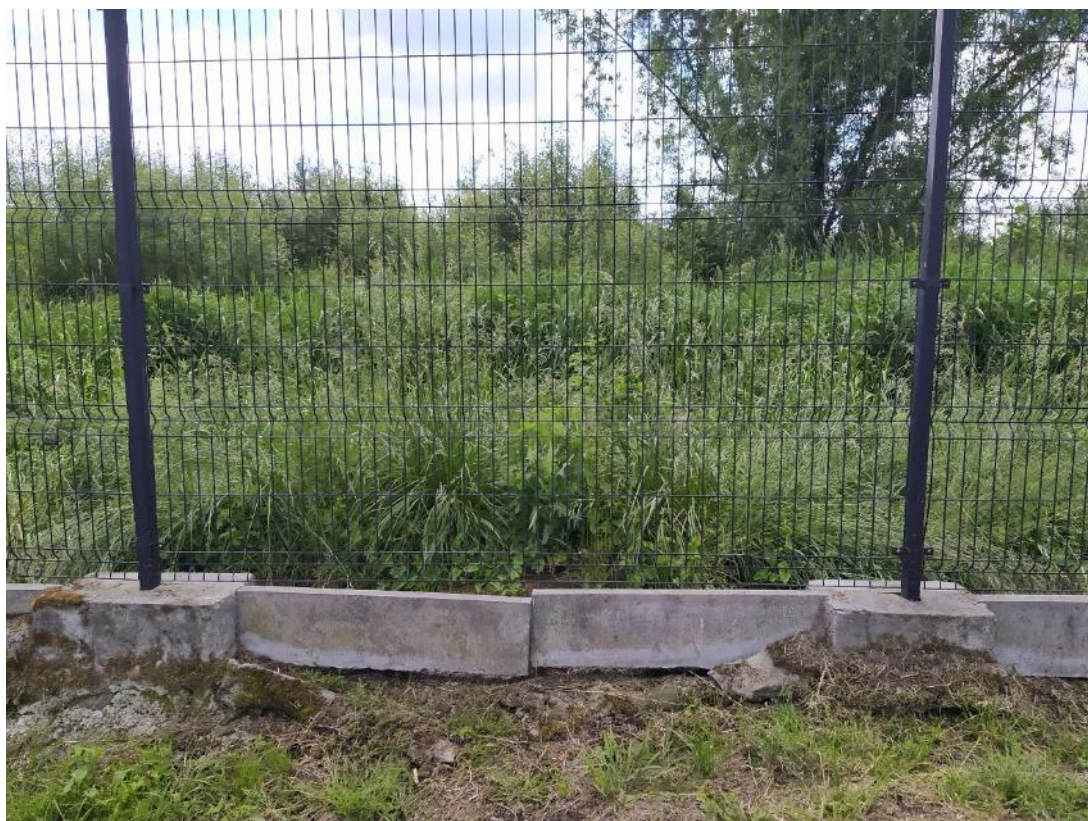
Przęsło 8-16: poziomowanie, poprawa podmurówki, dowóz gruntu
