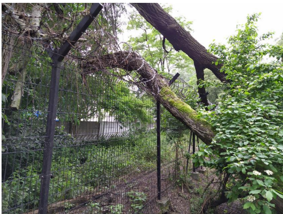
Przęsto 499-508: usunięcie gałęzi, wypoziomowanie 2 paneli, naprawa drutu, wykonanie zabezpieczenia
