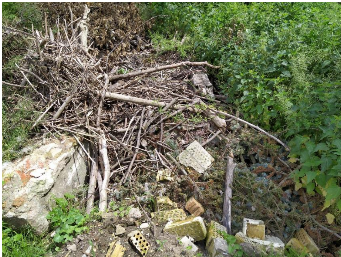
Uprzątnięcie śmieci, odpadów, zanieczyszczonego gruntu, dowóz gruntu z zagęszczeniem - KT
