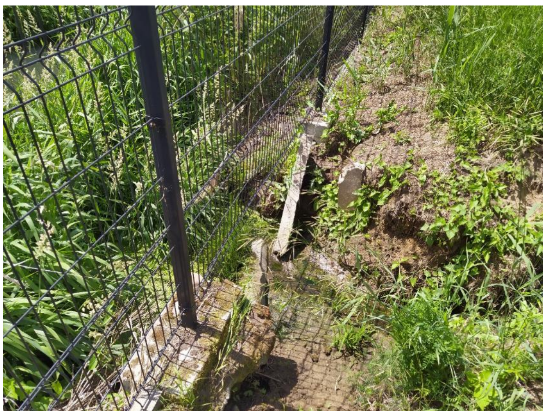
Przęsło 289-298: wstawienie zabezpieczenia, zasypanie grobli i ubytków gruntem
