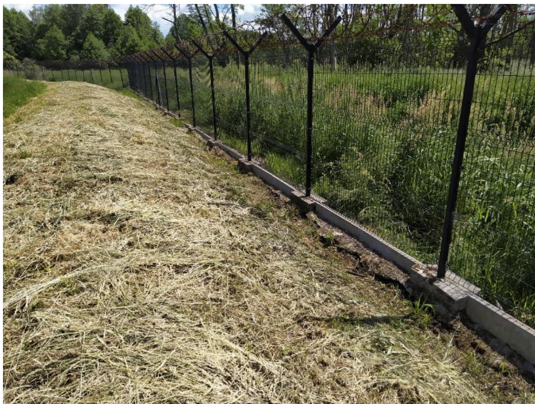
Przęsto 117-126: dowóz gruntu na podmurówki
