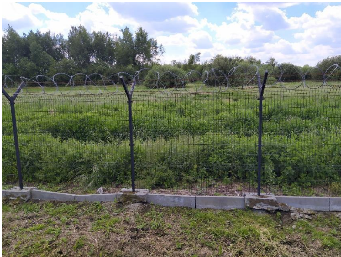
Przęsło 27-36: poziomowanie, poprawa podmurówki, dowóz gruntu
