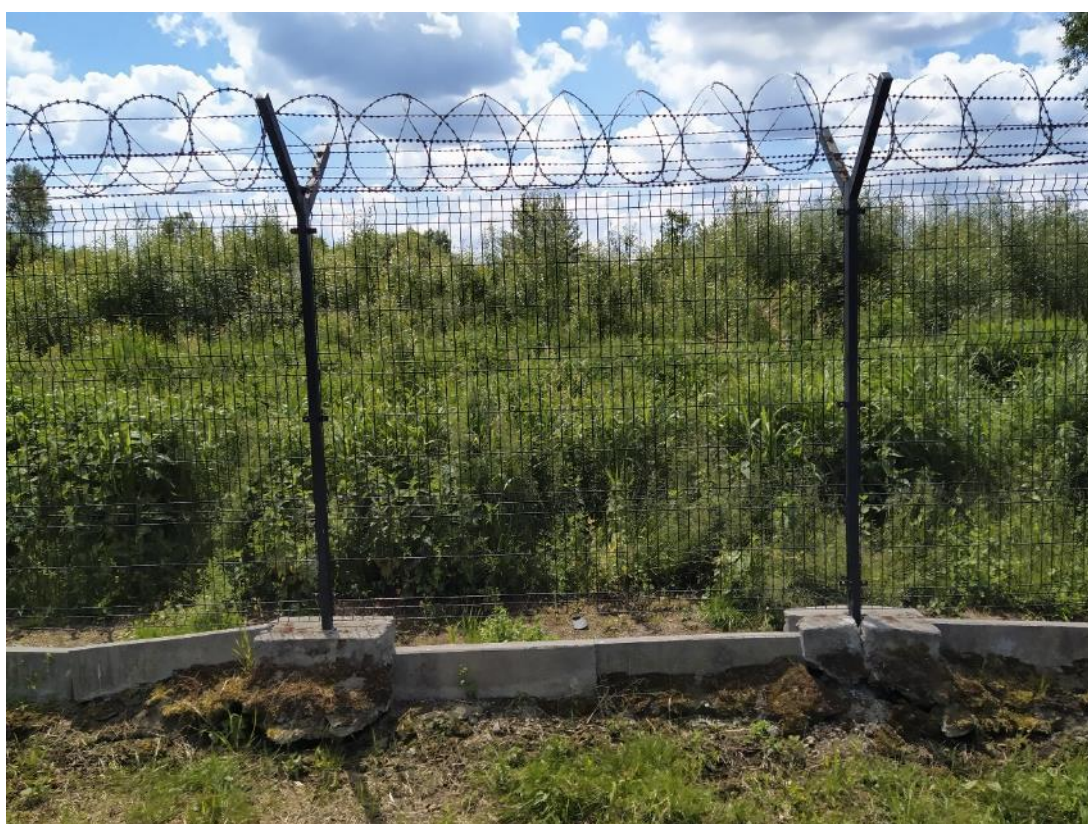
Przęsło 17-26: poziomowanie, poprawa podmurówki, dowóz gruntu
