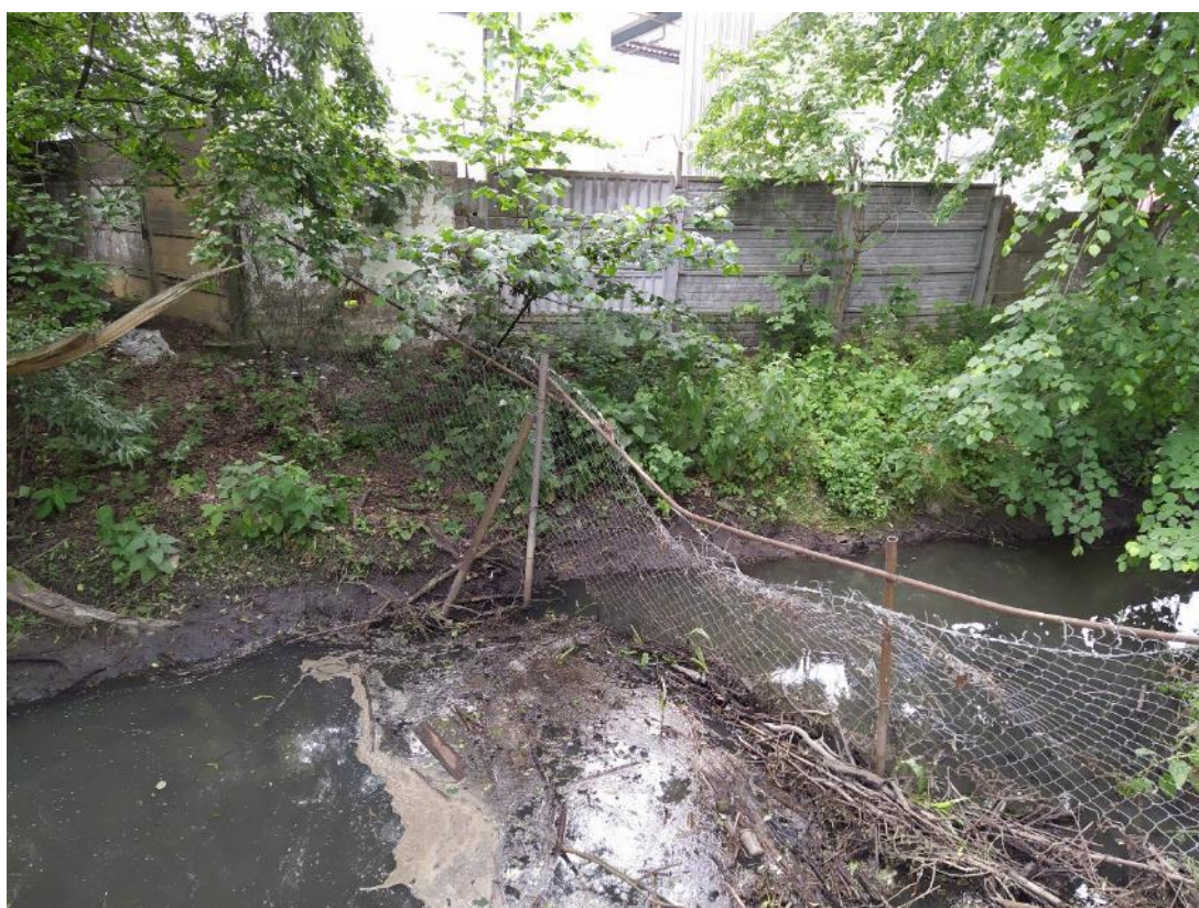
Demontaż ogrodzenia z siatki i ponowny montaż nowego
