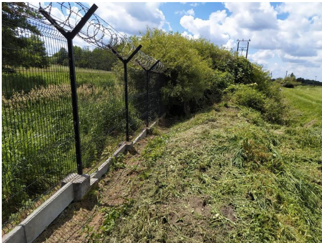
Przęsło 166-175: wy poziomowanie ogrodzenia (zakrzaczenie), karczowanie zakrzaczenia, dowóz gruntu pod podmurówki
