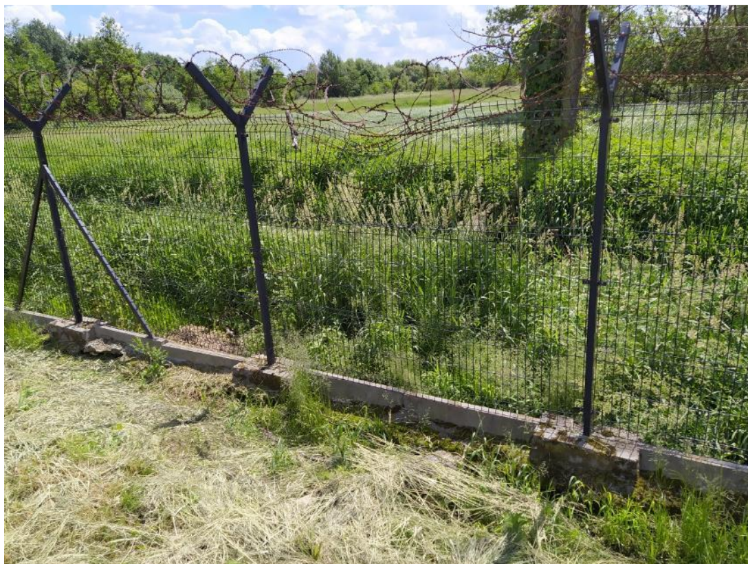
Przęsło 127-136: dowóz gruntu na podmurówki, panel do wymiany, wymiana drutu kolczastego
