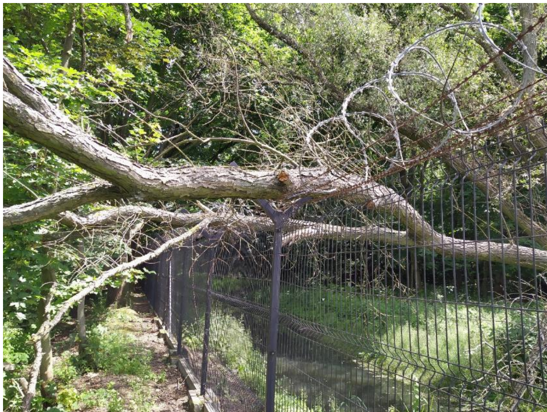
Przęsło 319-328: wycięcie martwego drzewa, usunięcie gałęzi z ogrodzenia, wymiana panelu, naprawa drutu kolczastego
