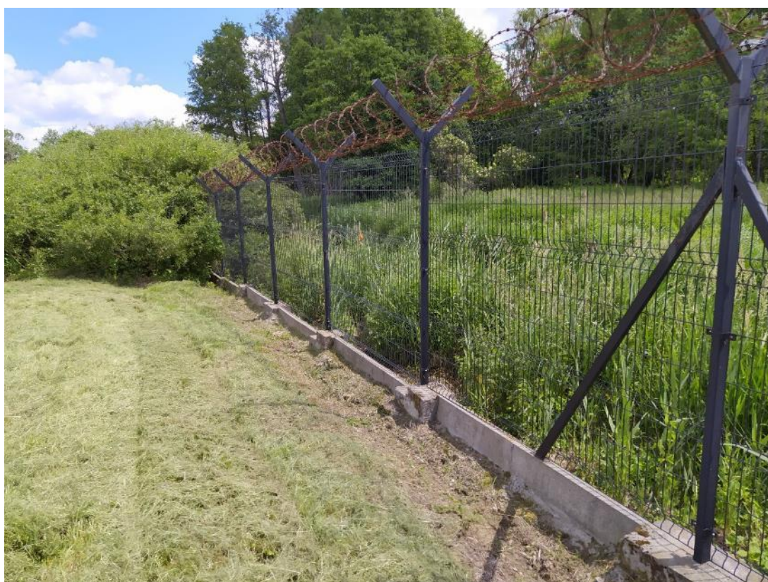
Przęsło 156-165: wypoziomowanie ogrodzenia (zakrzaczenie)
