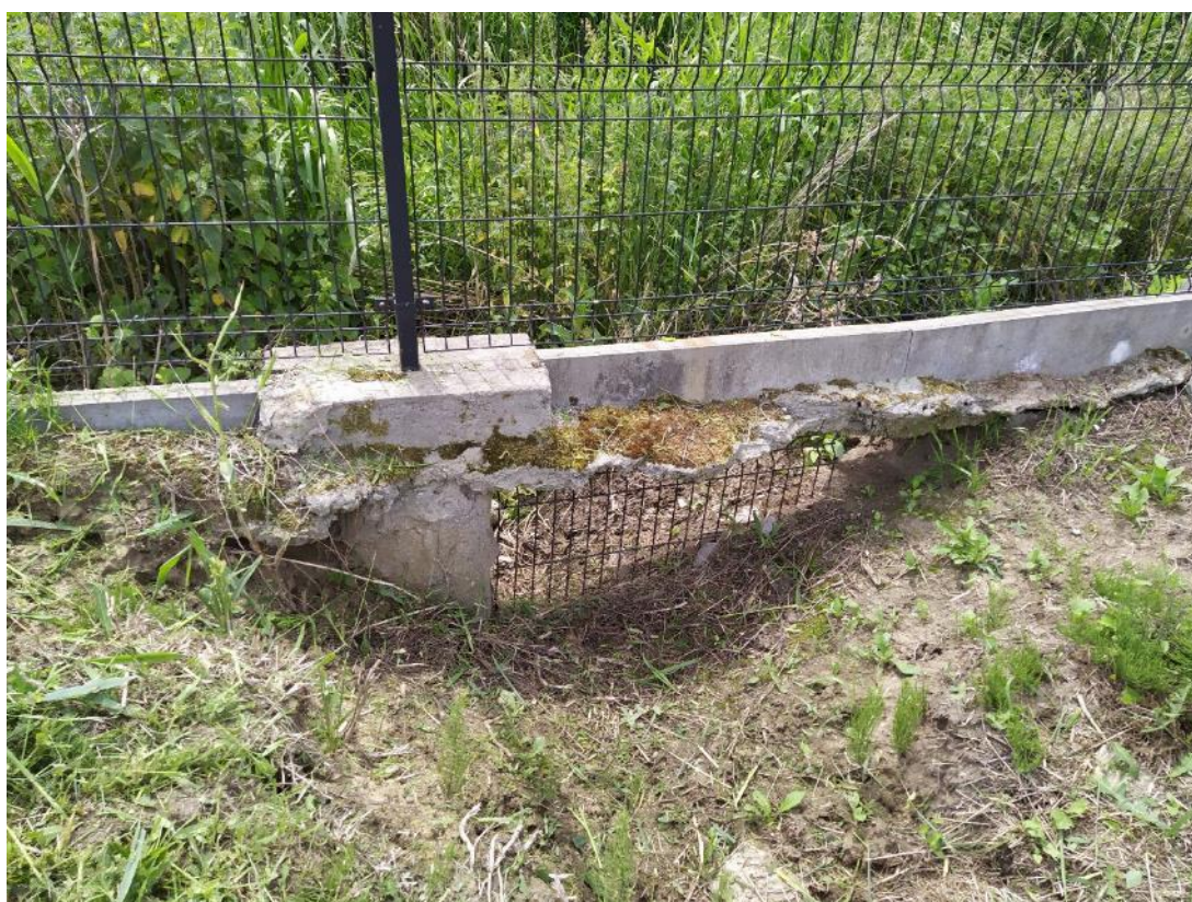
Przęsto 257-266: podmurówki do poprawy, zasypanie ubytków gruntem
