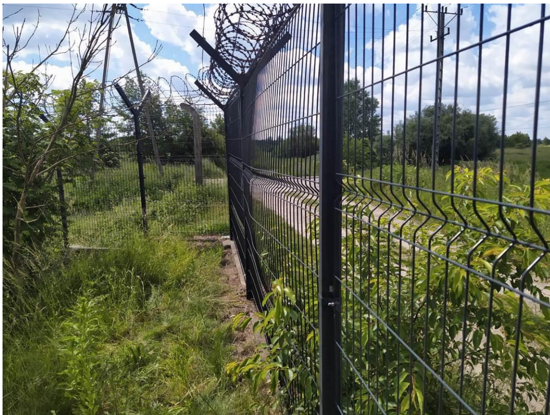
Przęsło 1-2: panel do wymiany
