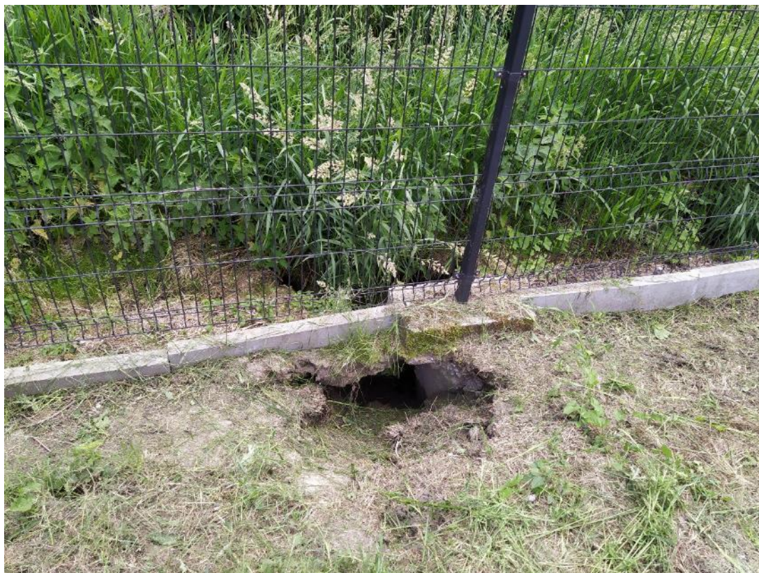
Przęsto 184-194: podmurówka do poprawy, wstawić zabezpieczenie, zasypać
