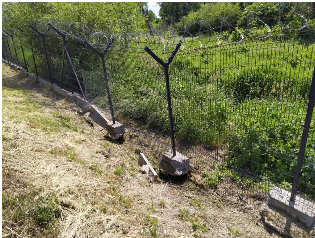
Przęsło 67-76: poziomowanie, poprawa podmurówki/zabezpieczenia, dowóz gruntu, 3 panele do wymiany
