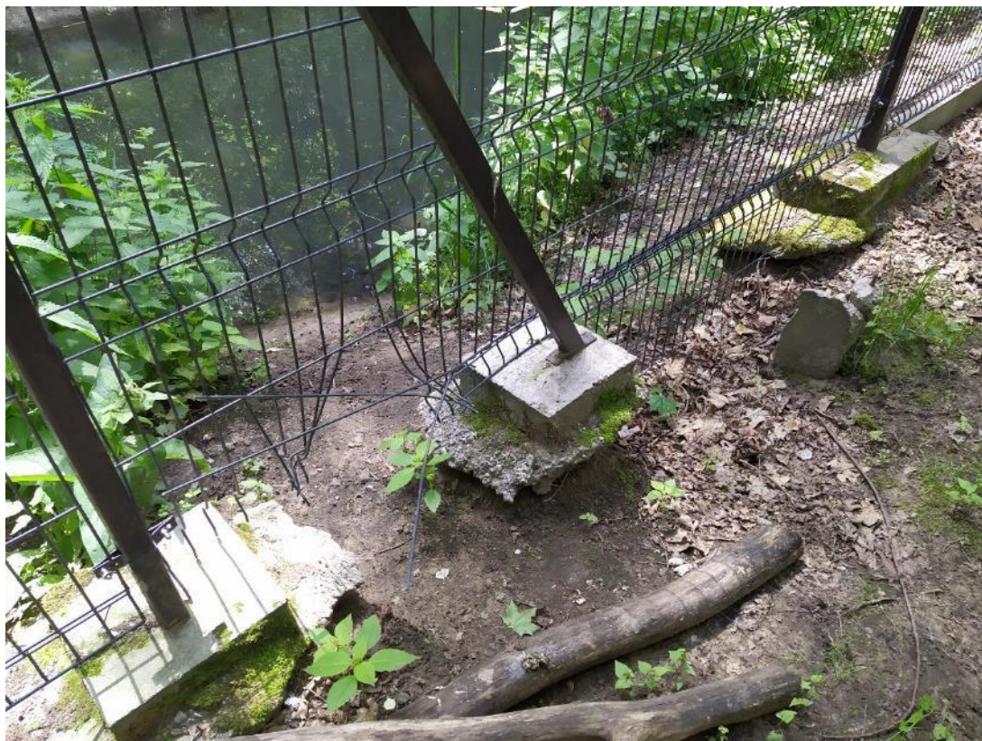
Przęsto 339-349: wymiana panelu, wykonanie zabezpieczenia, wymiana drutu kolczastego
