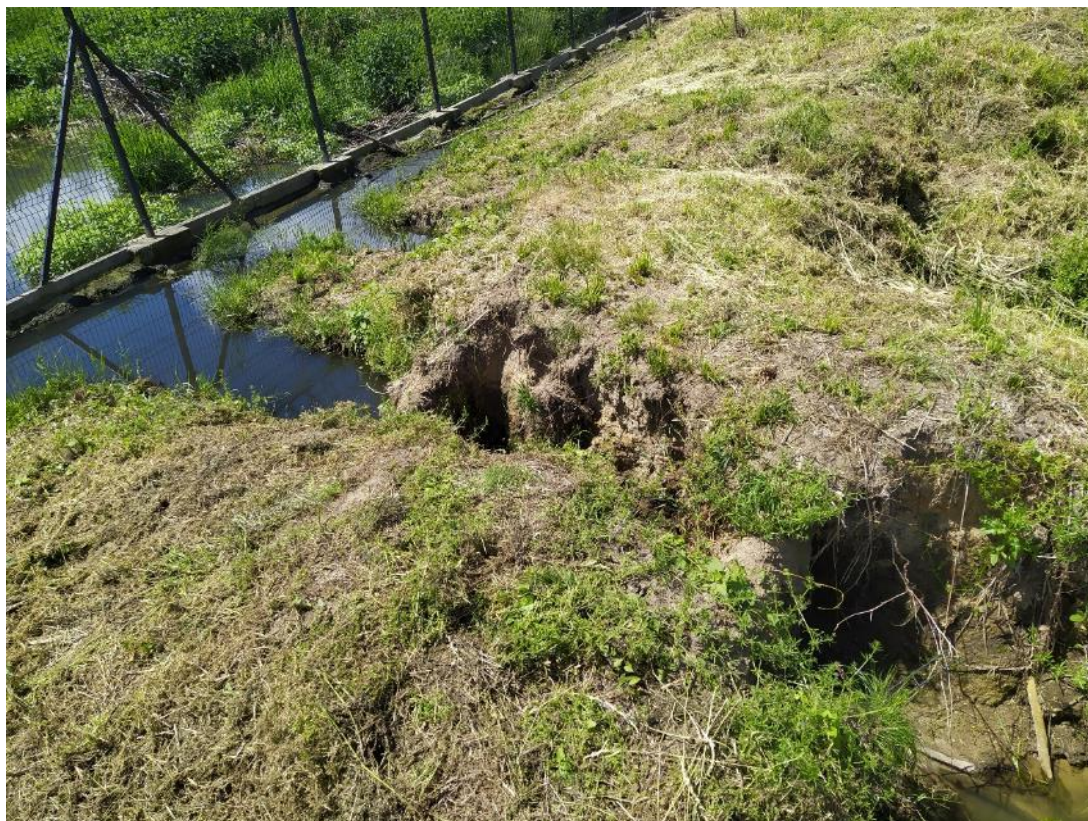
Przęsto 97-106: dowóz gruntu na podmurówki i groble, poprawa podmurówki, panel do wymiany
