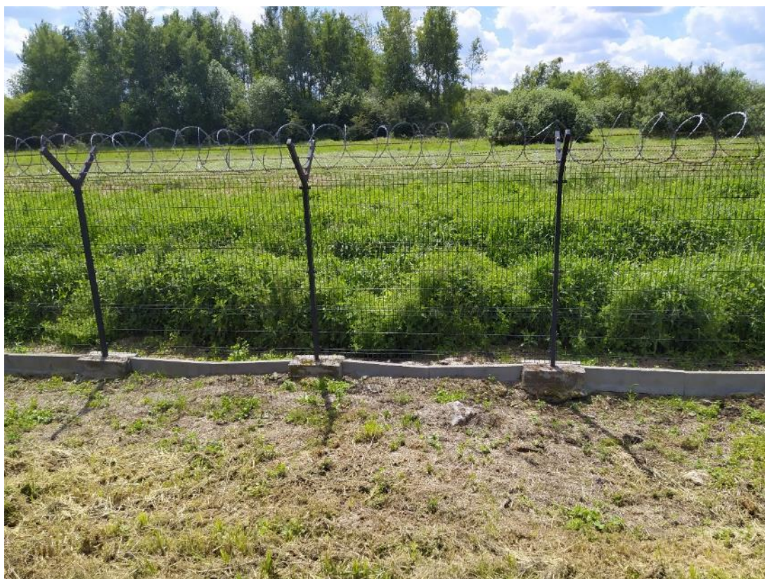
Przęsło 37-47: poziomowanie, poprawa podmurówki, dowóz gruntu
