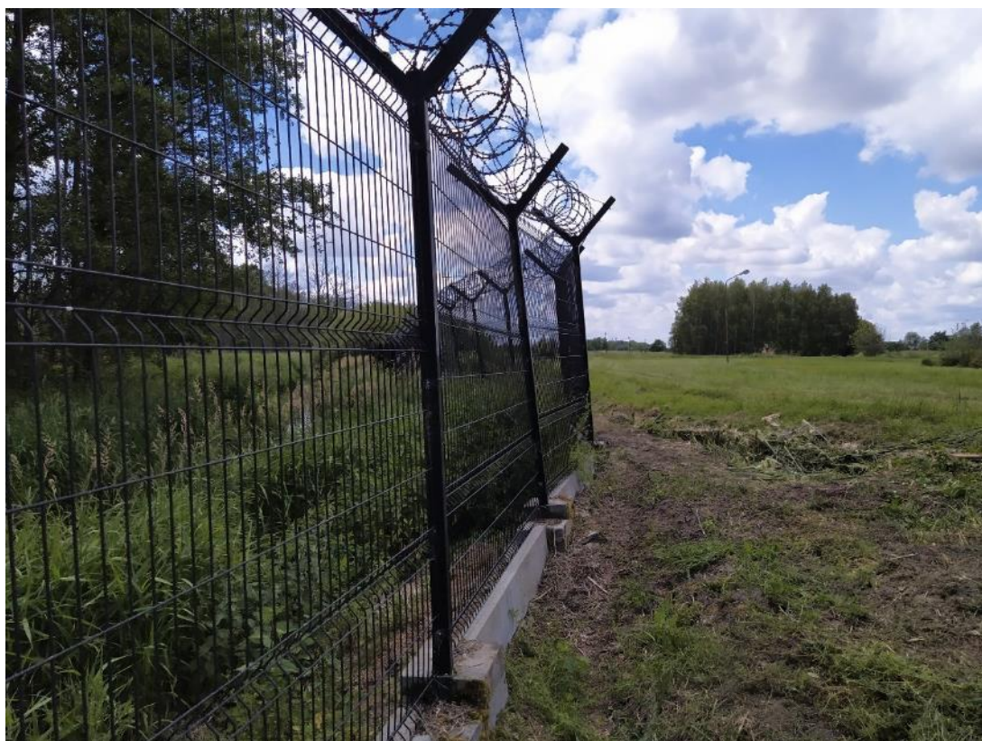
Przęsło 176-183: wy poziomowanie ogrodzenia, dowóz gruntu pod podmurówki, panel do wymiany
