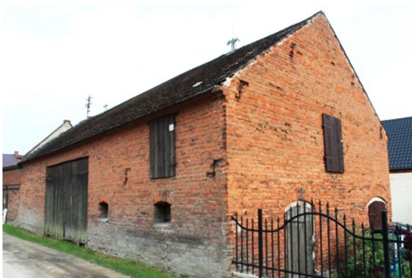
Kijowice – budynek gospodarczy w zagrodzie nr 21
