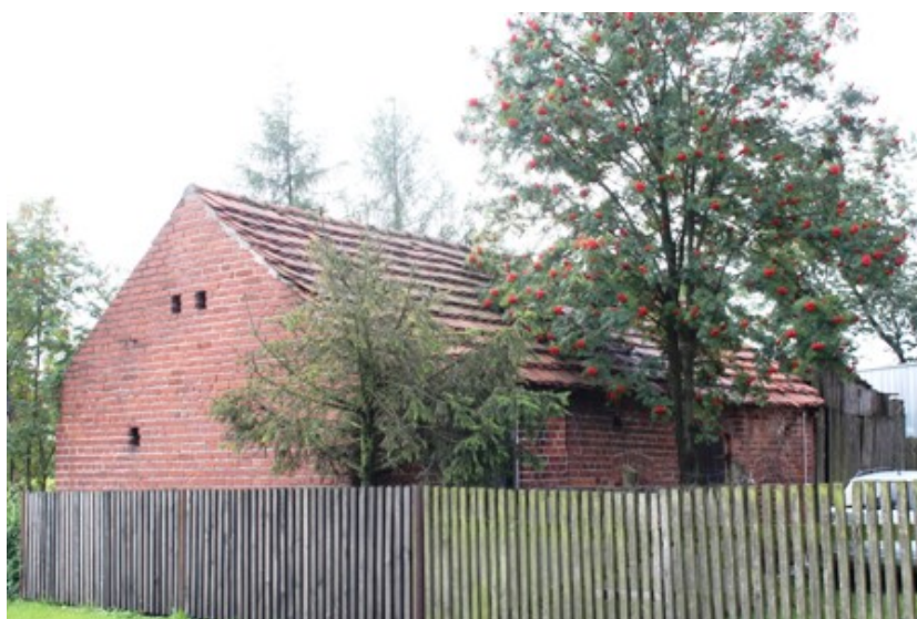
Radziszyn - budynek gospodarczy w zagrodzie nr 2
