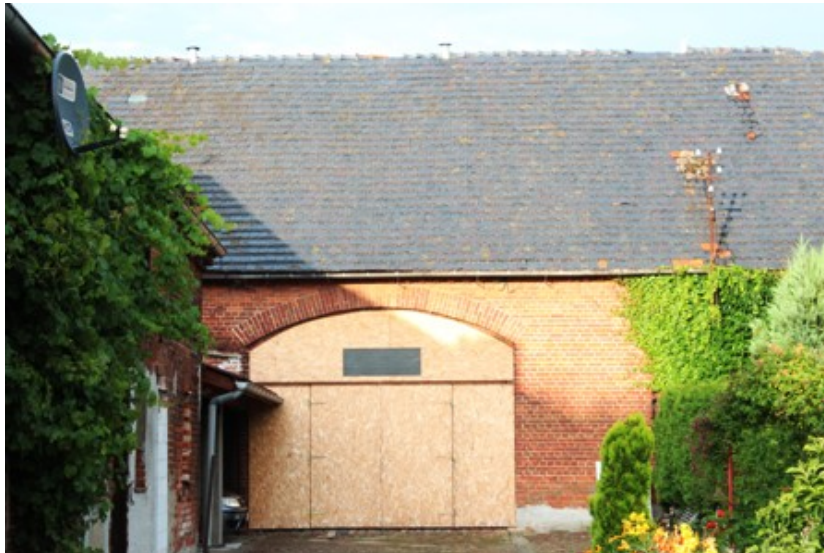
Kruszowice – budynek gospodarczy w zagrodzie nr 21
