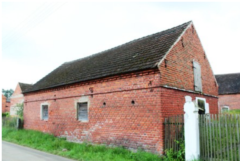
Kruszowice – budynek gospodarczy w zagrodzie nr 10
