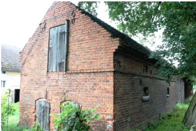
Radziszyn - budynek gospodarczy w zagrodzie nr 19
