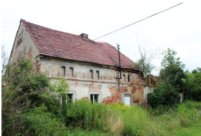
Solniki Małe – budynek mieszkalno-gospodarczy nr 26
