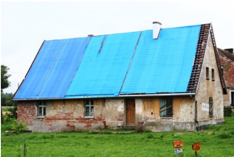
Radzieszyn – budynek mieszkalno-gospodarczy w zagrodzie nr 17
