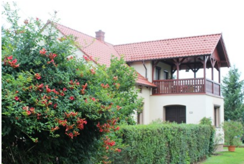
Posadowice – dom nr 12
