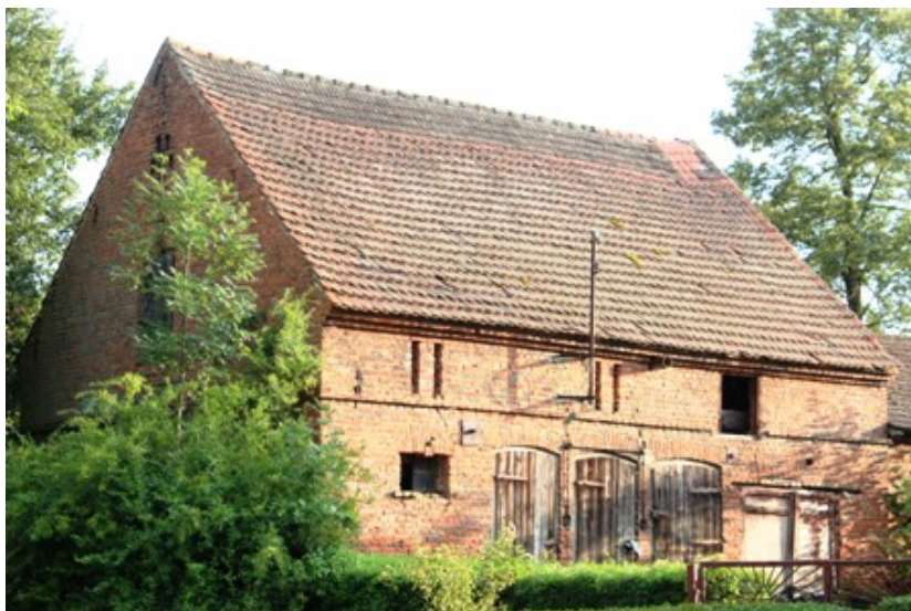
Kruszowice – budynek gospodarczy w zagrodzie nr 32
