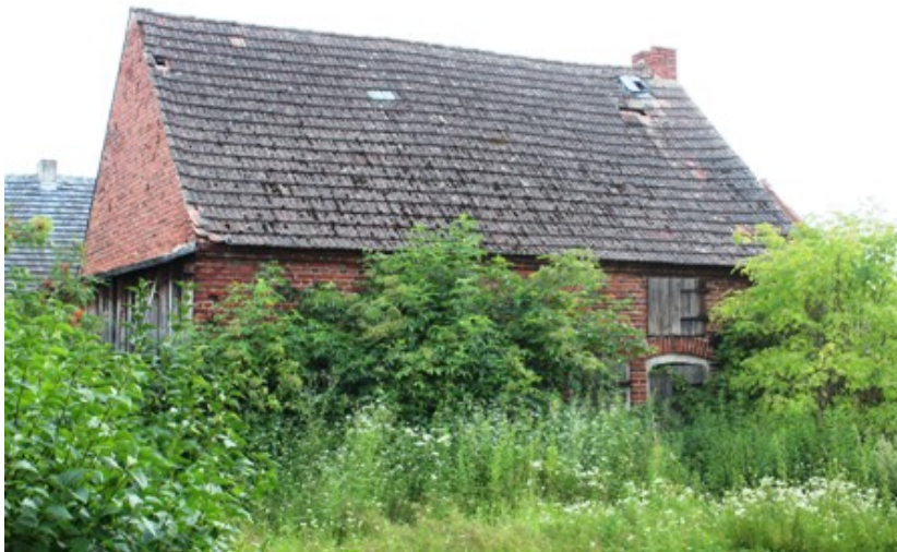
Kijowice – budynek gospodarczy w zagrodzie nr 4
