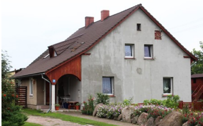
Posadowice – dom nr 20
