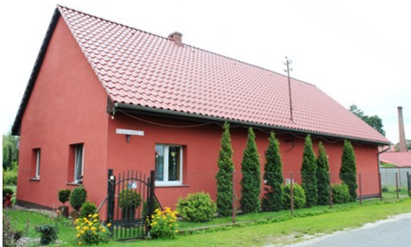
Posadowice - budynek mieszkalno-gospodarczy nr 30
