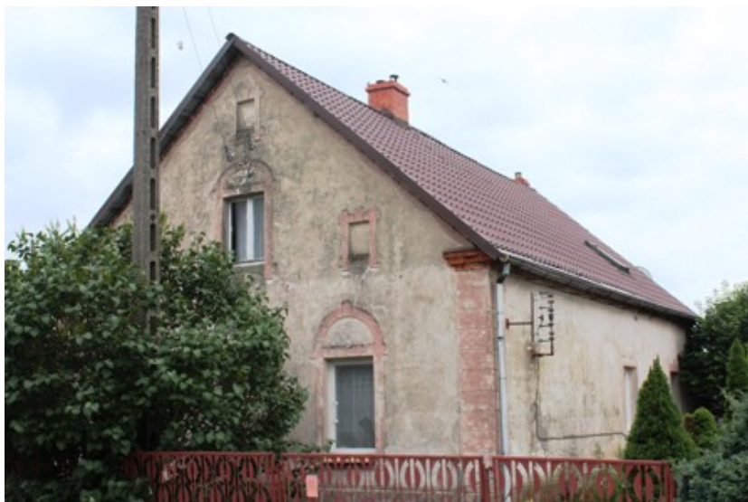
Posadowice – dom nr 21
