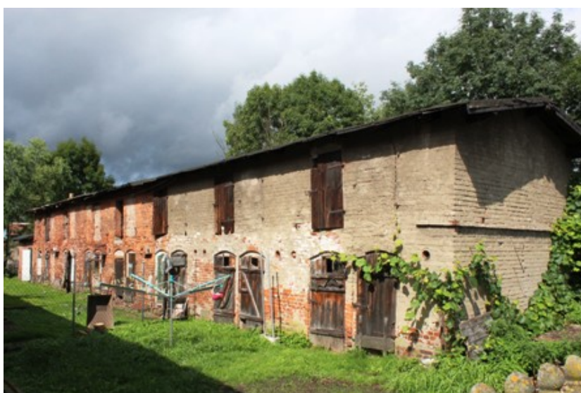
Zbytowa – budynek gospodarczy w zagrodzie nr 24
