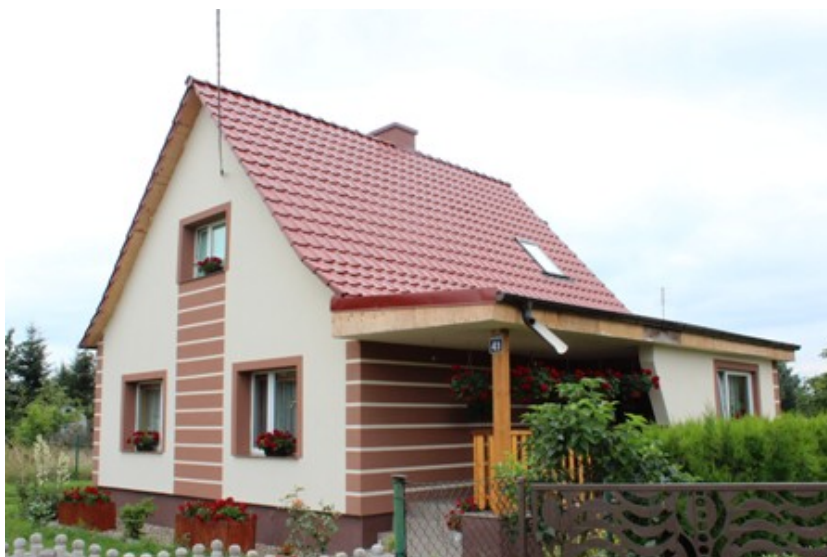
Posadowice – dom nr 41
