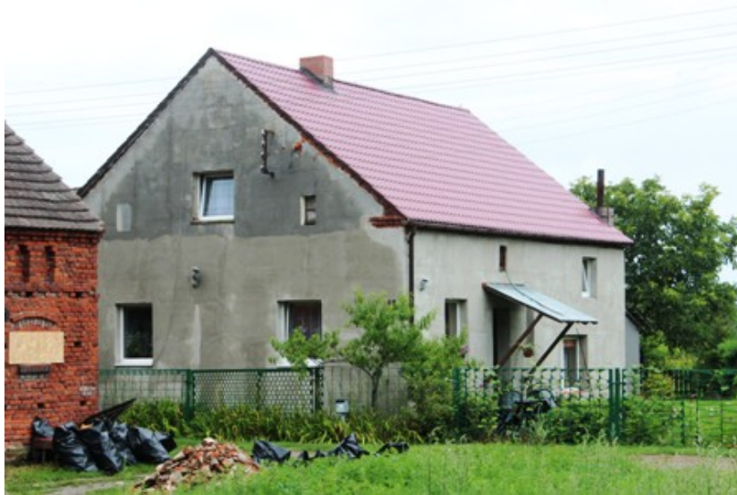
Posadowice – dom nr 11
