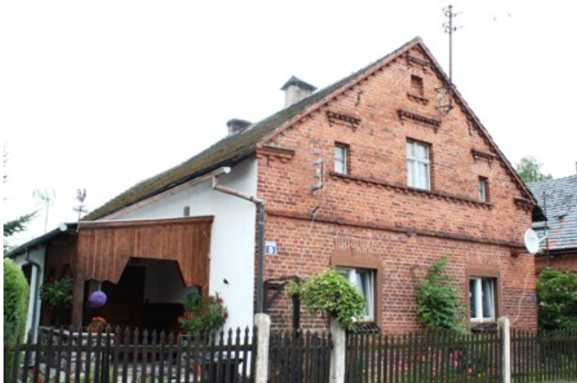
Posadowice – dom nr 5
