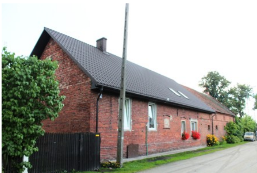
Kruszowice – budynek mieszkalno-gospodarczy nr 12
