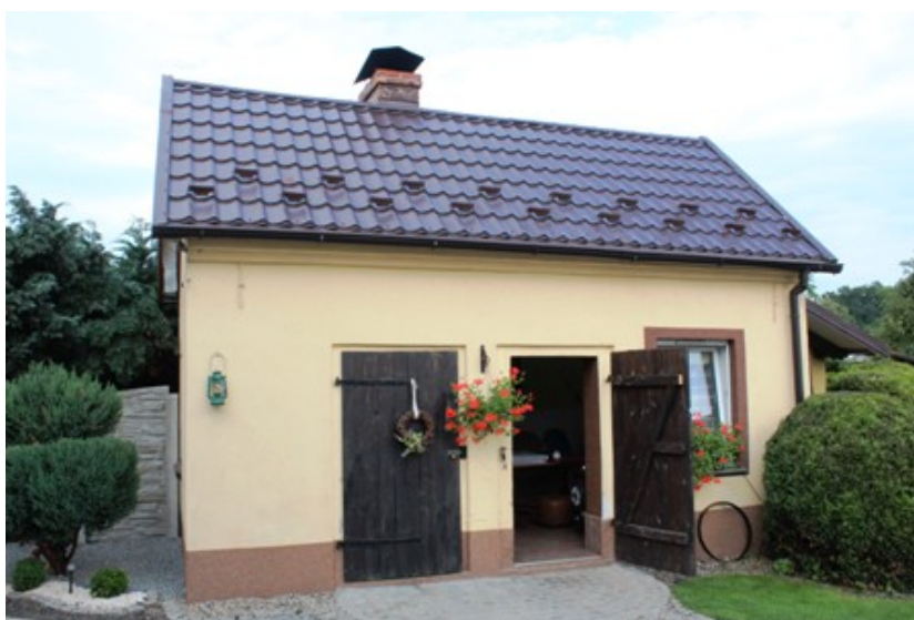
Kijowice – budynek gospodarczy w zagrodzie nr 15
