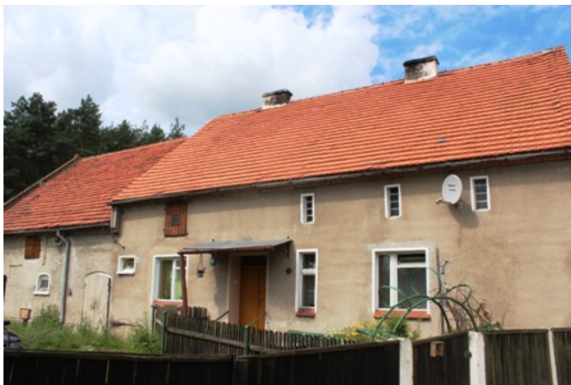
Karwiniec – budynek mieszkalno-gospodarczy nr 58
