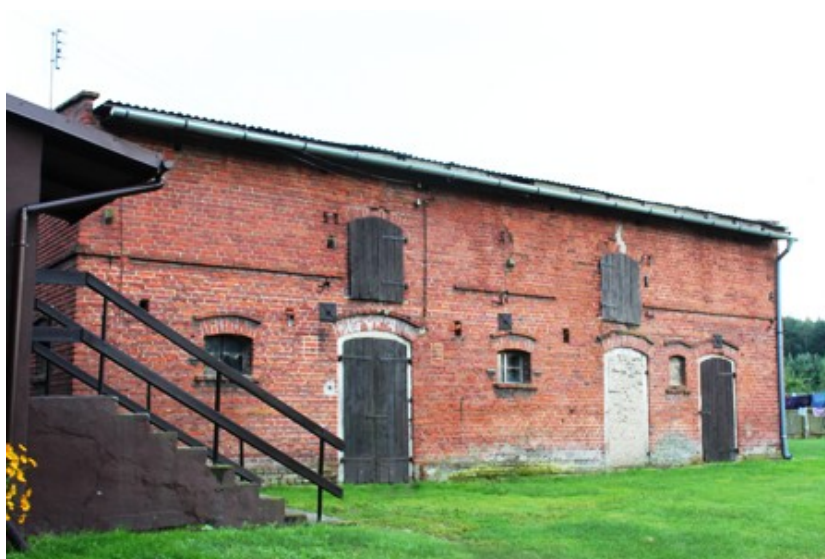
Kruszowice – budynek gospodarczy w zagrodzie nr 8
