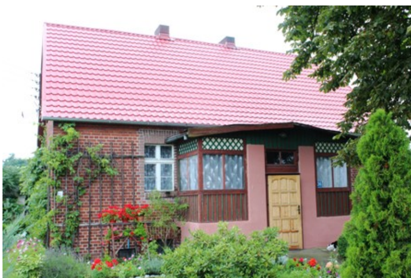
Posadowice – dom nr 36
