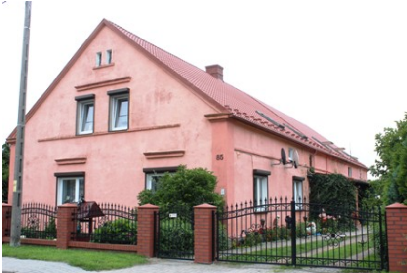
Wabienice – budynek mieszkalno-gospodarczy nr 85
