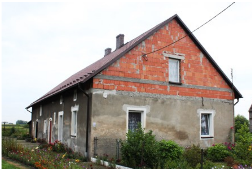
Posadowice – dom nr 23
