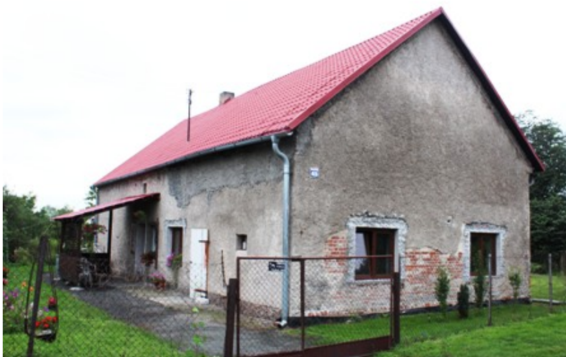
Posadowice – dom nr 45
