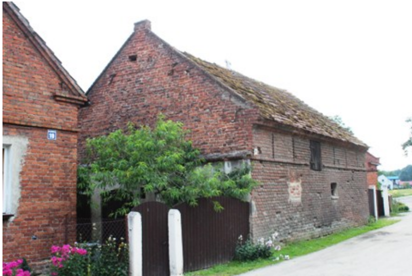
Kijowice – budynek gospodarczy w zagrodzie nr 19
