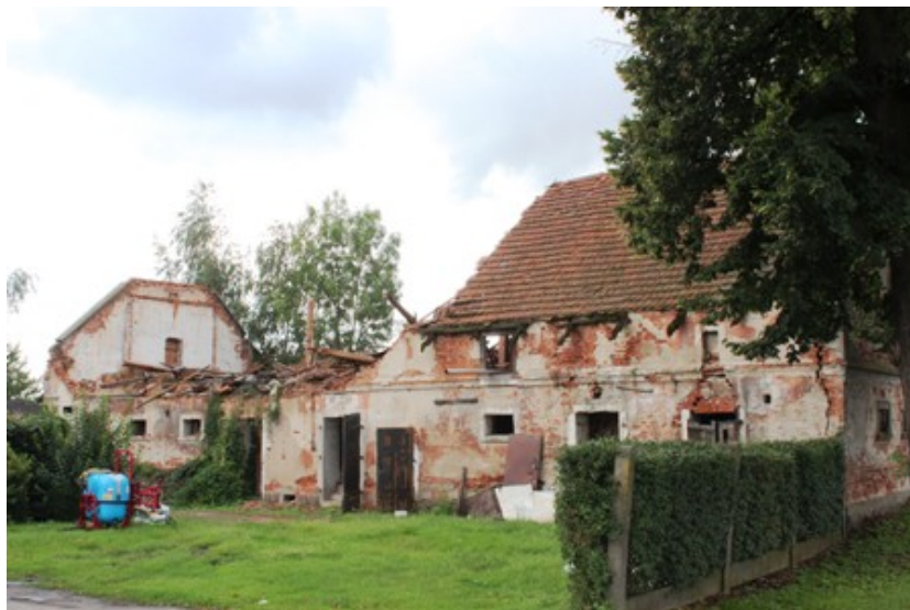
Zbytowa – budynek gospodarczy w zagrodzie nr 44
