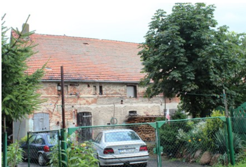
Zawidowice – budynek gospodarczy w zagrodzie nr 19
