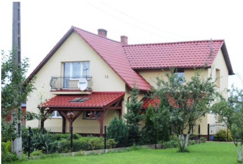
Posadowice – dom nr 13
