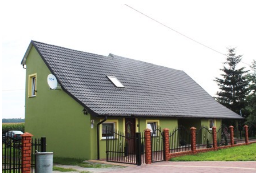
Radzieszyn - budynek mieszkalno-gospodarczy w zagrodzie nr 5
