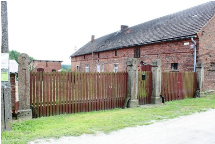
Kijowice – budynek mieszkalno-gospodarczy z ogrodzeniem nr 5
