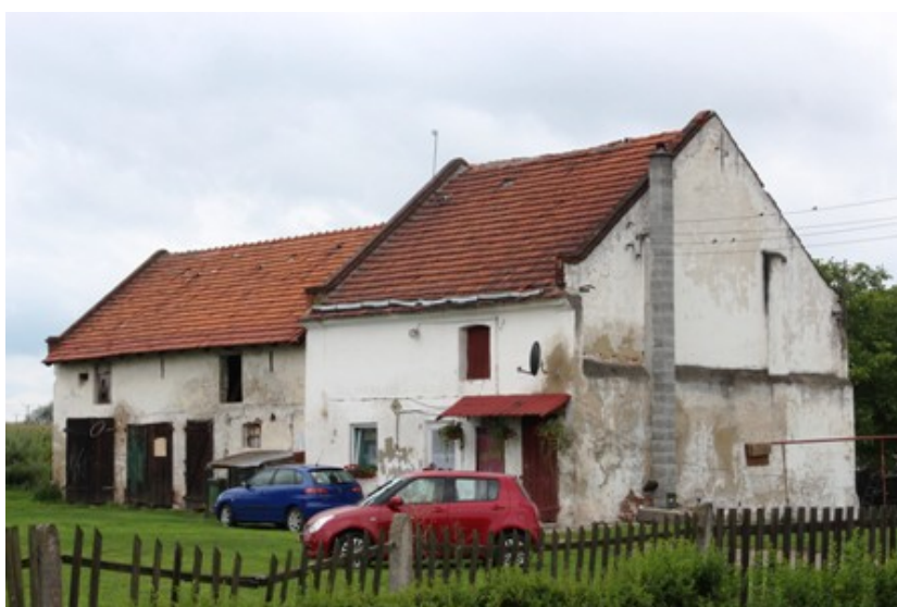
Solniki Wielkie – budynek mieszkalno-gospodarczy nr 85
