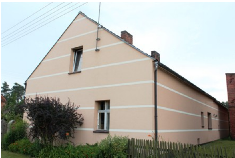
Kruszowice – budynek mieszkalno-gospodarczy nr 6
