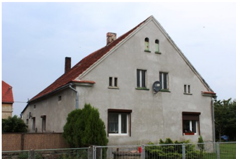
Wabienice – budynek mieszkalno-gospodarczy nr 6
