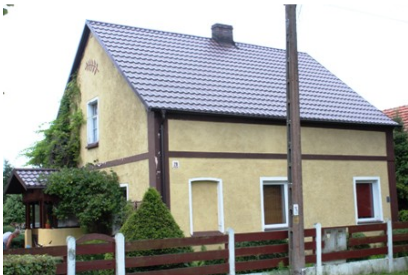
Posadowice – dom nr 28
