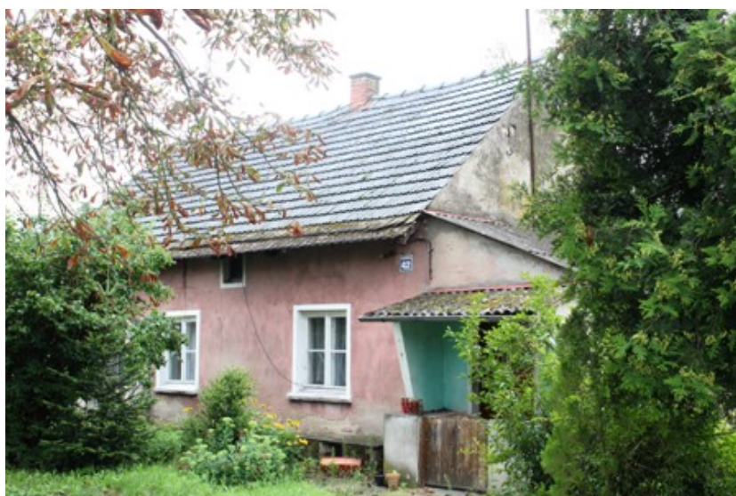
Posadowice – dom nr 42
