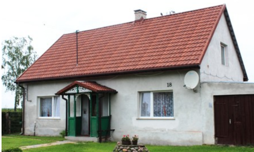
Posadowice – dom nr 18
