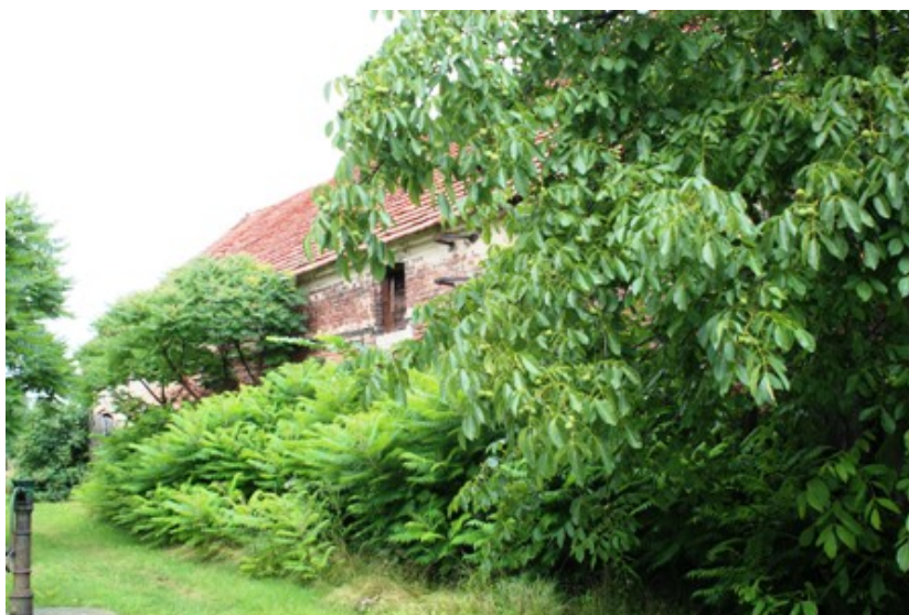
Zawidowice – budynek gospodarczy w zagrodzie nr 24
