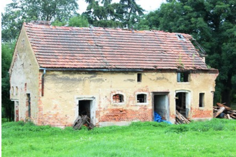
Radziszyn - budynek gospodarczy w zagrodzie nr 17
