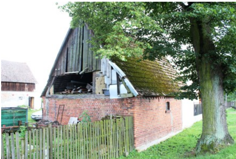
Zbytowa – budynek mieszkalno-gospodarczy w zagrodzie nr 84
