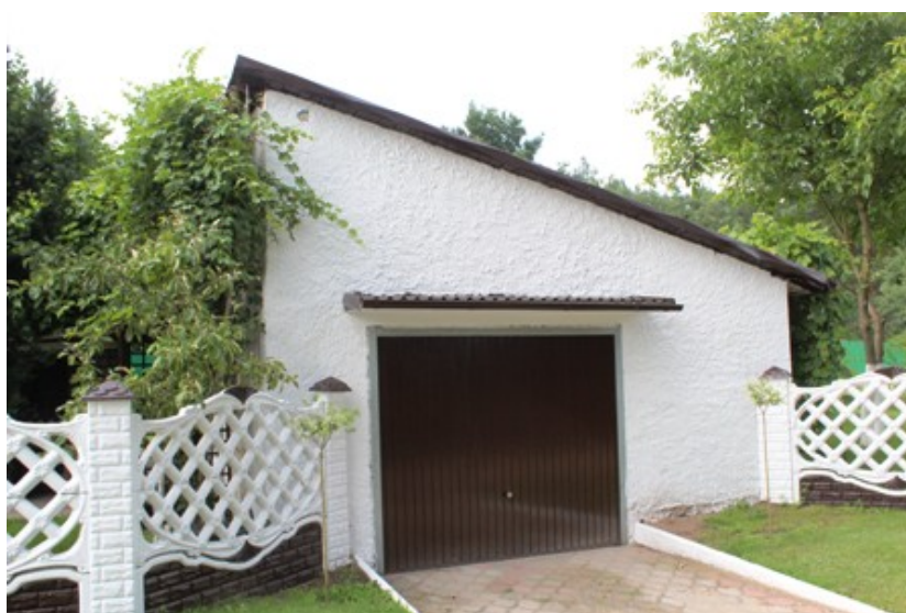
Kijowice – budynek gospodarczy w zagrodzie nr 14
