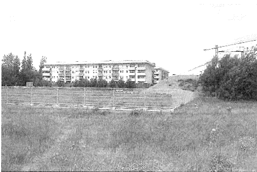
Fot.4. Widok w na działkę w północno-zachodnią
