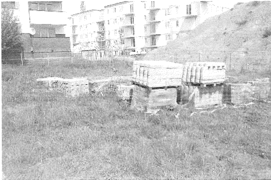
Fot.5. Nawierzchnia z płyt azurowych
