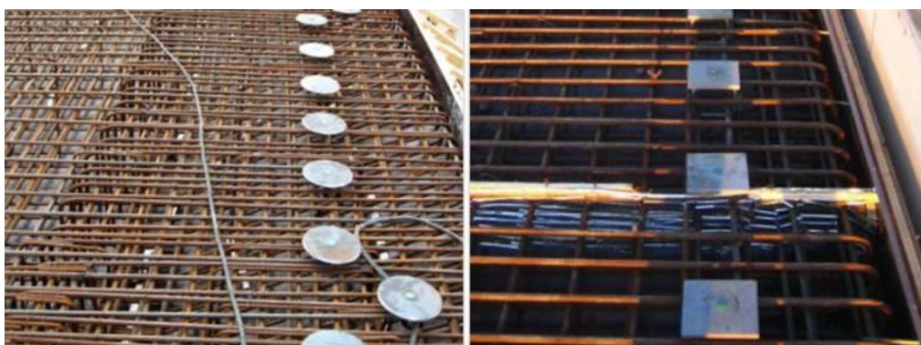
Rys. 7. Mocowanie dolnych części kotew do zbrojenia
