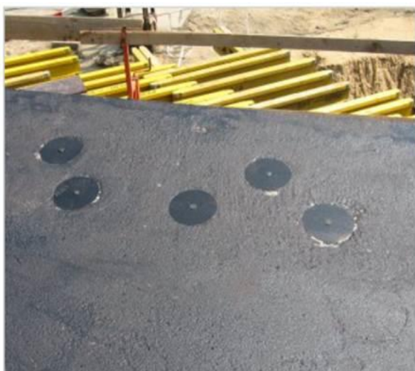
Rys. 8. Zlicowanie dolnego talerza kotwy z powierzchnią betonu ustroju niosącego
