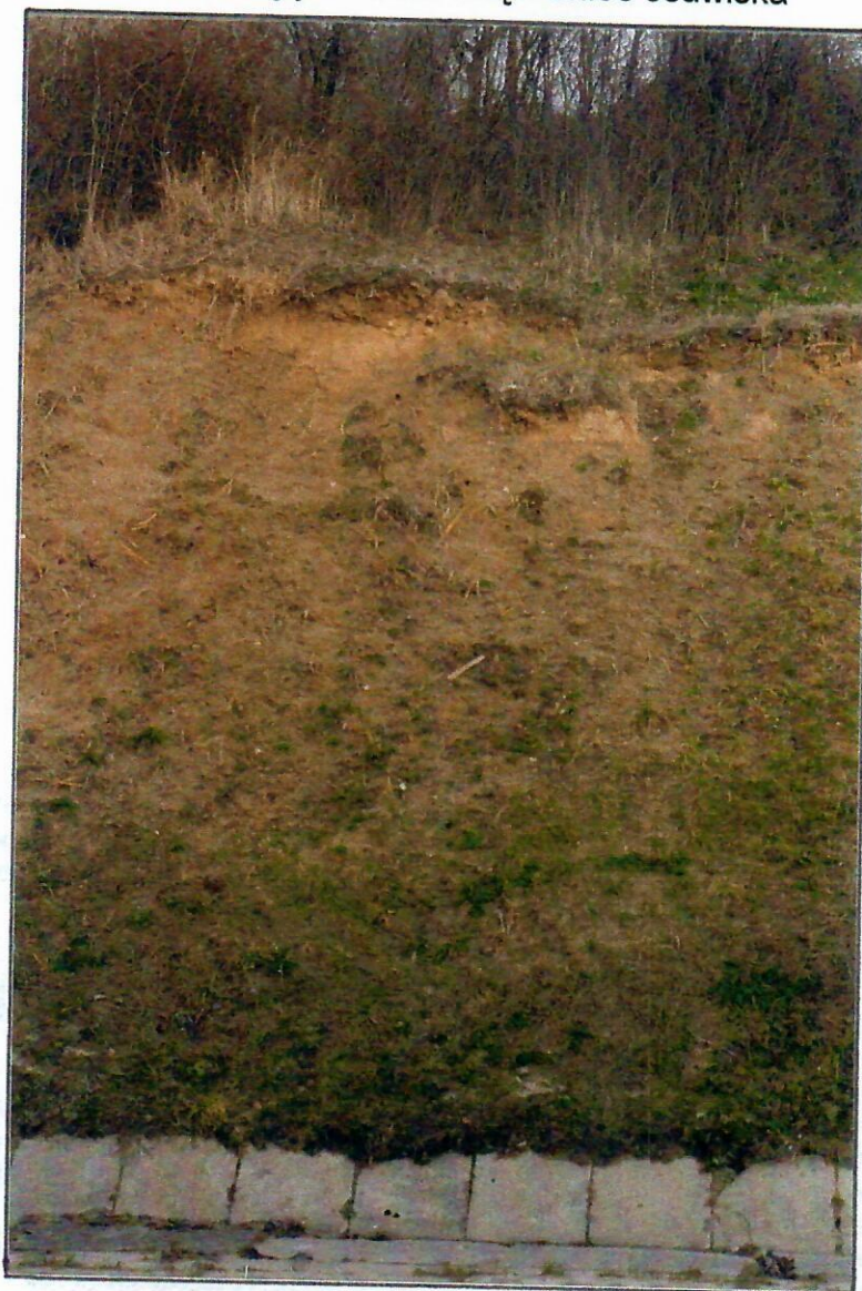
Fot. 5. Niewielki obryw materiału od ostrej krawędzi nad ul. Kazimierza Wielkiego
