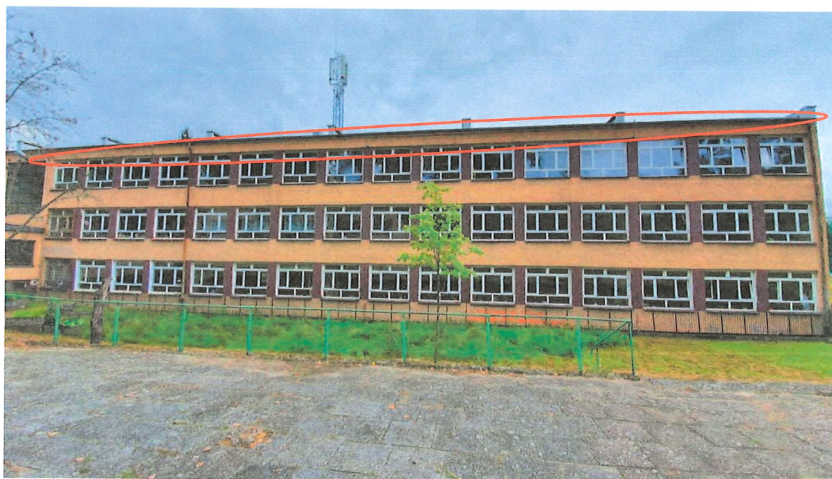
Fot. Nr 6. Budynek główny Szkoły – wystawa zachodnia. Na czerwono zaznaczono niezabezpieczone otwory wentylacyjne stropodachu.
