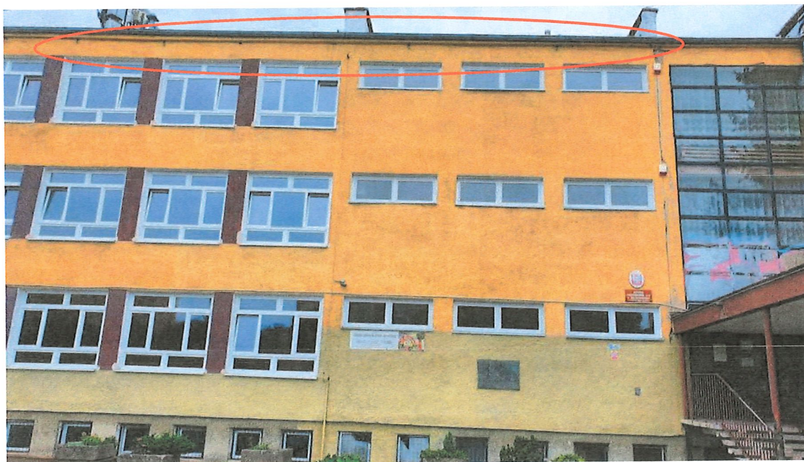
Fot. Nr 2. Elewacja budynku - wystawa wschodnia; ściana w pobliżu wejścia głównego. Na czerwono zaznaczono niezabezpieczone otwory wentylacyjne stropodachu.
