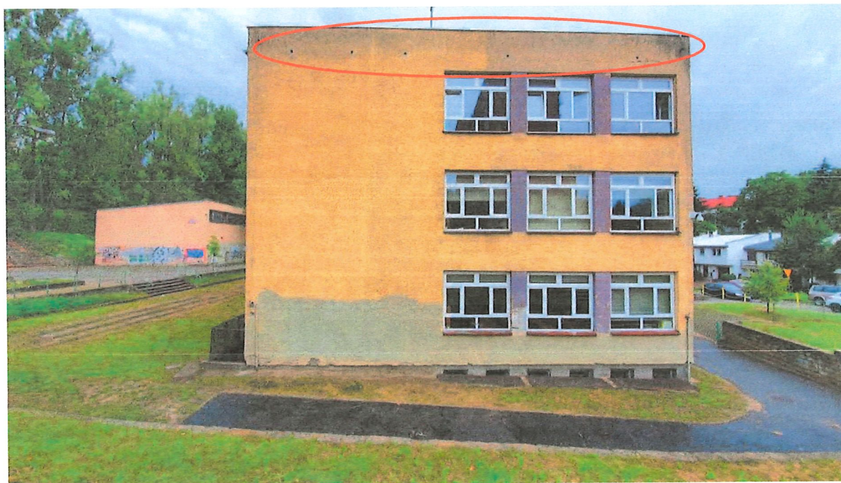
Fot. Nr 7. Budynek główny Szkoły – wystawa południowa. Na czerwono zaznaczono niezabezpieczone otwory wentylacyjne stropodachu.
