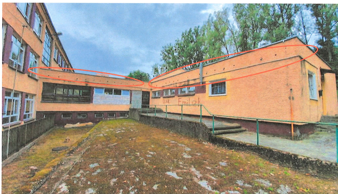
Fot. Nr 4. Widok na łącznik i budynki techniczne Szkoły. Na czerwono zaznaczono niezabezpieczone otwory wentylacyjne stropodachu.
