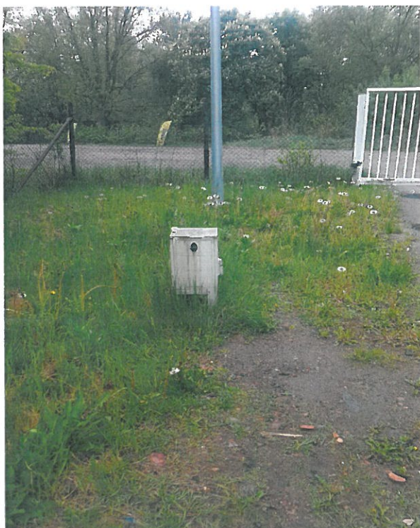
Punkt odczytu nr 1 – brama wjazdowa
