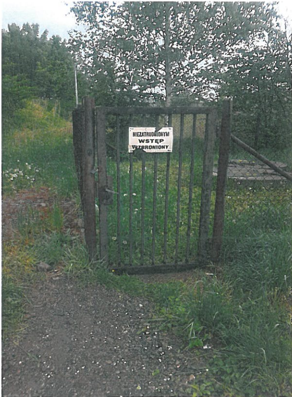
Punkt odczytu nr 5 - przepompownia
