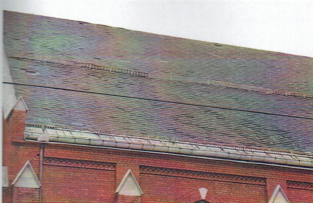
Fot. 1. Zły stan pokrycia płytkami eternitowymi na połaci południowej
