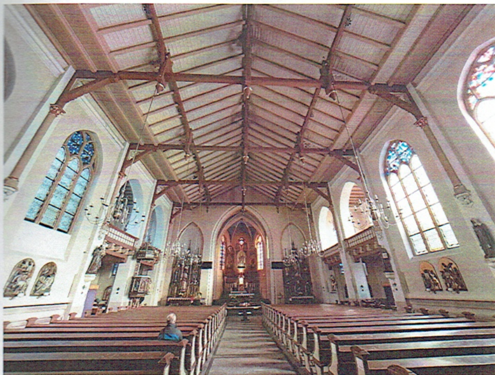
Rys. 2. Widok wnętrza kościoła i stropu nad nawą
