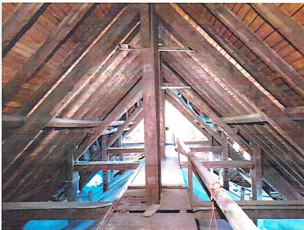
Rys. 3. Widok konstrukcji więźby nad nawą
