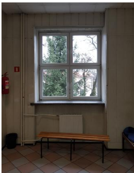
Widok okna do przebudowy na otwór drzwiowy
