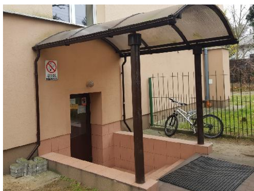
Schody zewn. oraz zadaszenie nad wejściem do rozbiórki
