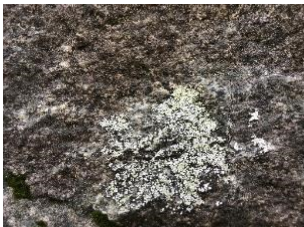
Fot. 48. Porosty pokrywające powierzchnie kamiennych ścian piramidy
