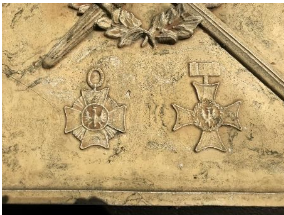
Fot. 57. Tablica inskrypcyjna – widoczne jej pęknięcie, ubytki i zabrudzenia powierzchni
