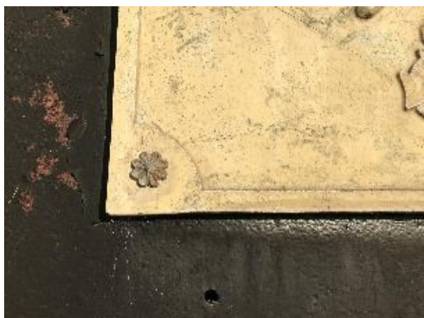
Fot. 59. Dolny narożnik tablicy, śruba mocująca osłonięta żeliwnym kwiatem, korozja drzwi odstonięta w ubytkach warstwy malarskiej
