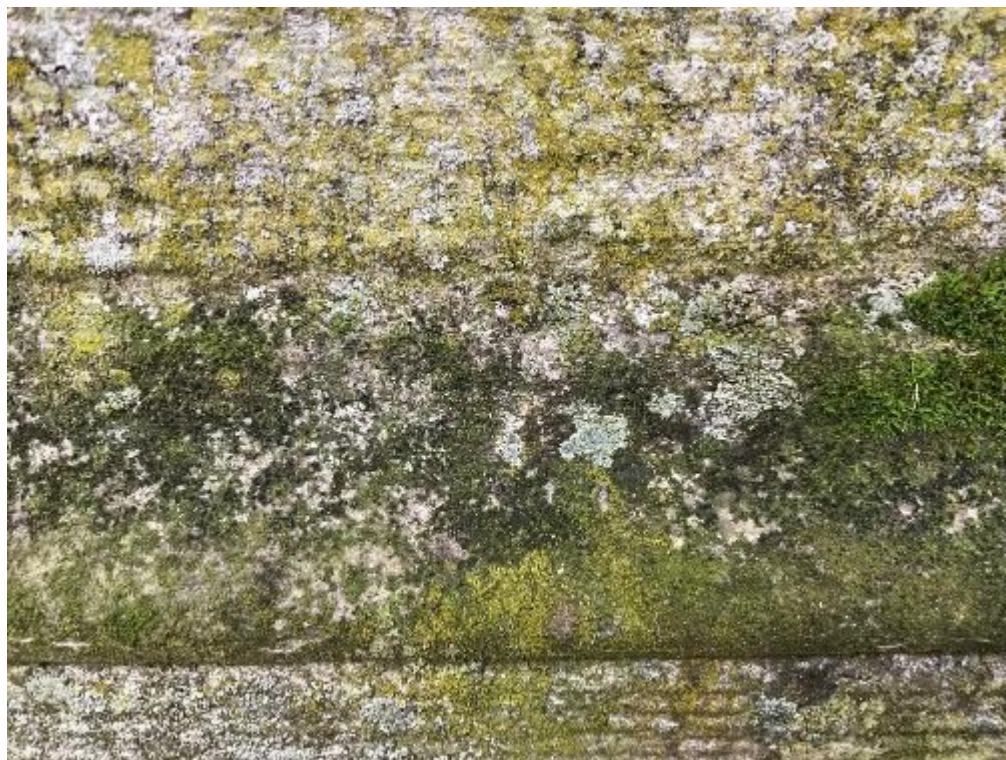
Fot. 64. Powierzchnia dolnej partii filara porośnięta mchami, porostami i glonami
