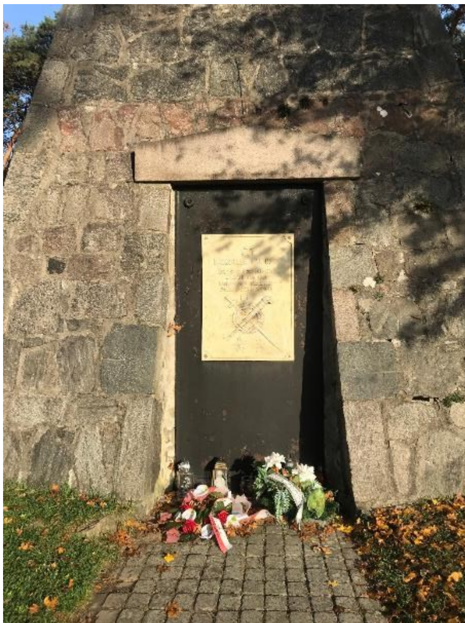
Fot. 43. Zamurowane wejście do piramidy z kamiennym nadprożem i żelaznymi drzwiami oraz tablicą inskrypcyjną
