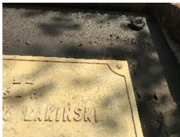
Fot. 60. Górny narożnik metalowych drzwi z ozdobą w formie kutego kwiatu, korozja powierzchni i odpajająca się warstwa malarska
