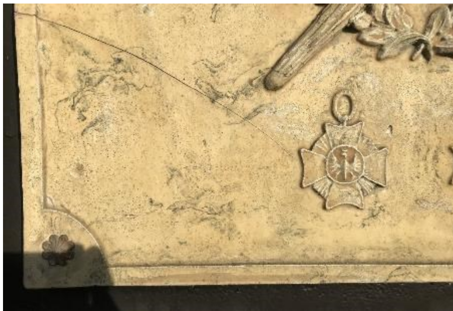
Fot. 36. Płyta nagrobna umieszczona na żelaznych drzwiach, widoczne pęknięcie i uszkodzenia jej powierzchni
