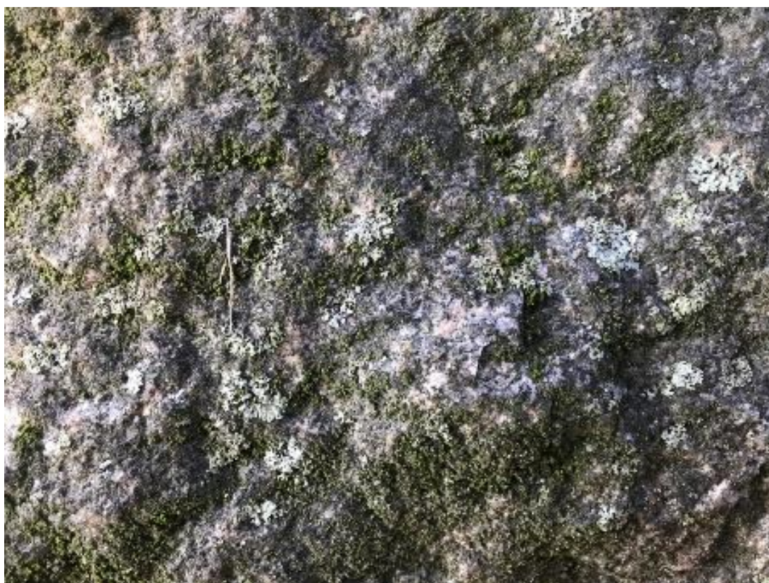
Fot. 50. Mchy i porosty na powierzchni elementów kamiennych muru
