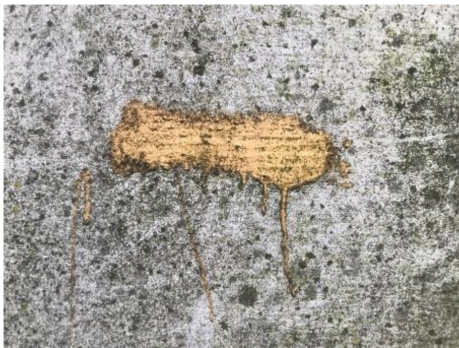
Fot. 63. Zachłapania farbą na tynku
