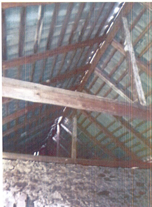
Brak obróbki kalenicy, stan więźby dachowej
