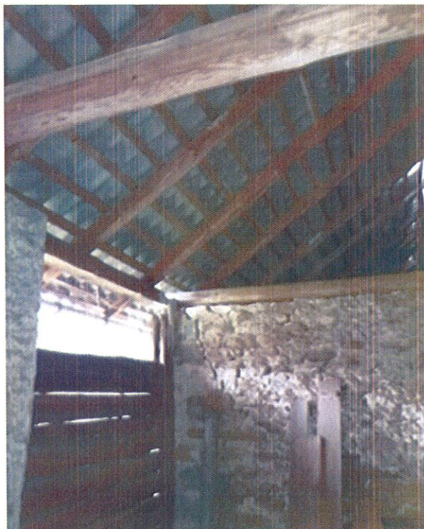
Stan ścian zewnętrznych w części stodoły, widoczne pęknięcie ściany
