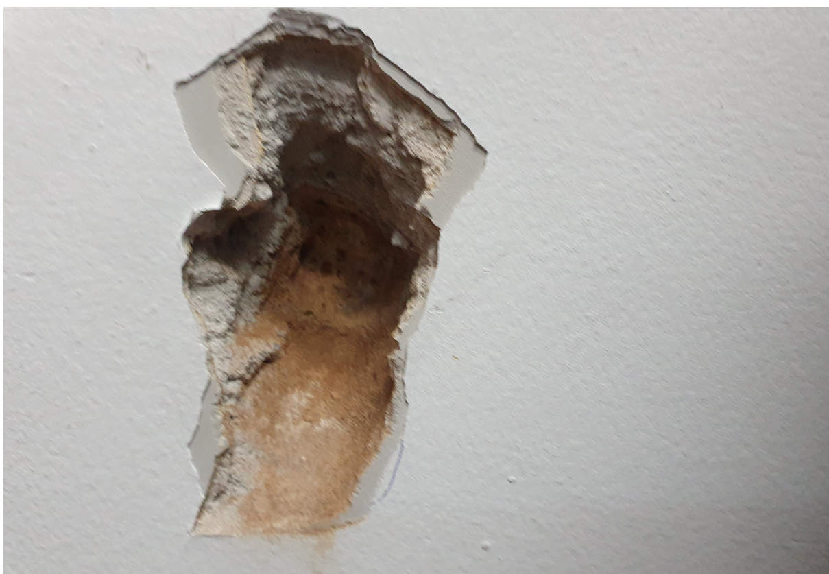
Fotografia numer 6. Odkrywka ściany w miejscu planowanego żurawia montowanego do ściany, widok na tynk i cegłę
