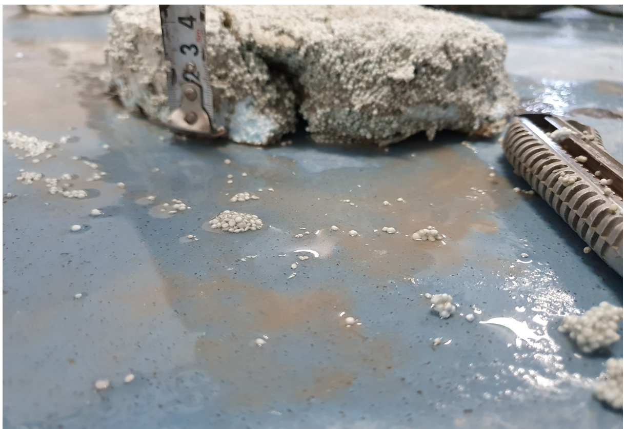
Fotografia numer 4. Widok na warstwę termoizolacji
