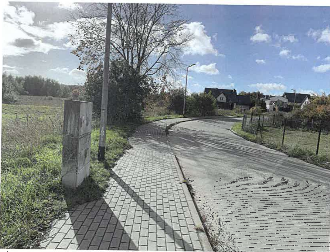
Zdj. Koniec ulicy Działkowej – kolizja z drzewem oraz słupem oświetleniowym.
