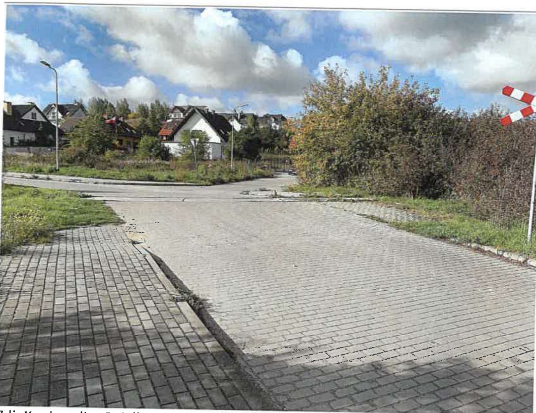
Zdj. Koniec ulicy Działkowej – przejazd kolejowy do likwidacji.
