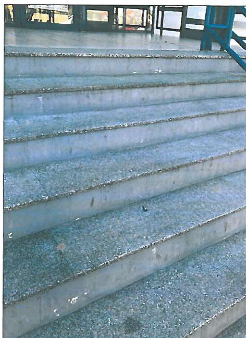
Fot. 11 Posadzka stopni z płyt granitowych, podstopnica betonowa, pokryta powłoką malarską
