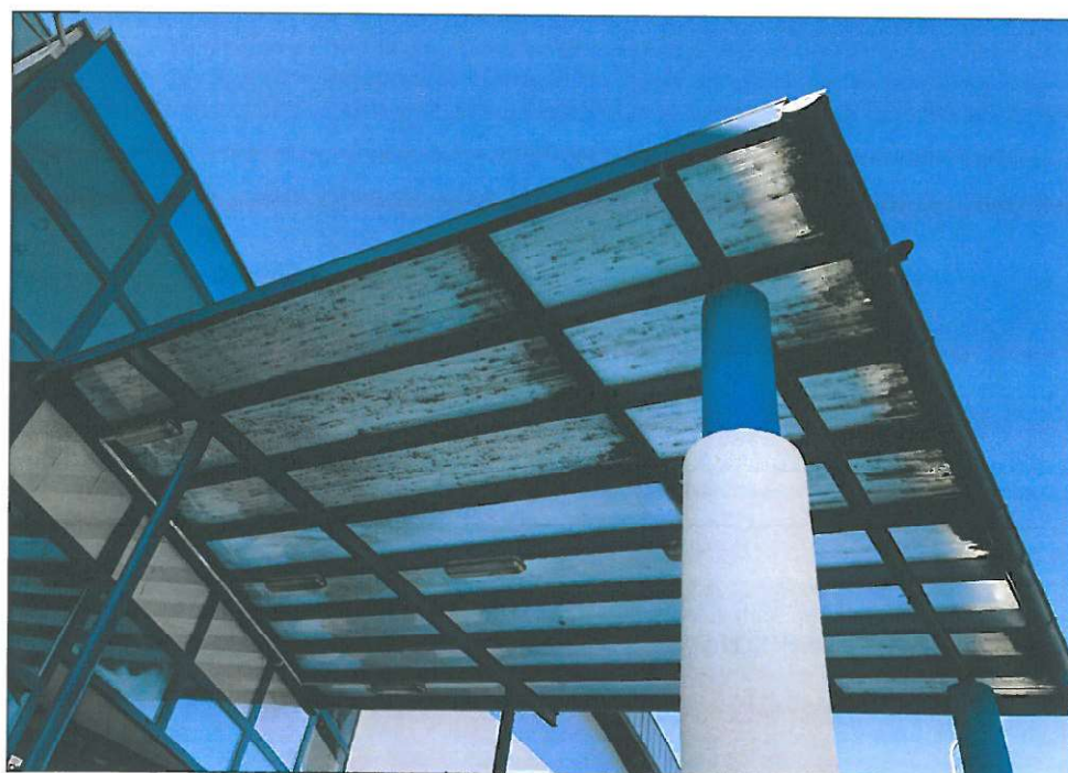
Fot. 9 Zadaszenie wejścia głównego z poliwęglanu komorowego
