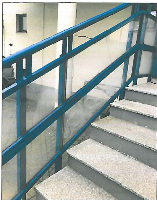
Fot. 10 Barierki stalowe z wypełnieniem z poliwęglanu litego
