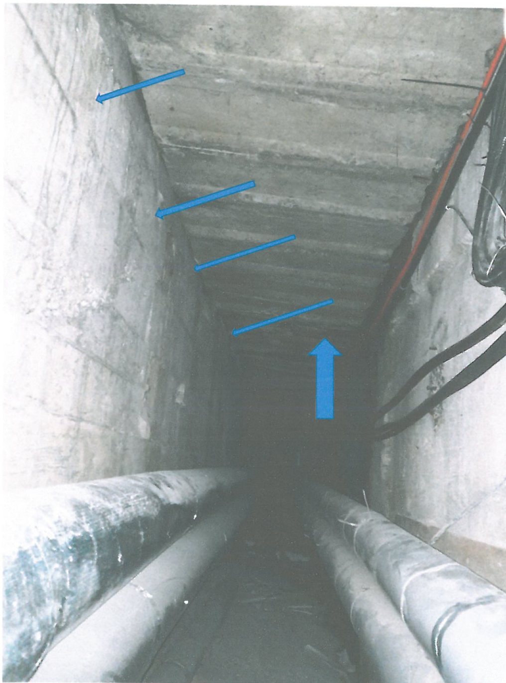
Fot. 4. Tunel żelbetowy nakryty płytami prefabrykowanymi.
