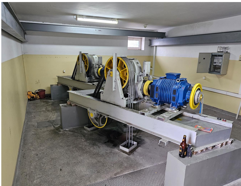
Zdjęcie nr 28 Maszynownia nad szybami windy nr 4 i 5
