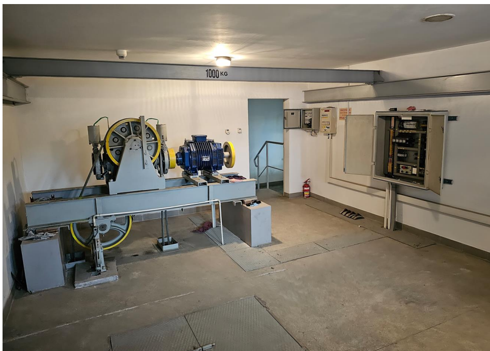
Zdjęcie nr 29 Maszynownia nad szybami windy nr 8 i 9
