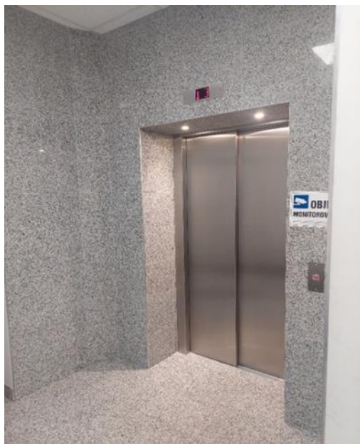
Zdjęcie poglądowe wykończenia wnek i oświetlenia nad wejściem do dźwigu
