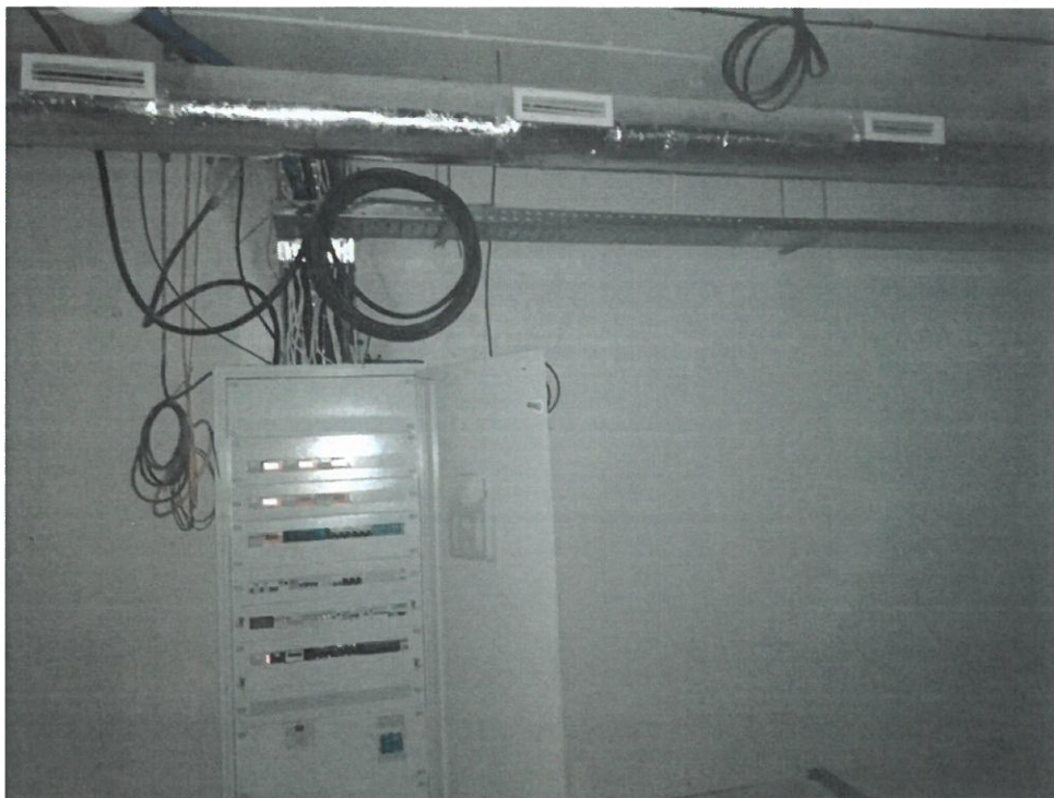
Widok wejścia przyłącza zasilania przez ścianę w piwnicy
