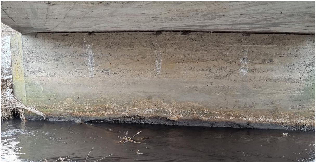
Fot. 9. Podmycie filara od strony północnej
