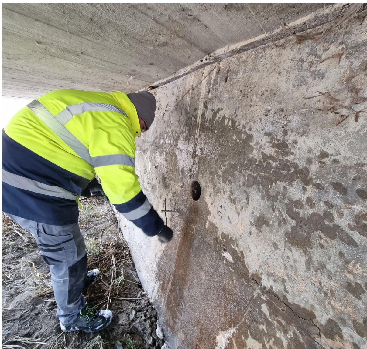
Fot. 24. Rozmontowywanie stanowiska do pobrania próbki nr 1 – z korpusu przyczółka od strony północnej
