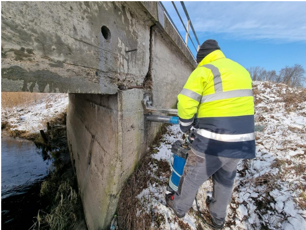
Fot. 26. Widok na miejsce pobrania próbki nr 3 – z ustroju niosącego, oraz pobieranie próbki nr 4 – z przyczółka od strony miejscowości Franciszków
