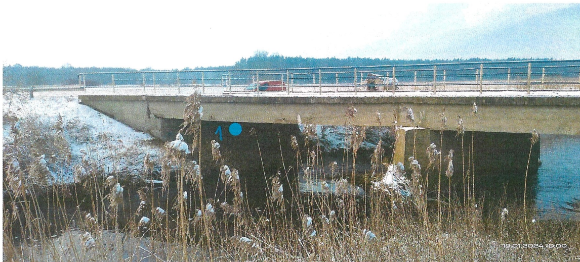
Rys. 1. Most strona wschodnia. Odwiert Nr 1 przyczółek po stronie południowej, podpora nurtowa Odwiert pobrano w środku szerokości przedniej ściany przyczółka na wysokości 62 cm od góry.
