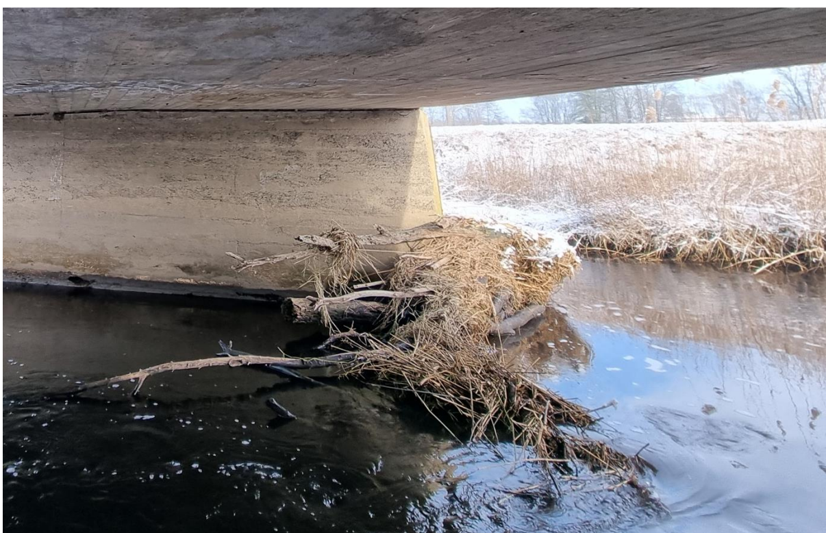
Fot. 22. Zanieczyszczenia organiczne zatrzymujące się na filarze nurtowym
