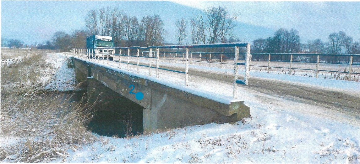
Rys. 3. Most strona zachodnia. Odwierty Nr 2, ustrój nośny po stronie zachodniej. Odwiert Nr 2 pobrano 30 cm od powierzchni dolnej ustroju i 110 cm od końca płyty nośnej ustroju.
