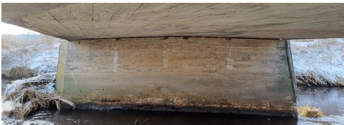
Fot. 15. Widok na spód ustroju od strony północnego przyczółka
