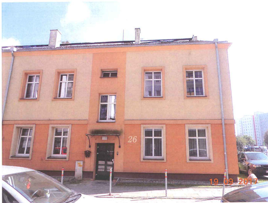
Fot. 2 Widok wejścia do klatki nr 26 od strony podwórza
