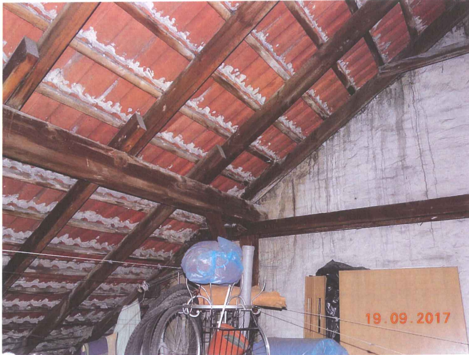
Fot. 6 Widok istn. połaci i płatwi pośredniej.
