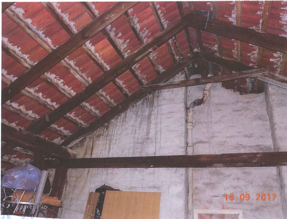
Fot. 4 Widok ściany szczytowej poddasza nr 28
