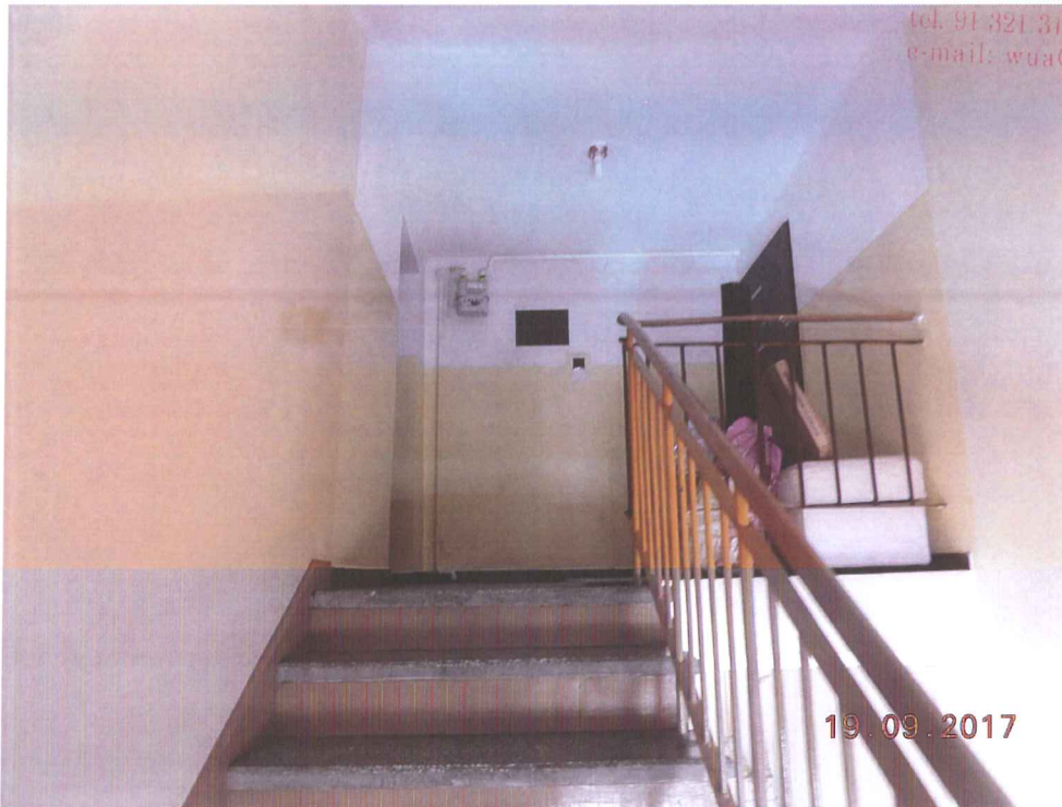
Fot. 10 Widok ogólnodostępnej klatki schodowej poddasza nr 26.
