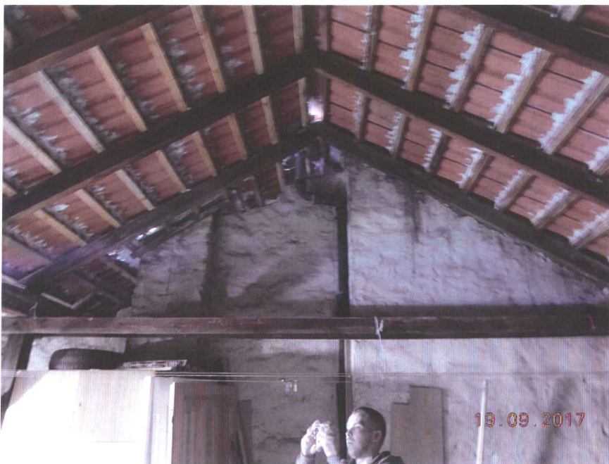
Fot. 11 Widok ściany szczytowej poddasza nr 26
