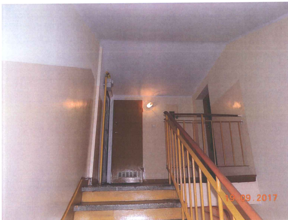
Fot. 3 Widok ogólnodostępnej klatki schodowej poddasza nr 28.
