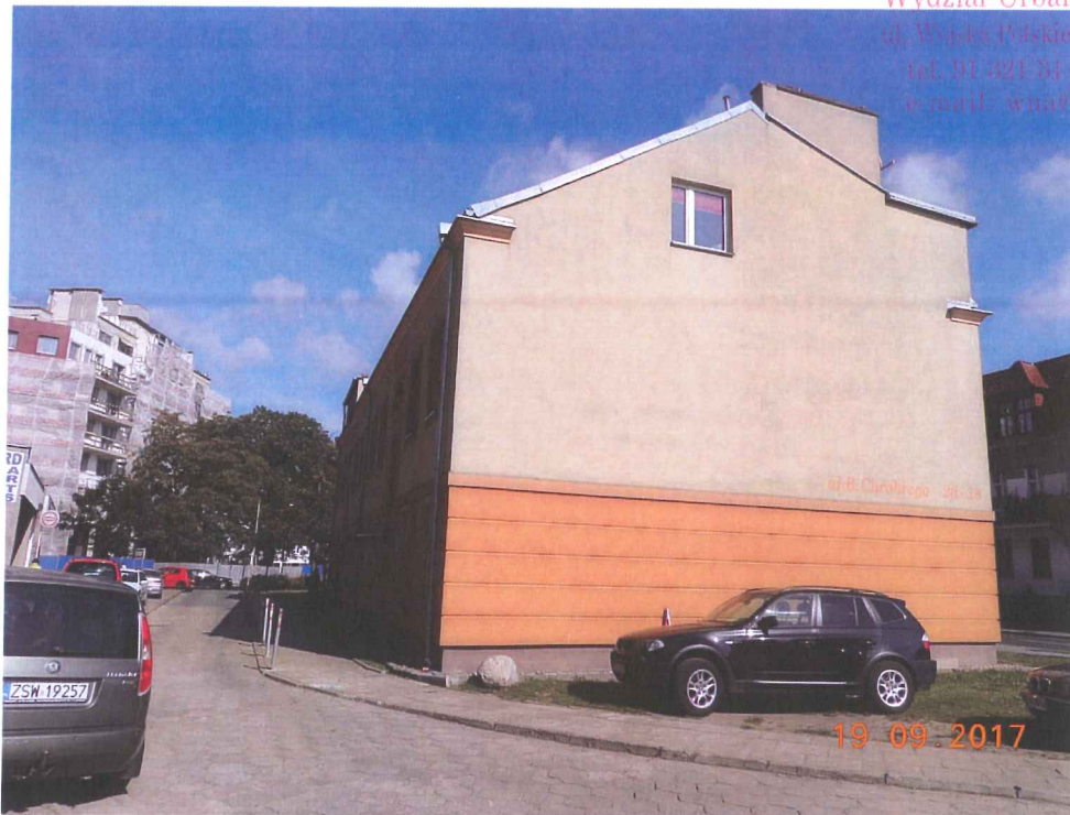
Fot. 8 Widok istn. ściany szczytowej nr 26
