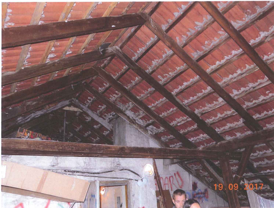
Fot. 5 Widok konstrukcji drewnianej płatwiowo-kleszczowej nr 28.
