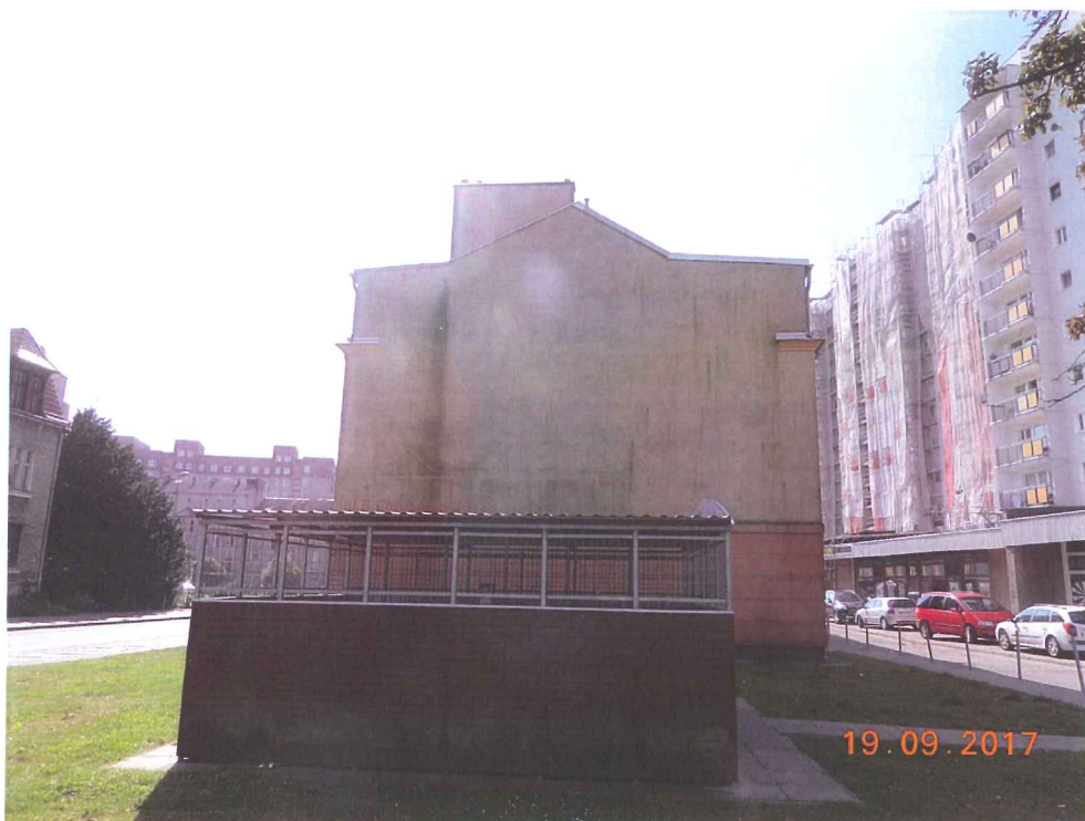
Fot. 9 Widok istn. ściany szczytowej nr 28
