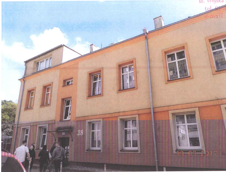
Fot. 2 Widok wejścia do klatki nr 28 od strony podwórza
