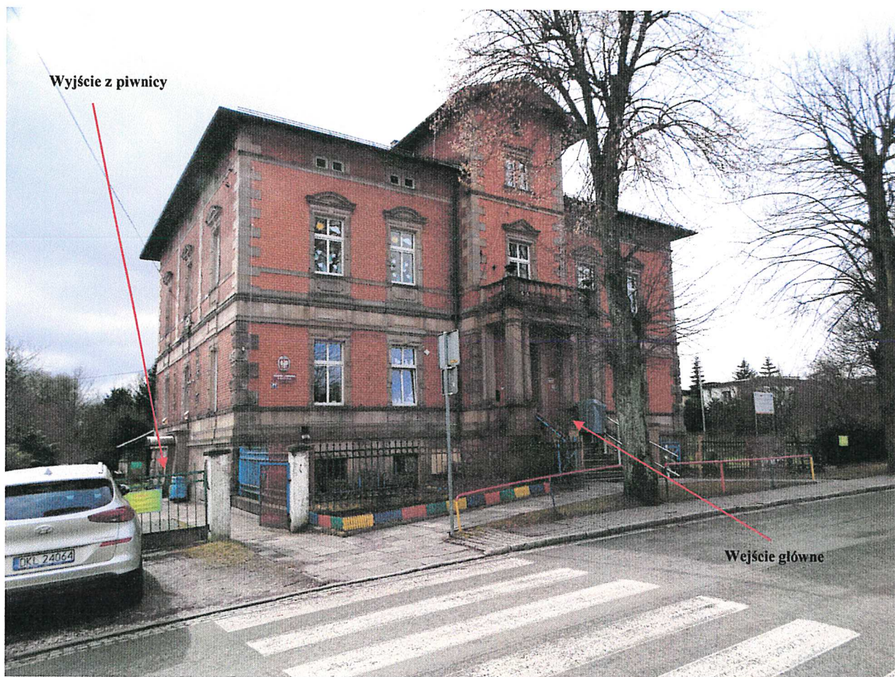
Widok obiektu przedszkola od frontu od strony ulicy Wojska Polskiego
