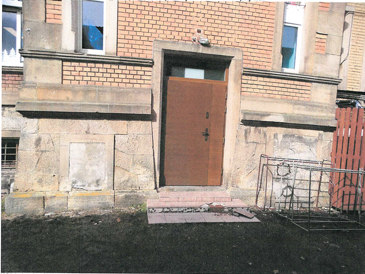
Widok drzwi wyjściowych z klatki schodowej (widoczne schody zewnętrzne zostaną przebudowane)
