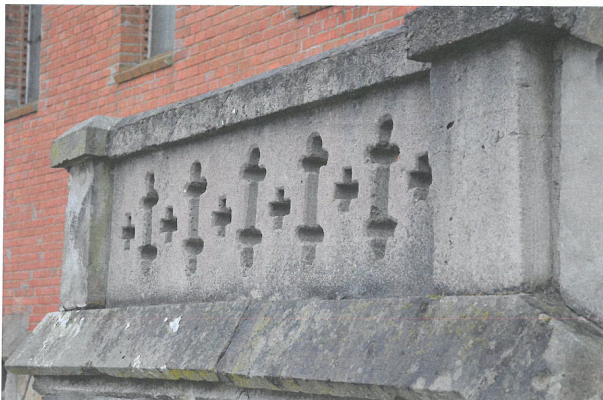
Fot. nr 7, 8. Kaplica grobowa Rodziny Korczak. Widoczne na fotografii silna destabilizacja stopnic schodowych, zabrudzenia powierzchni kamienia, liczne kolonie mikroorganizmów, złamany stopień schodowy, stopień schodowy wykonany w technologii lastryko, wtórny element balustrady wykonany z betonu cementowego.
