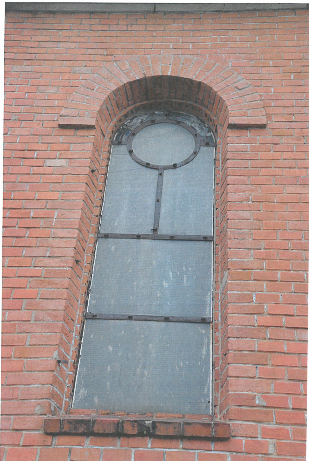
Fot. nr 19. Kaplica grobowa Rodziny Korczak. Widoczne na fotografii korozja elementów stalowych okna kaplicy, wtórne szklenie okien, zachowany witraż w zwieńczeniu okna. Fot. Mariusz Wrona
