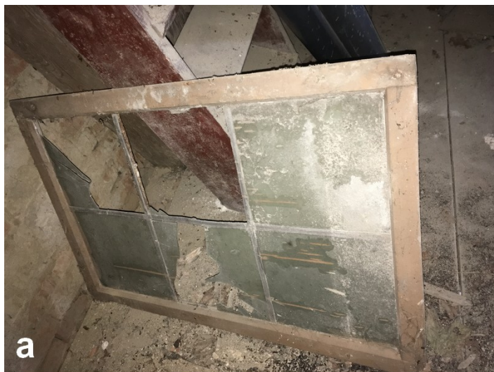
Fot. 41. Zachowane skrzydło stolarki okiennej z 1817 roku (obecnie przechowywane we wieży przy dzwonach), pochodzące prawdopodobnie z jednego z otworów okiennych na wieży
