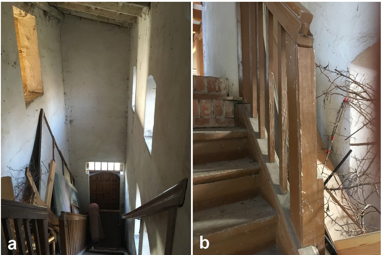
Fot. 33. Osobne zejście z empy na zewnątrz kościoła, z wejściem nad kruchtą wieżową. Schody z I połowy XX w.
