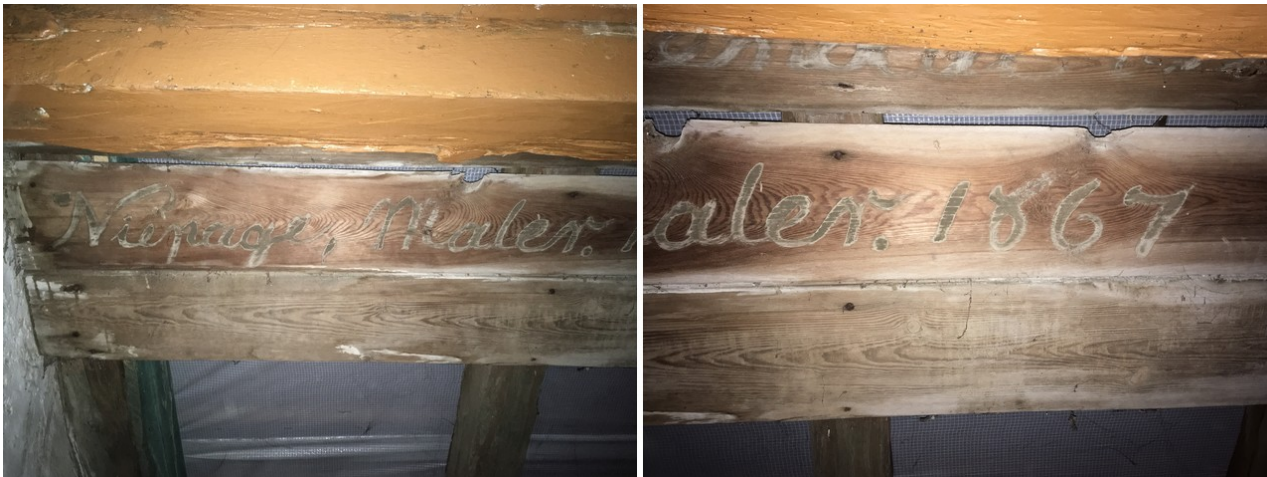
Fot. 23. Jedna z trzech inskrypcji o tej samej treści, znajdujących się na belkach więzby dachowej na poziomie wyższej empyry, pochodzących z 1867 roku i dotyczących jednego z remontów kościoła; częściowo zamalowana
