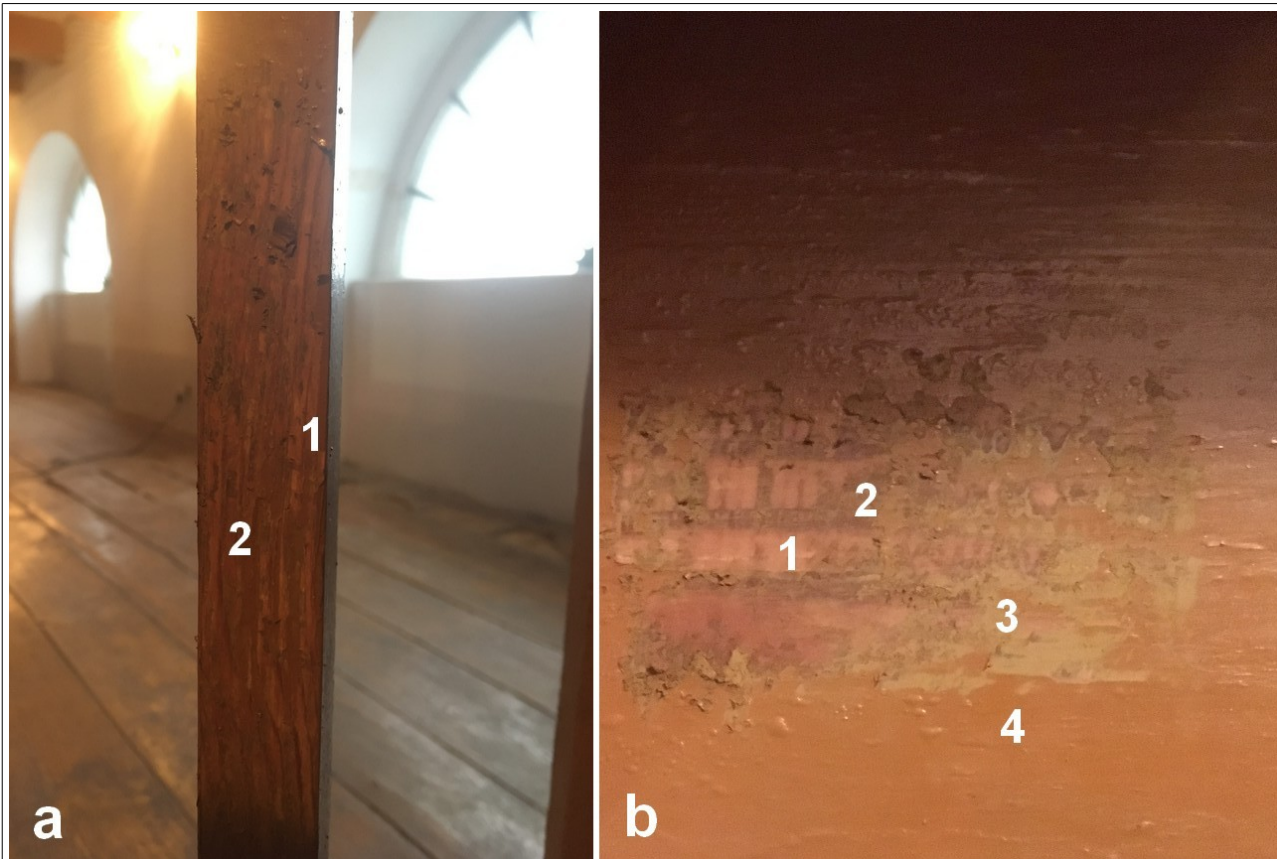
Fot. 28. Odkrywka nr 16 - tralka z poręczy, jak wyżej (a) oraz odkrywka nr 17 czolo stopnia schodów (b): 1 – drewno, I połowa XX w., 2 – beżowa warstwa malarska syntetyczna, II połowa XX w., 3 – żółta warstwa malarska, II połowa XX w., 4 – obecne przemalowanie
