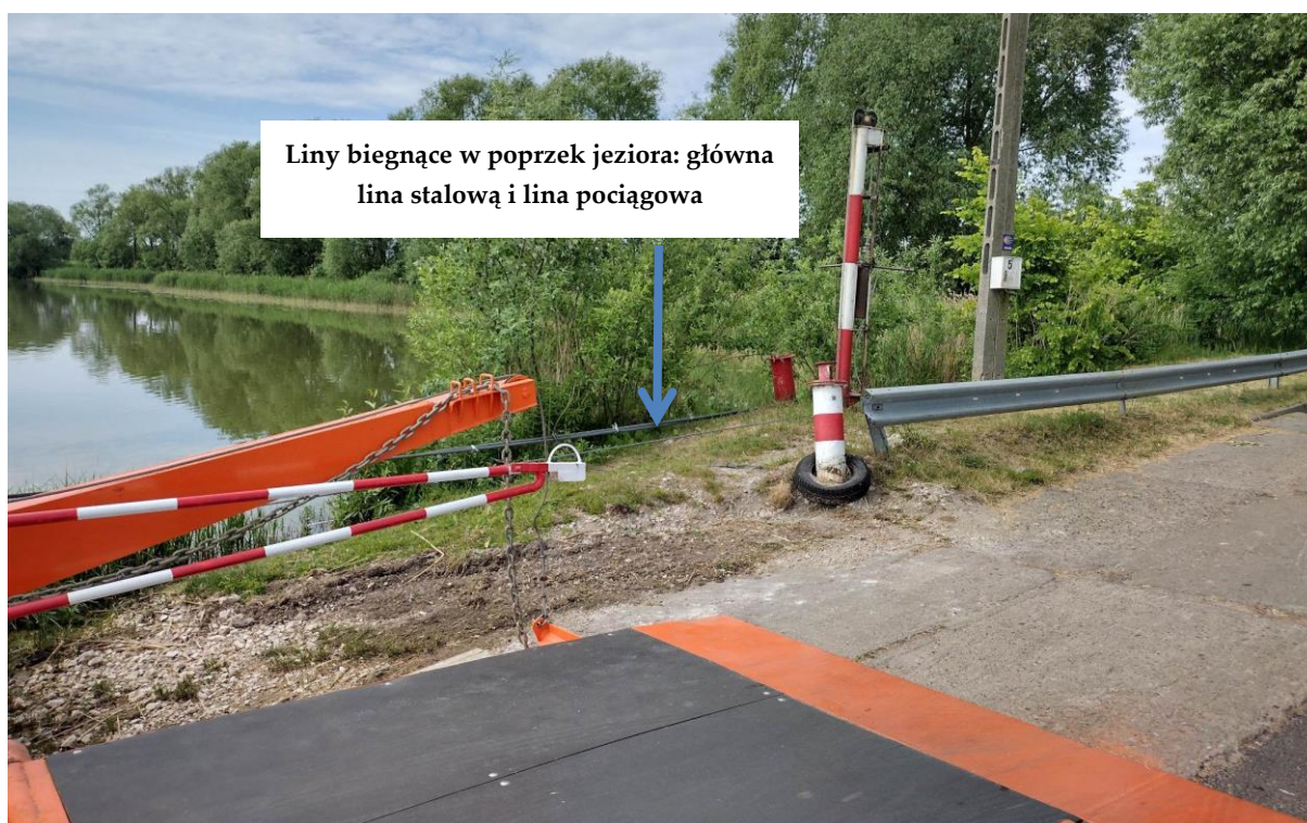
Fotografia 4. Przyczółek lewy (brzeg lewy w m. Ostrówek). Liny biegnące w poprzek jeziora: główna lina stalowa i lina pociągowa - działka o nr ewid. 1, obręb 0049 Złotowo, województwo kujawsko-pomorskie, powiat inowrocławski (fot. z dnia 06.06.2023).
