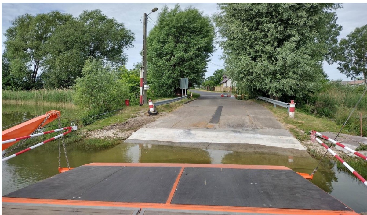
Fotografia 2. Przyczółek lewy (brzeg lewy zachodni) działka o nr ewid. 1 wraz z drogą dojazdową - działka o nr ewid. 47/2, obręb 0027 Ostrówek, województwo kujawsko-pomorskie, powiat inowrocławski (fot. z dnia 06.06.2023).
