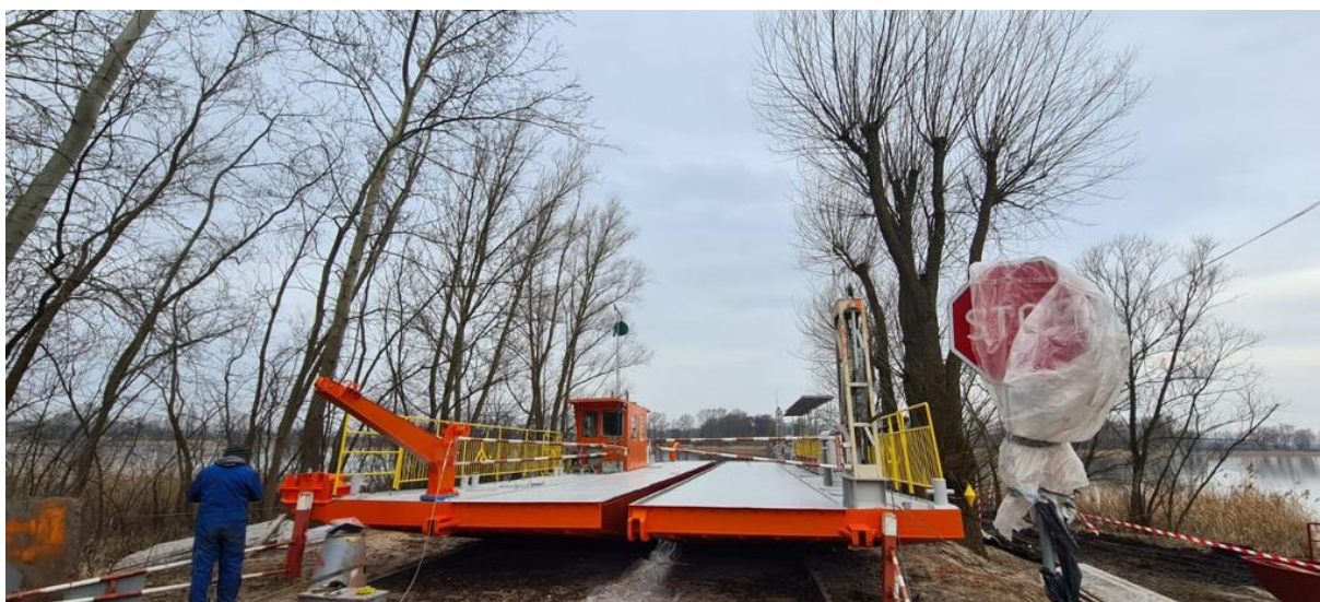
Fotografia 9. Prom OSTRÓWEK II w trakcie prac modernizacyjnych (fot. z dnia marca 2023).
