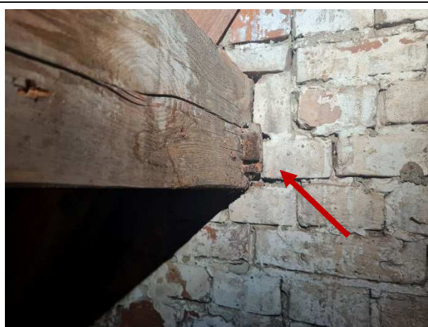
Fot.14. Widok przykładowego zachowanego w dobrym stanie gniazda parcia belki na murze- widoczny brak izolacji elementu.
