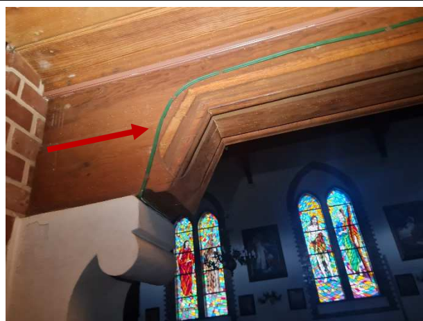
Fot.16. Widok fragmentu aluminiowej instalacji elektrycznej kościoła, instalację należy wymienić na miedzianą z użyciem rur osłonowych.
