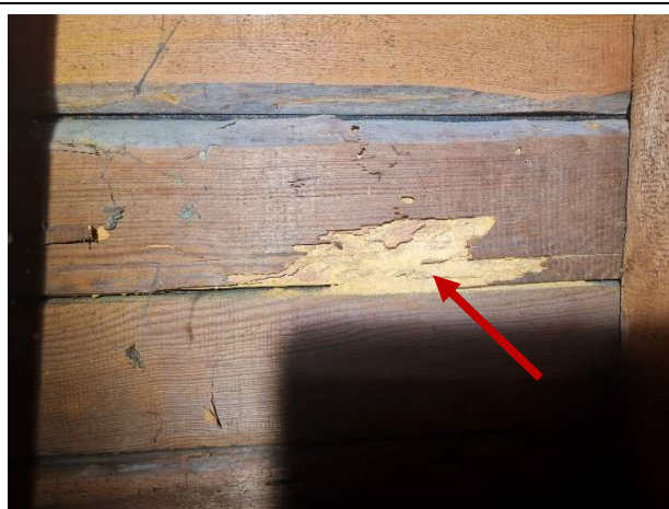
Fot.3. Widok ubytków w materii budowlanej, wywołanych przez porażenie spuszczem i kołatką.
