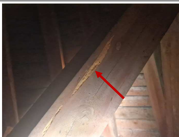
Fot.8. Widok śladów porażenia spuszczel – widoczne korytarze wydrążone przez spuszczel.
