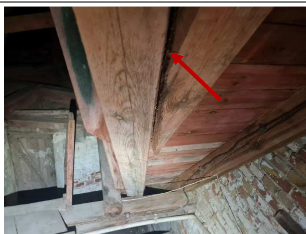
Fot.10. Widok złącza ciesielskiego które się rozeszło z biegiem czasu. Widoczne ślady po przeprowadzonej w przeszłości impregnacji drewna.
