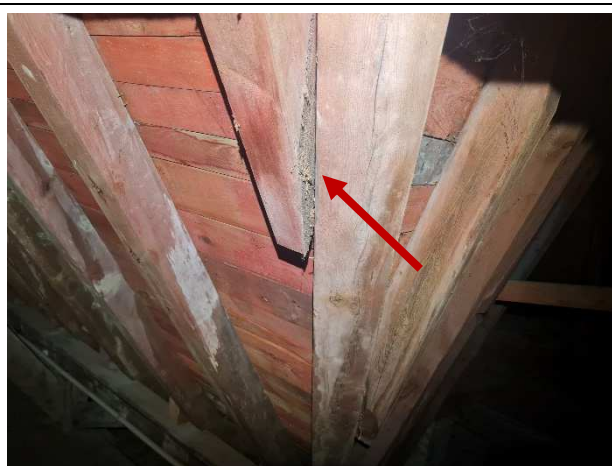
Fot.9. Widok złącza ciesielskiego bez pełnego styku połączenia- należy wykonać prawidłowo..
