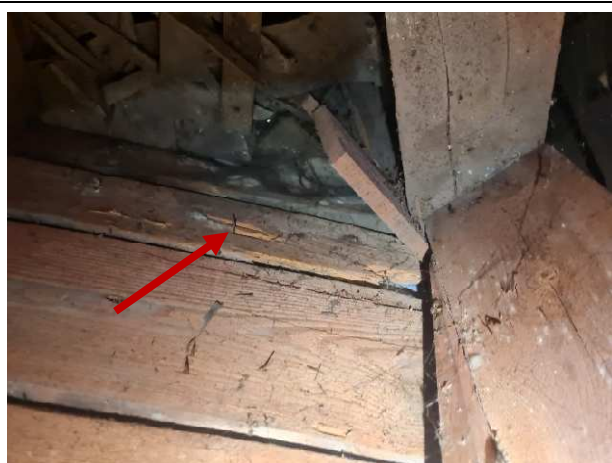
Fot.11. Widok korozji biologicznej materii budowlanej, aktywne żerowisko kołatka.
