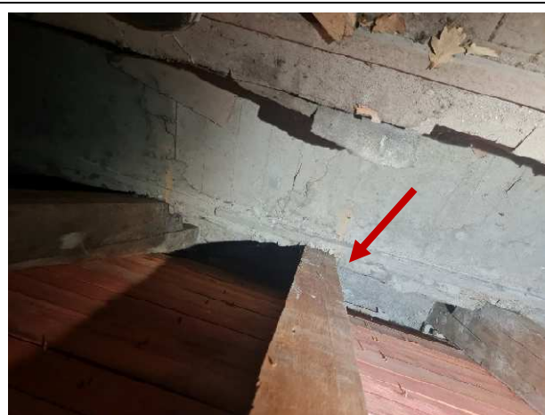
Fot.13. Widok przykładowych zachowanych w dobrym stanie gniazd przejścia krokwi w wieńcu żelbetowym- widoczny brak izolacji elementu.
