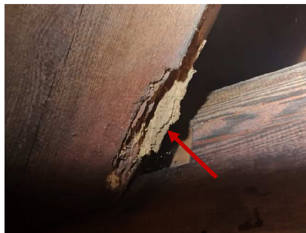
Fot.6. Widok korozji biologicznej materii budowlanej, aktywne żerowisko pasożytów.
