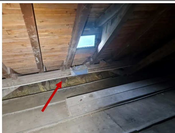
Fot.12. Widok pozostałości po nieprawidłowym izolowaniu el. drewnianych krokwi pianą PU.
