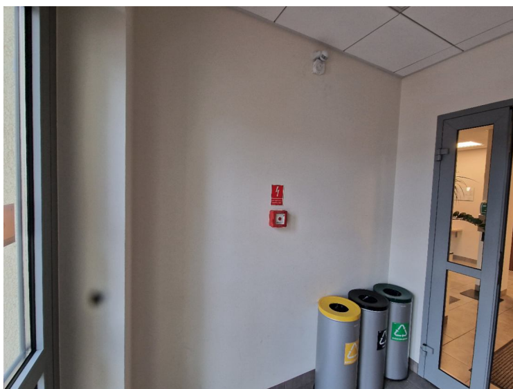
Zdjęcie. Istniejący PWP w budynku Wilanowska 2A.
