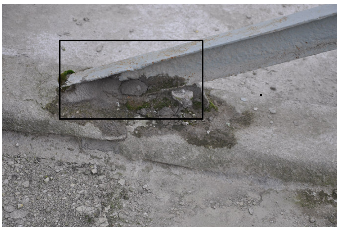
Fot.4 węzeł podporowy przyścienny
