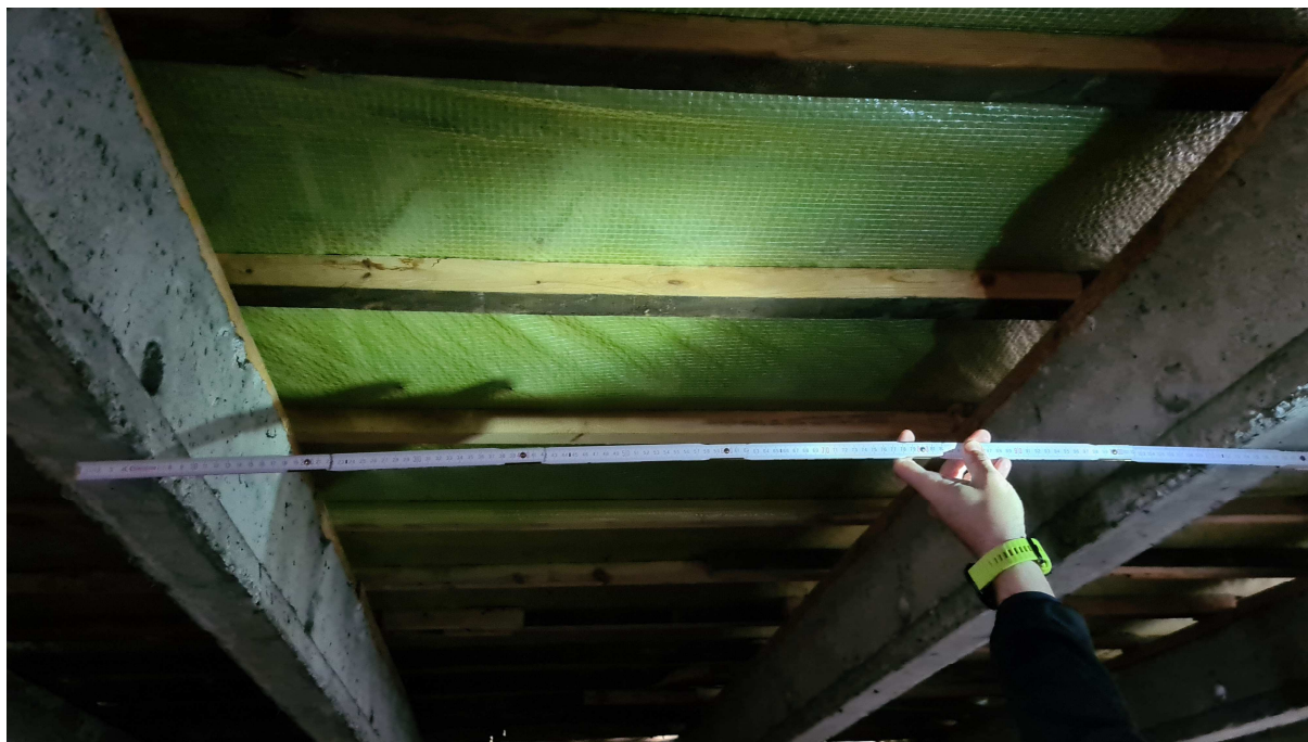
Fot. 4. Widok fragmentu konstrukcji nośnej dachu w budynku głównym szkoły z żelbetowych krokwi (belek stropu DZ) w średnim osiowym rozstawie co 1,15m. Widoczne jest również niewłaściwe ułożenie warstw pokrycia dachowego. Folia paroprzepuszczalna ułożona jest nad drewnianym ruszcie z łąt i kontrłąt, bezpośrednio pod pokryciem dachowym z blachodachówki.
