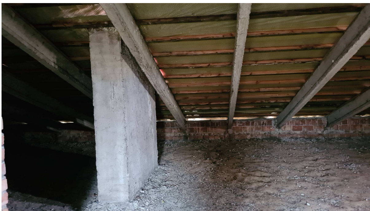
Fot. 3. Widok fragmentu poddasza nieużytkowego, znajdującego się w budynku głównym szkoły. Widoczna jest izolacja termiczna żelbetowego stropu w postaci polepy/zasyпки grubości 20-30cm.
