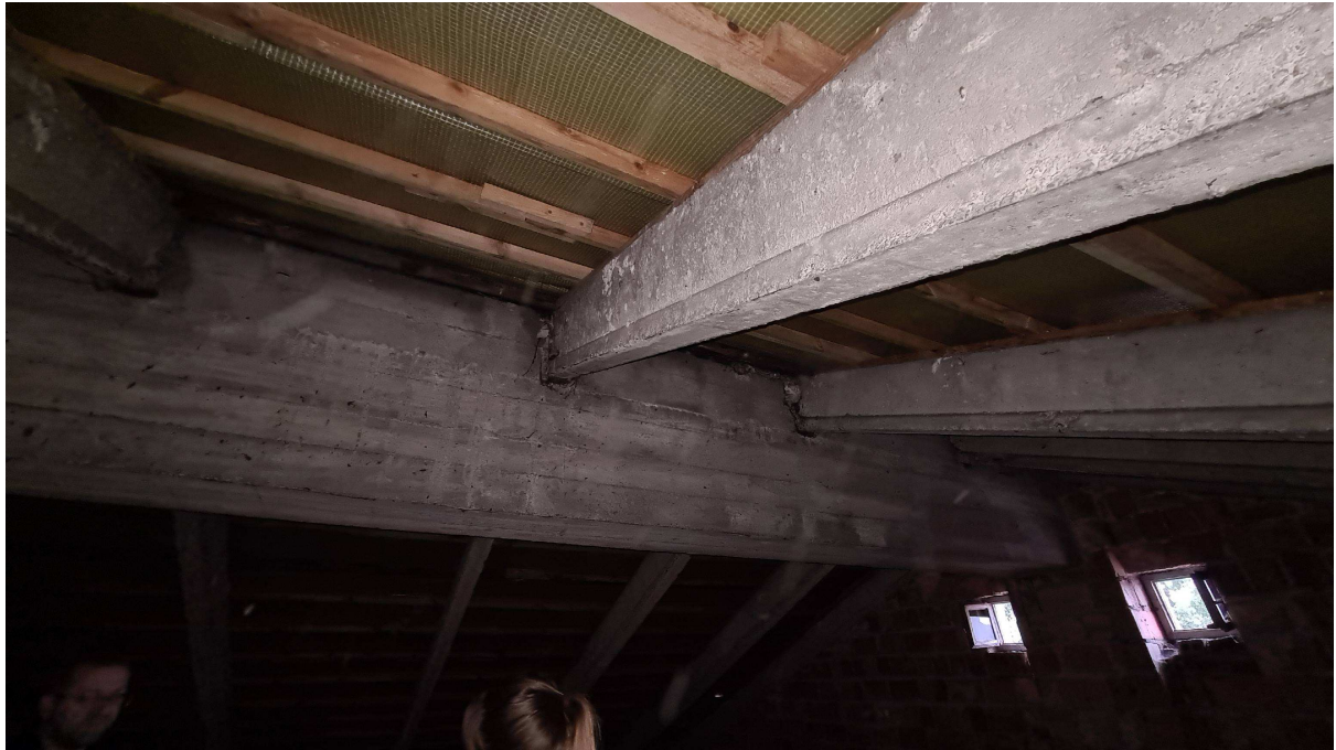
Fot. 6. Widok oparcia żelbetowych krokwi (belek stropu DZ) w kalenicy na żelbetowym podciągu o przekroju 40x80cm.
