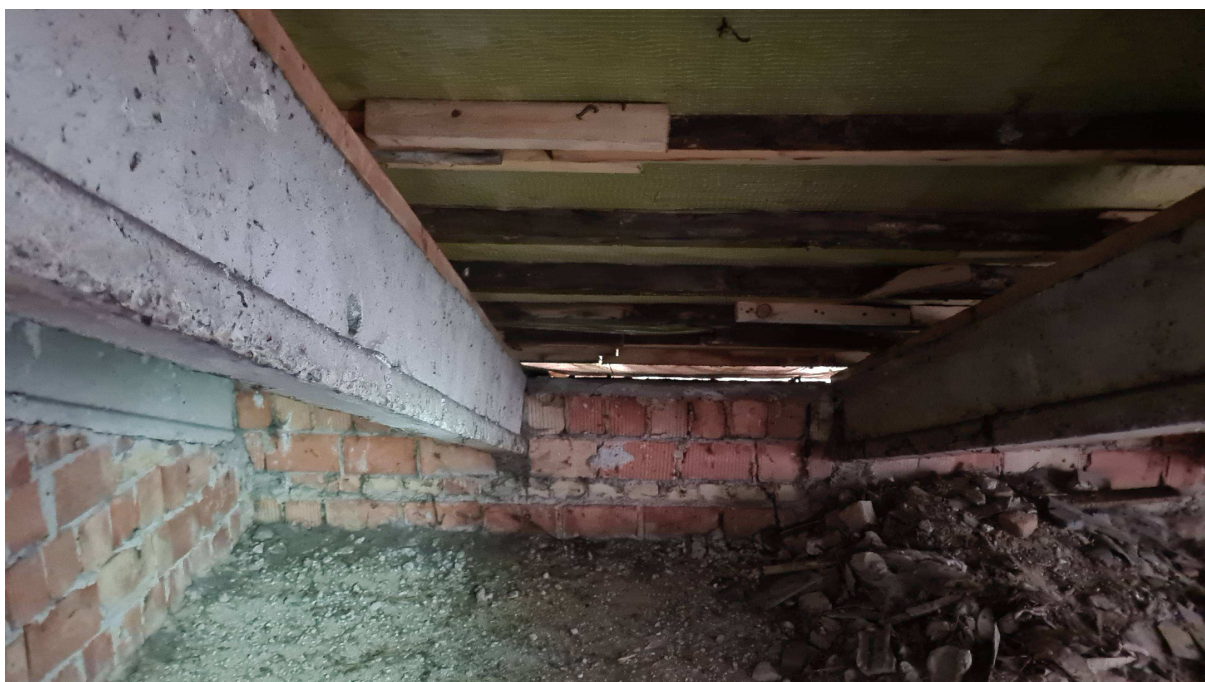
Fot. 5. Widok oparcia żelbetowych krokwi (belek stropu DZ) bezpośrednio na ścianie zewnętrznej z cegły ceramicznej kratówki. Widoczne jest również sztukowanie drewnianych łąt, niezgodne ze sztuką budowlaną.
