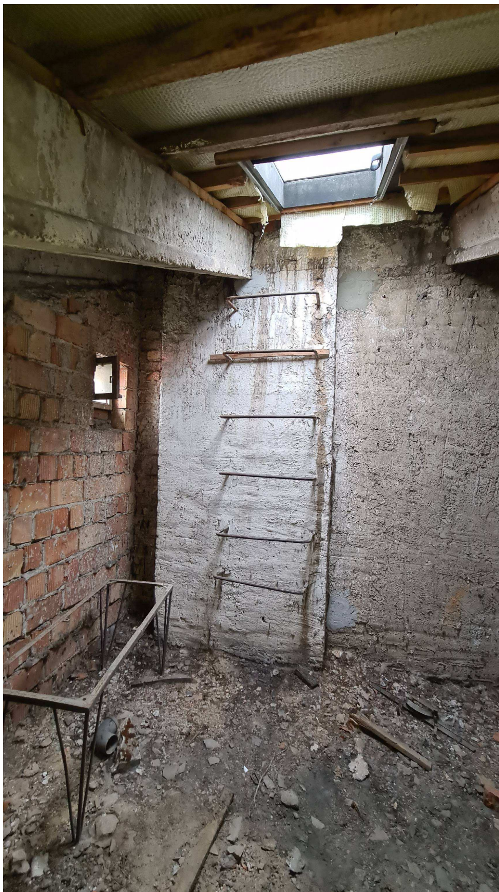
Fot. 7. Widok wyłazu dachowego znajdującego się na dachu budynku głównego szkoły. Ze względu na miejscowe przecieki potaci dachowej, na kominach widoczne są trwałe ślady zacieków. Widoczna jest również niewłaściwie przymocowana/uszkodzona folia paroprzepuszczalna.
