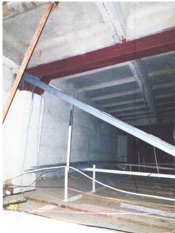
Zdjęcie 3 Aula – widok na sufit podwieszany z płyt wiórowych w okleinie naturalnej łączonych na pióro oraz stelaż z teownika T80 w rozstawie ok 1,4m.
