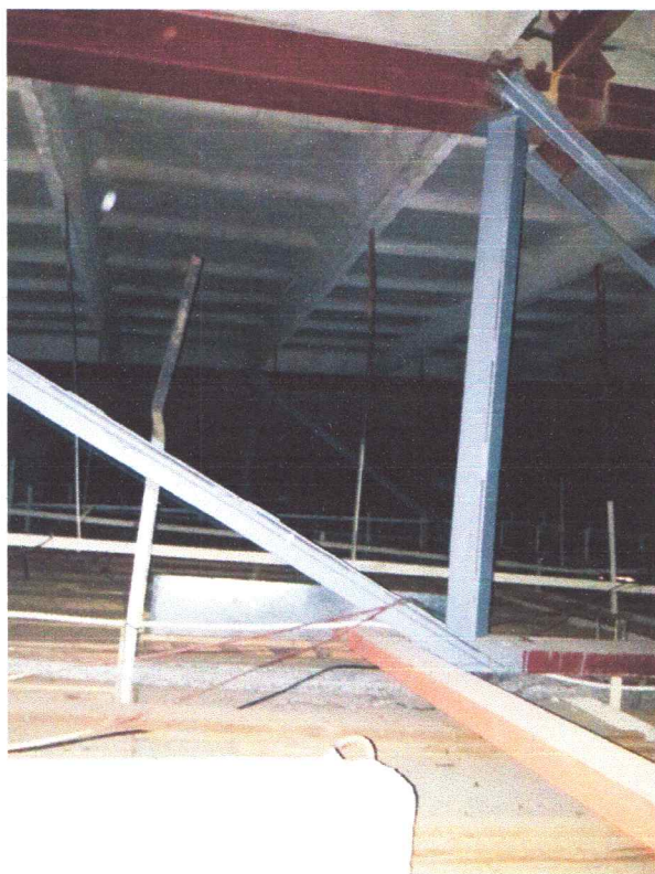
Zdjęcie 3 Aula – widok na sufit podwieszany z płyt wiórowych w okleinie naturalnej łączonych na pióro oraz stelaż z teownika T80 w rozstawie ok 1,4m.
