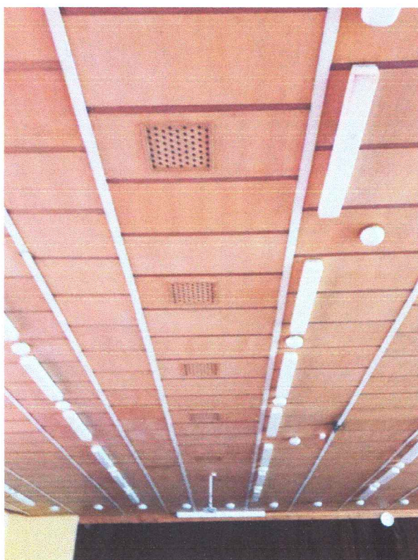
Zdjęcie 3 Aula – widok na sufit podwieszany z płyt wiórowych w okleinie naturalnej łączonych na pióro oraz stelaż z teownika T80 w rozstawie ok 1,4m.
