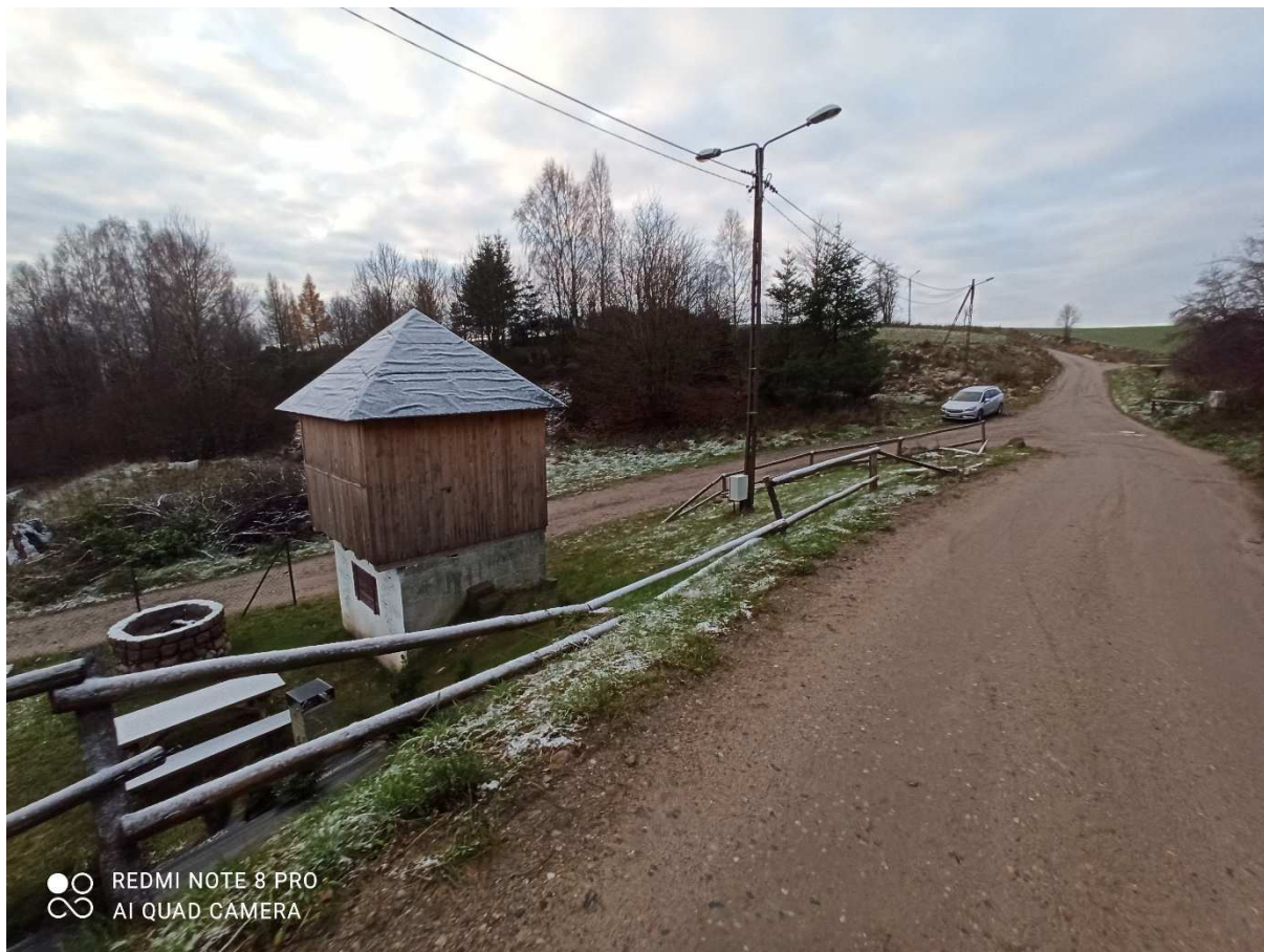
Fot. nr 1 - Widok na istniejący słup nr 112 linii napowietrznej wraz z zejściem kablowym (Reszki).
