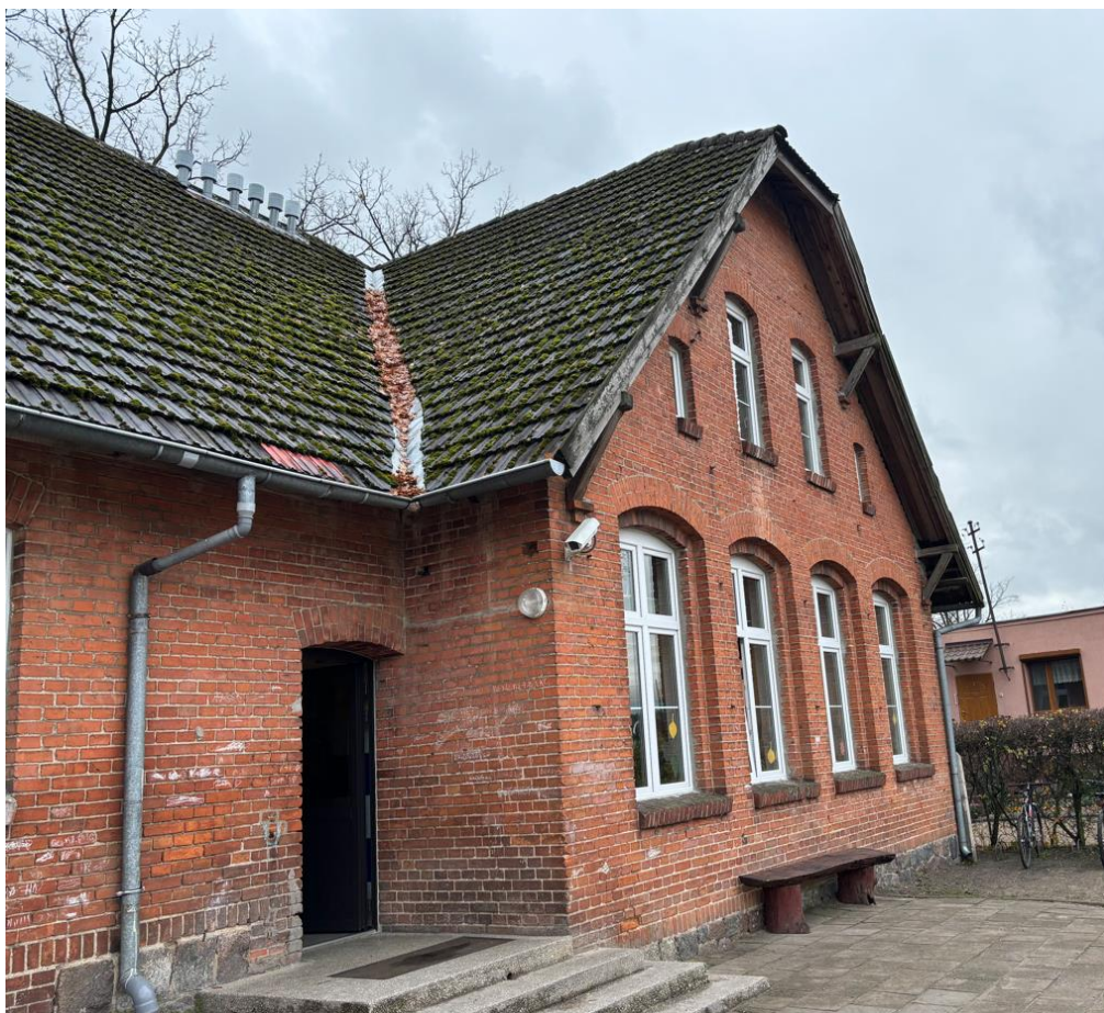
fot. 4. widok dachu budynku ze złym stanem opierzeń oraz orynowowania
