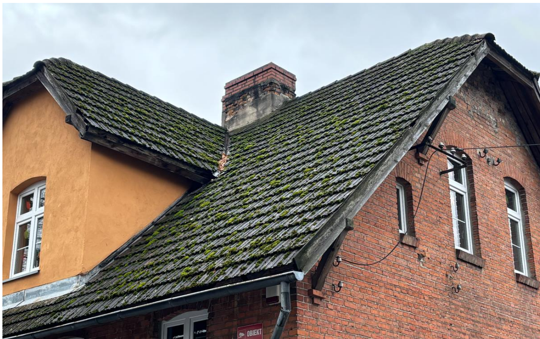
fot. 7. widok komina ze złym stanem okładziny tynkarskiej
