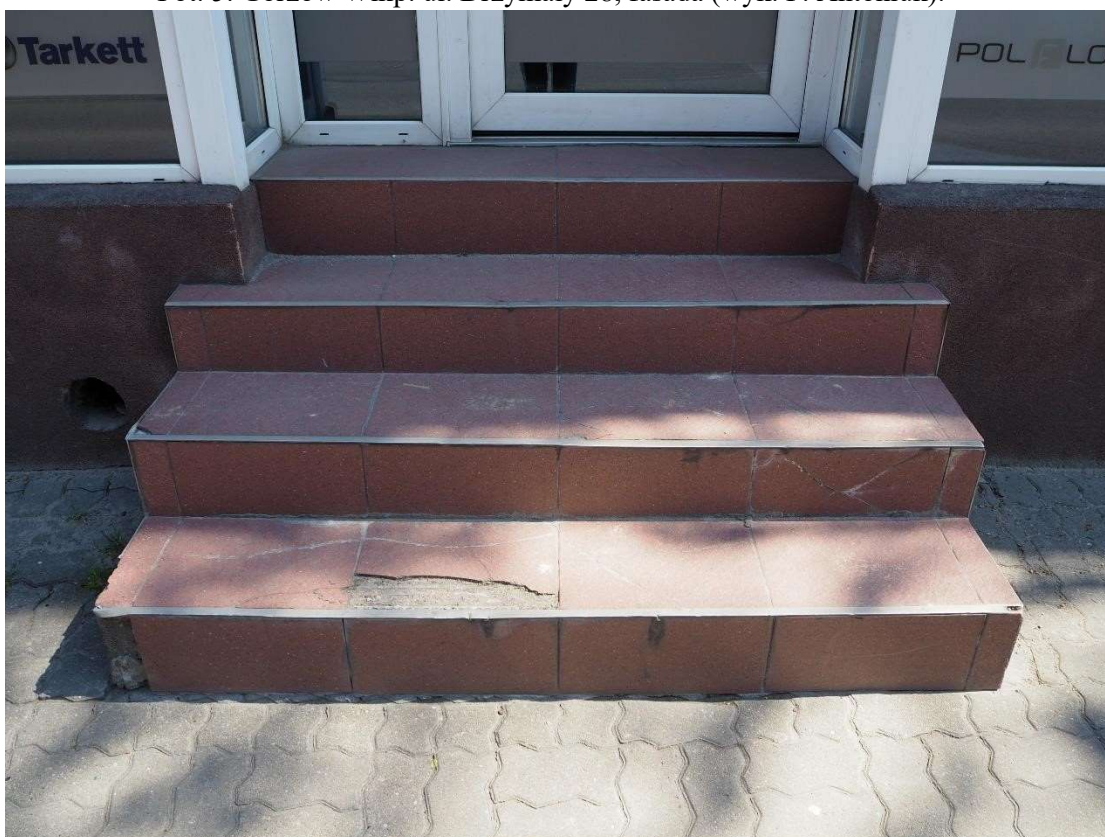
Fot. 6. Gorzów Wlkp. ul. Drzymały 28, fasada, schody prowadzące do sklepu (wyk. P. Antoniuk).
