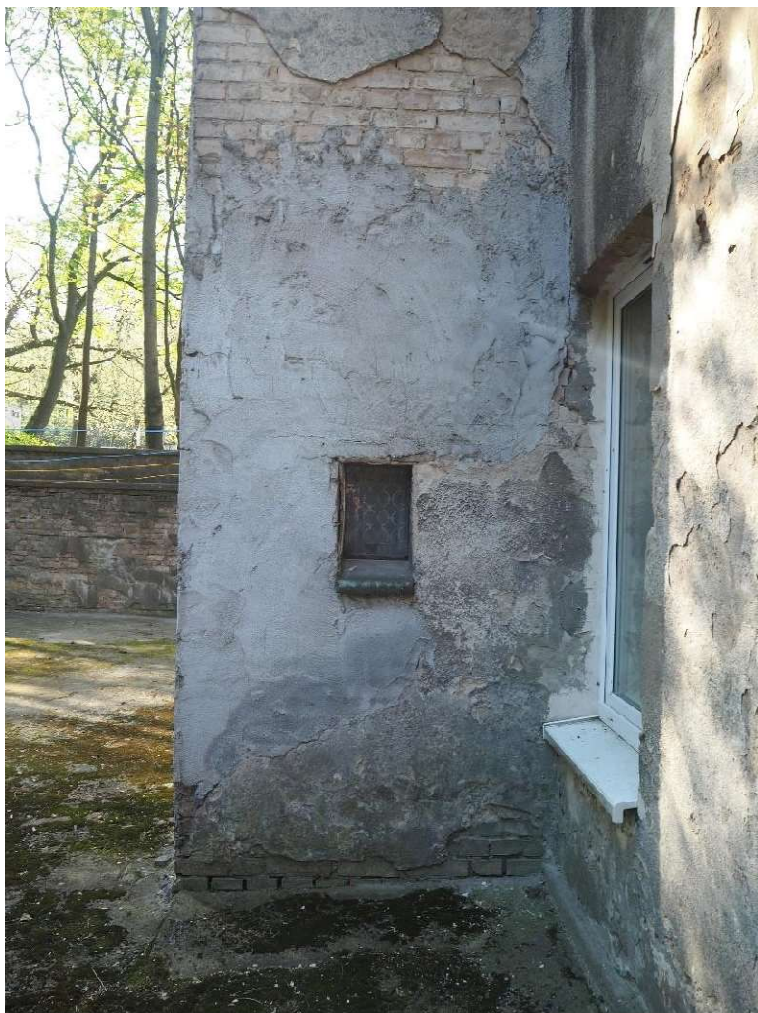
Fot. 23. Gorzów Wlkp. ul. Drzymały 28, elewacja od podwórza, współczesne reperacje, brak tynków (wyk. P. Antoniuk).
