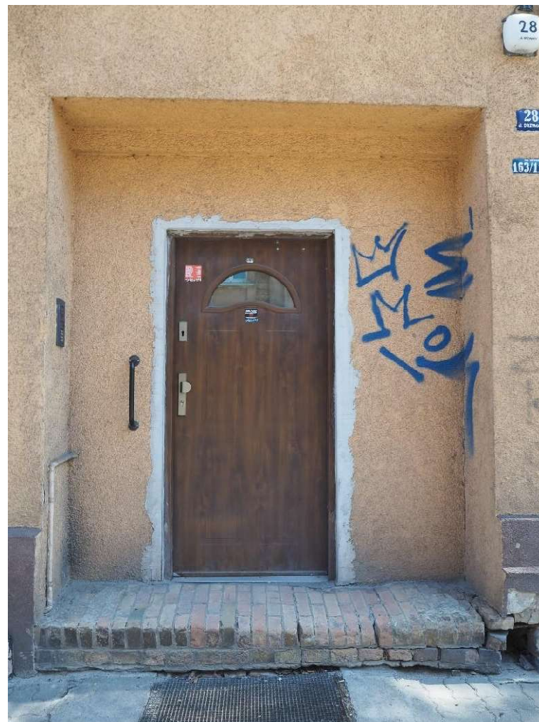
Fot. 10. Gorzów Wlkp. ul. Drzymały 28, fasada, drzwi wejściowe (wyk. P. Antoniuk).
