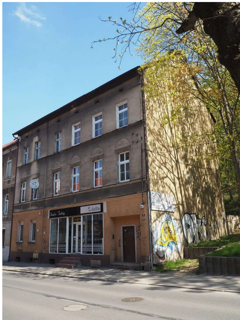
Fot. 19. Gorzów Wlkp. ul. Drzymały 28, fasada i ściana szczytowa (wyk. P. Antoniuk).
