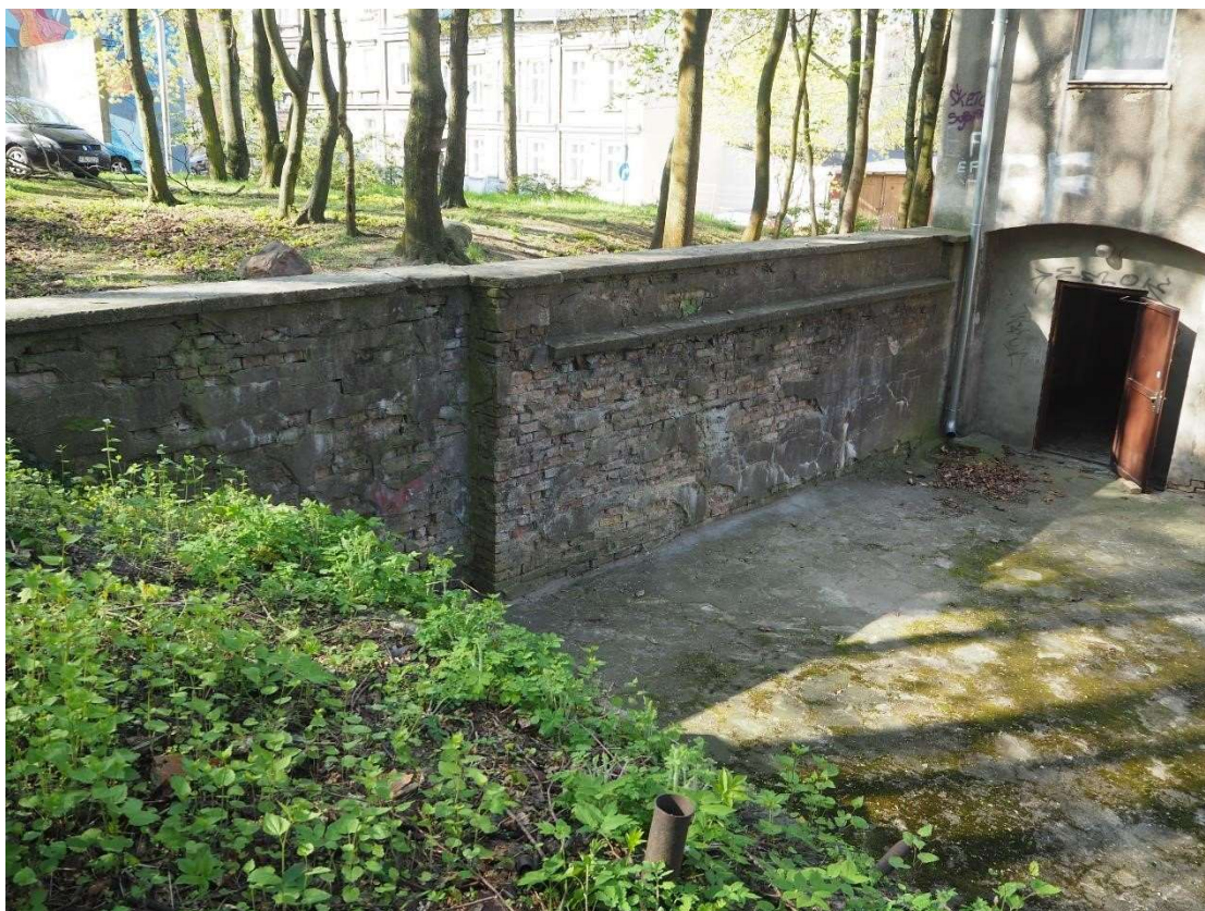
Fot. 29. Gorzów Wlkp. ul. Drzymały 28, elewacja od podwórza mur (wyk. P. Antoniuk).
