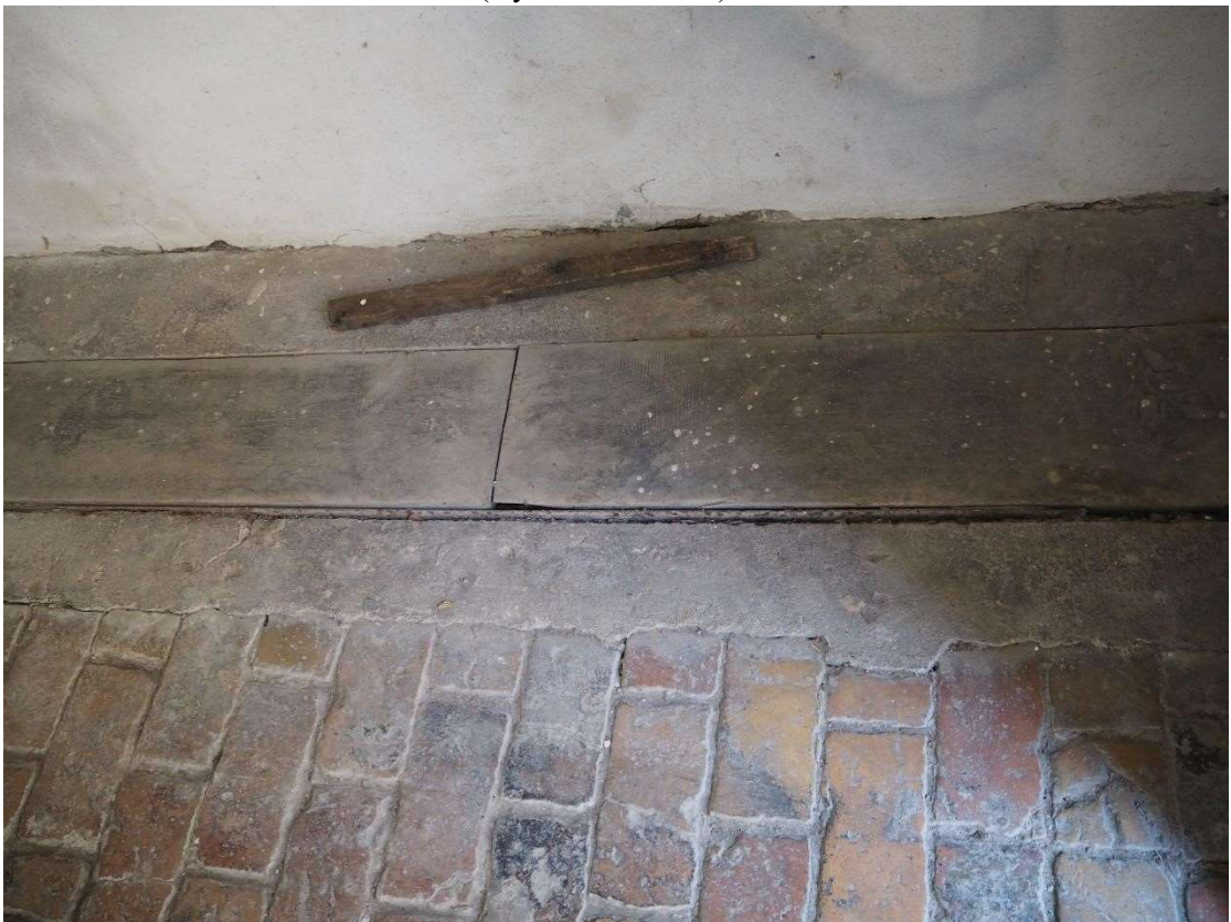
Fot. 14. Gorzów Wlkp. ul. Drzymały 28, korytarz, kanał wodny (wyk. P. Antoniuk).
