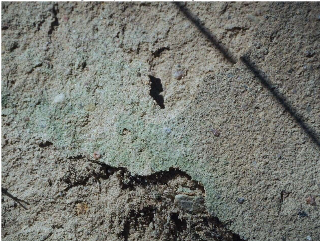
Fot. 30. Gorzów Wlkp. ul. Drzymały 28, elewacja od podwórza, zachowana zieleń analogiczna jak na fasadzie (wyk. P. Antoniuk).
