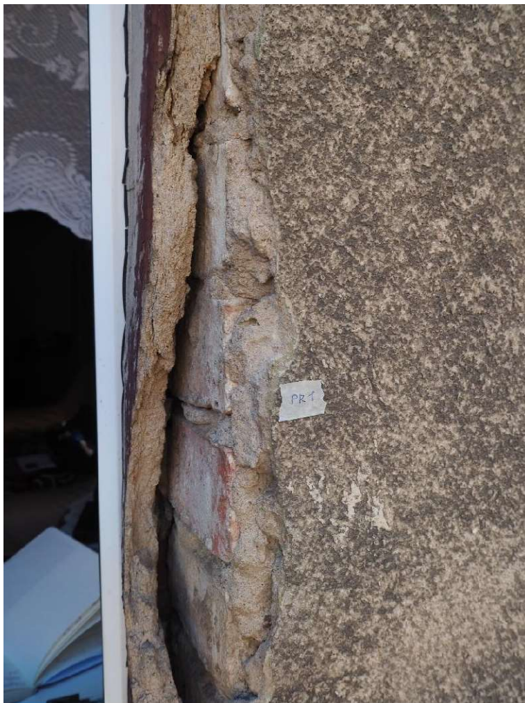
Fot. 11. Gorzów Wlkp. ul. Drzymały 28, fasada, odspojenie tynku, Fot. 12. Gorzów Wlkp. ul. Drzymały 28, fasada, odspojenie miejsce pobrania próbki nr 1 (wyk. P. Antoniuk). współczesnego tynku parteru (wyk. P. Antoniuk).
