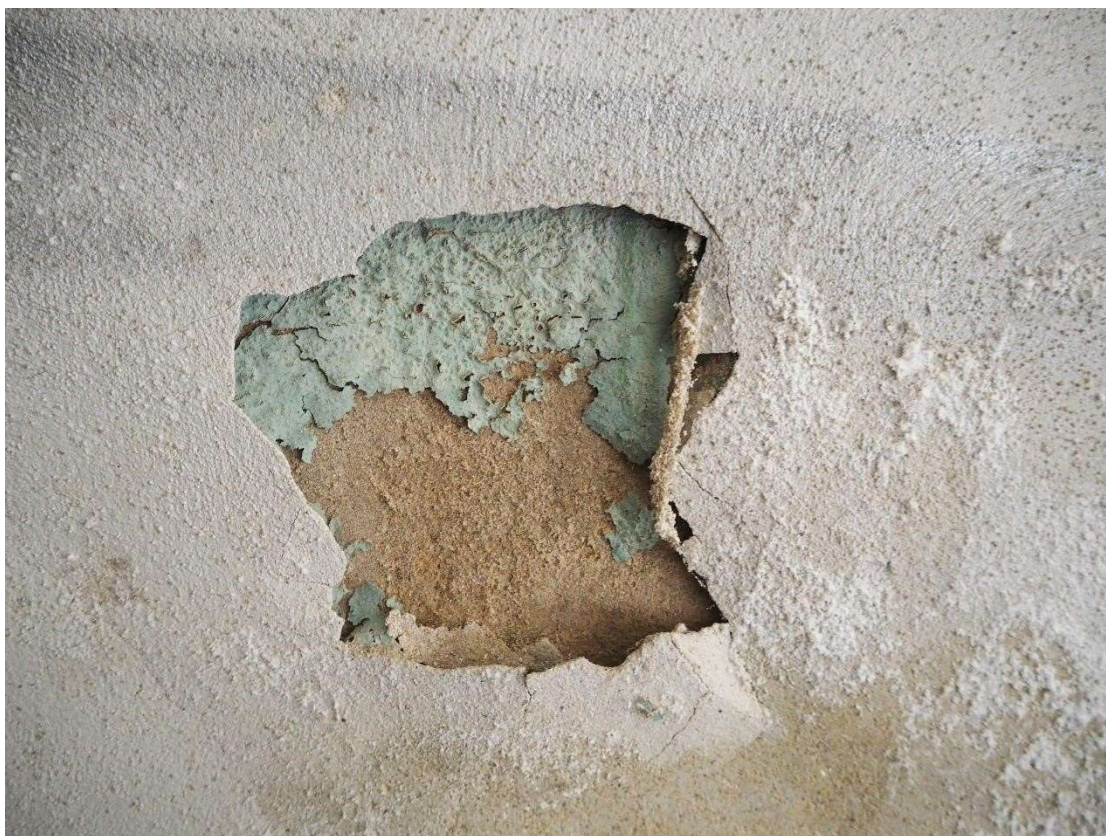
Fot. 15. Gorzów Wlkp. ul. Drzymały 28, korytarz, odspojenie współczesnych tynków i farby (wyk. P. Antoniuk).
