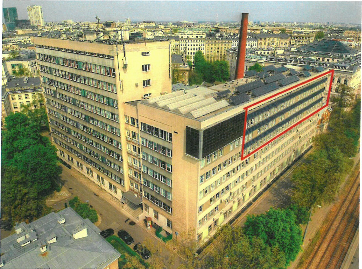
Fot.6: Zakres zadania inwestycyjnego polegającego na demontażu istniejących oraz zainstalowaniu i uruchomieniu nowej instalacji fotowoltaicznej. W zakres opracowania wchodzi panele oznaczone na czerwono.
