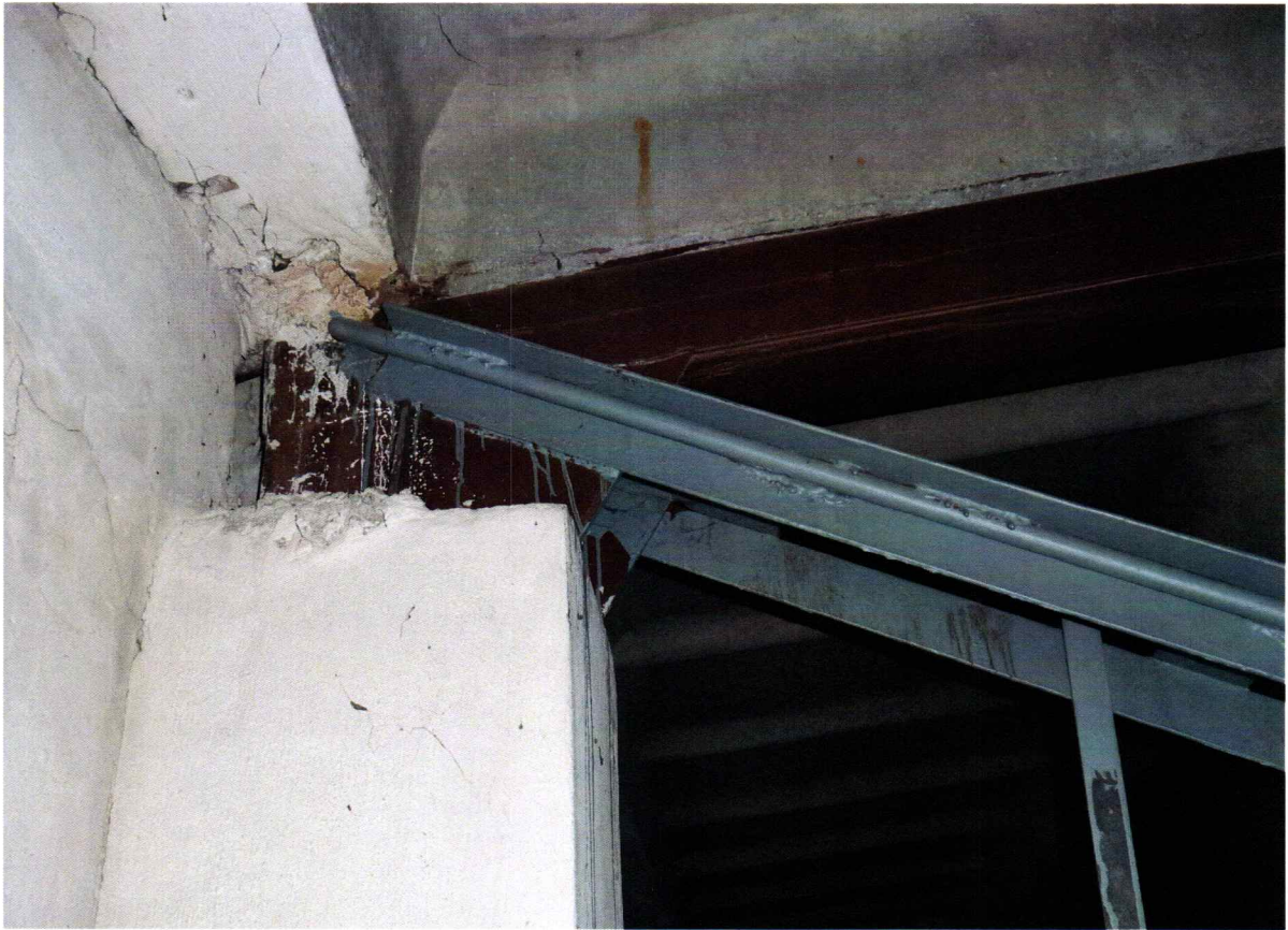
Fot. 5 – Węzeł podporowy dźwigara kratowego – widoczny fragment słupa żelbetowego 40x50cm oraz krzyżulec z 2 x L80x80x6 wzmocnianych prętami Ø24
