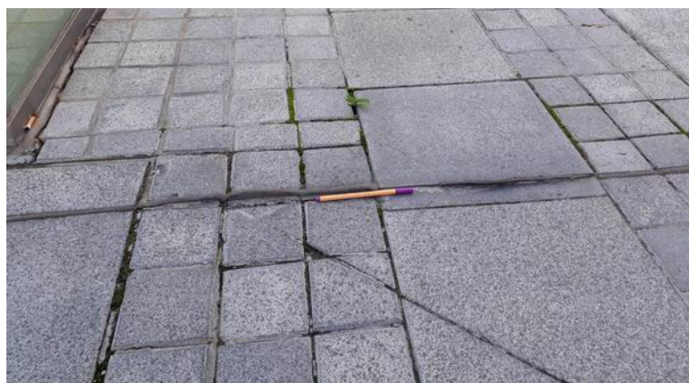
Rys. 10. Przykładowe wyparcia masy uszczelniającej
