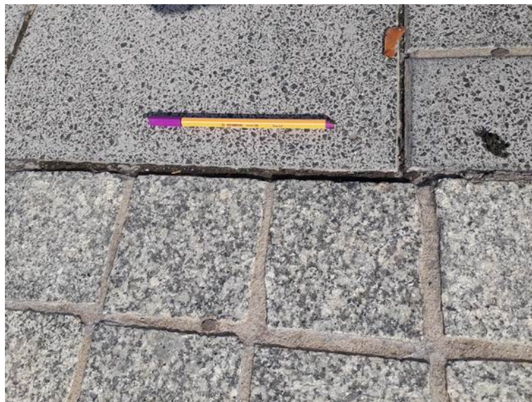
Rys. 5. Przykładowe ubytki spoin
