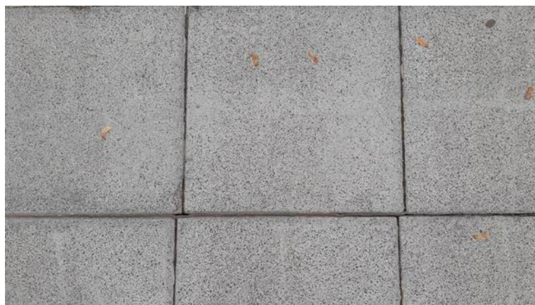
Rys. 4. Przykładowe przesunięcie elementów nawierzchni
