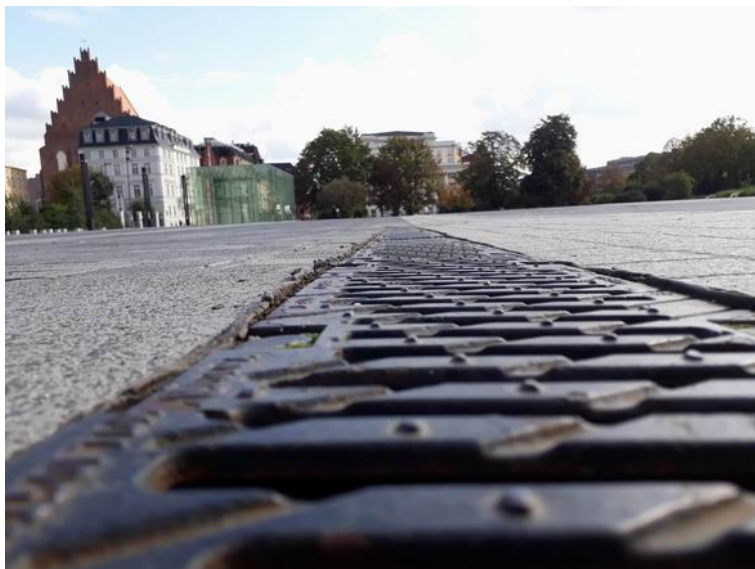
Rys. 16. Zwichrowane płaszczyzny uniemożliwiające sprawne odwodnienie
