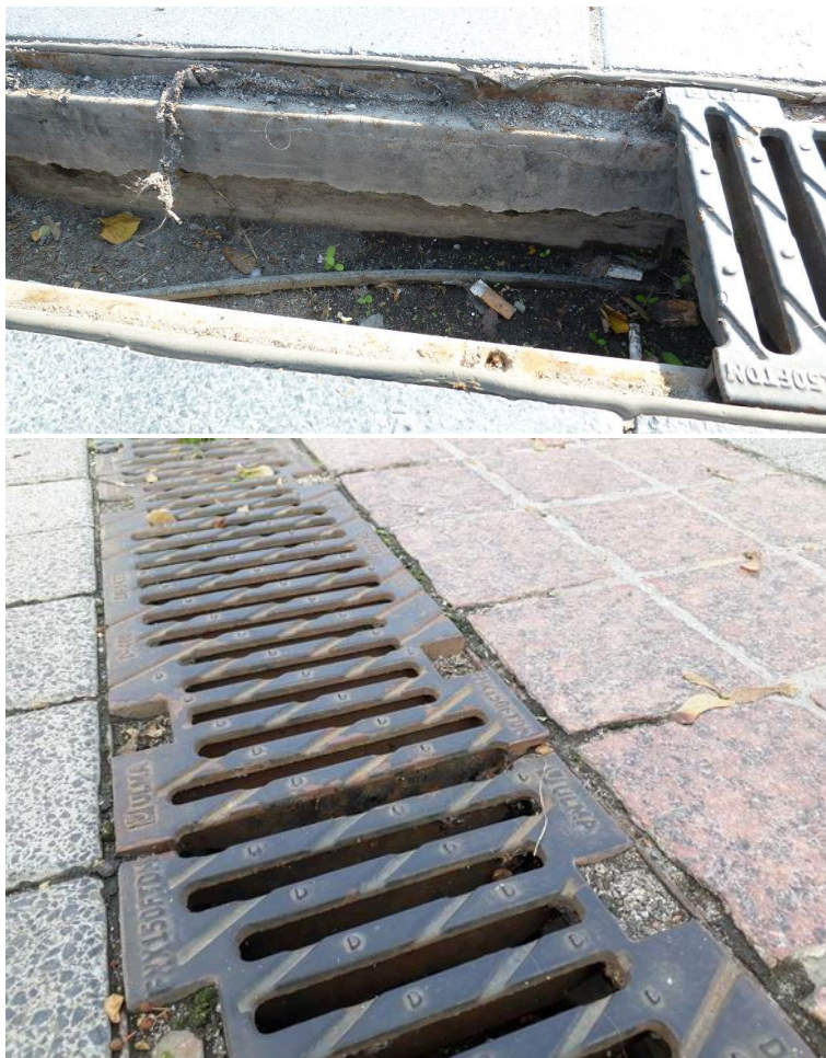
Rys. 7. Przykładowe uszkodzenia elementów odwodnieniowych
