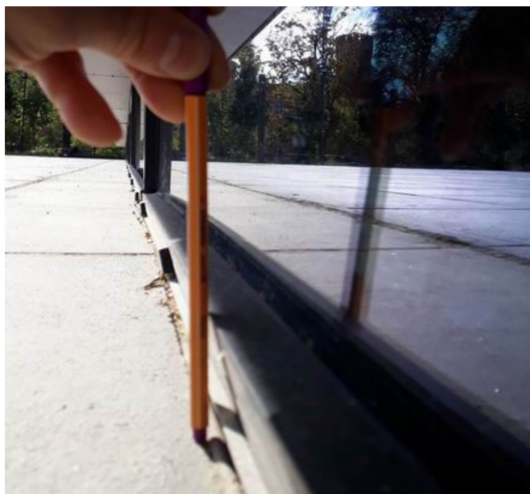
Rys. 6. Przykładowe deformacje ram okiennych
