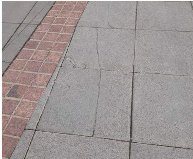
Rys. 3. Przykładowe pęknięcia płyt (w środku i na krawędzi)
