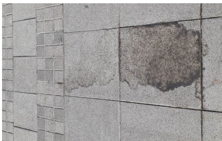
Rys. 11. Przykładowe trwałe zanieczyszczenia elementów nawierzchni
