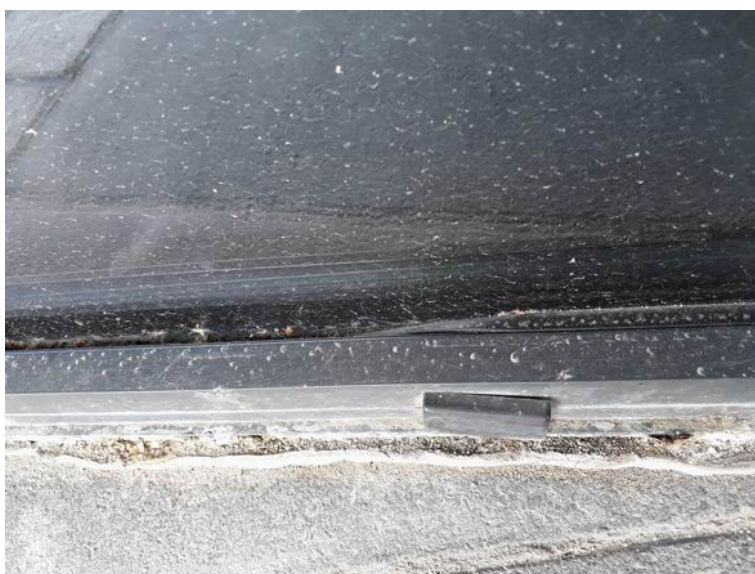
Rys. 17. Zapadnięcie uszczelnień w ramach okiennych
