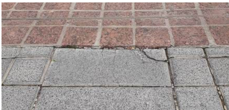
Rys. 9. Przykładowe wykruszenia elementów nawierzchni
