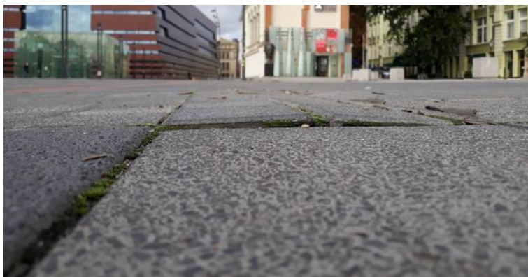
Rys. 8. Przykładowe wybrzuszenie elementów nawierzchni
