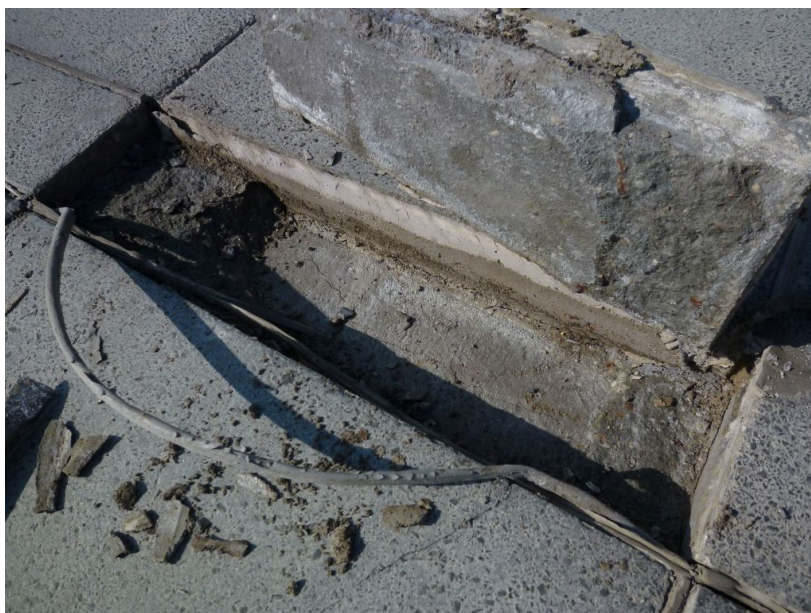
Rys. 23. Uszkodzenie nawierzchni na skutek przesuwu poziomego płyt. Widoczne ścięcie w obrębie elementu wibroprasowanego. Fragmenty szczipione z podsypką piaskowo-cementową.
