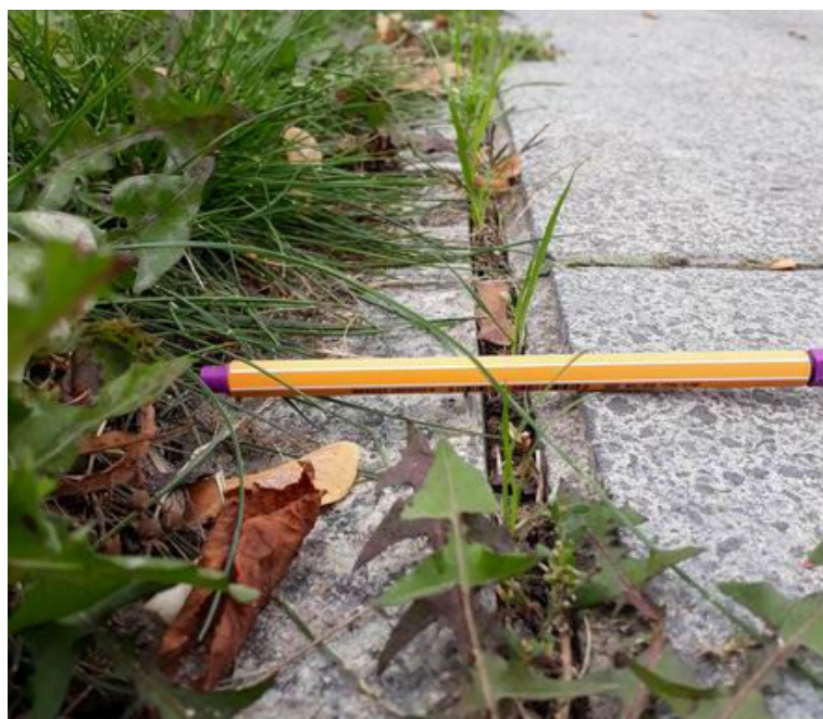
Rys. 12. Przykładowe zapadnięcia/przesunięcia krawężników
