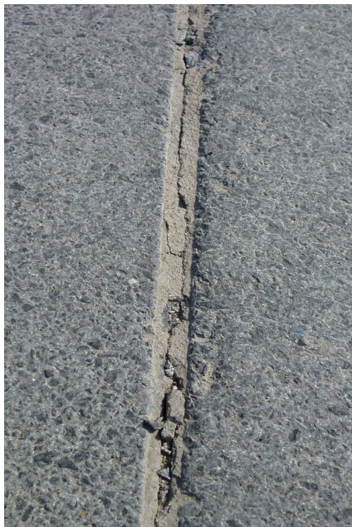
Rys. 14. Spękanie i wykruszenie zaprawy cementowej
