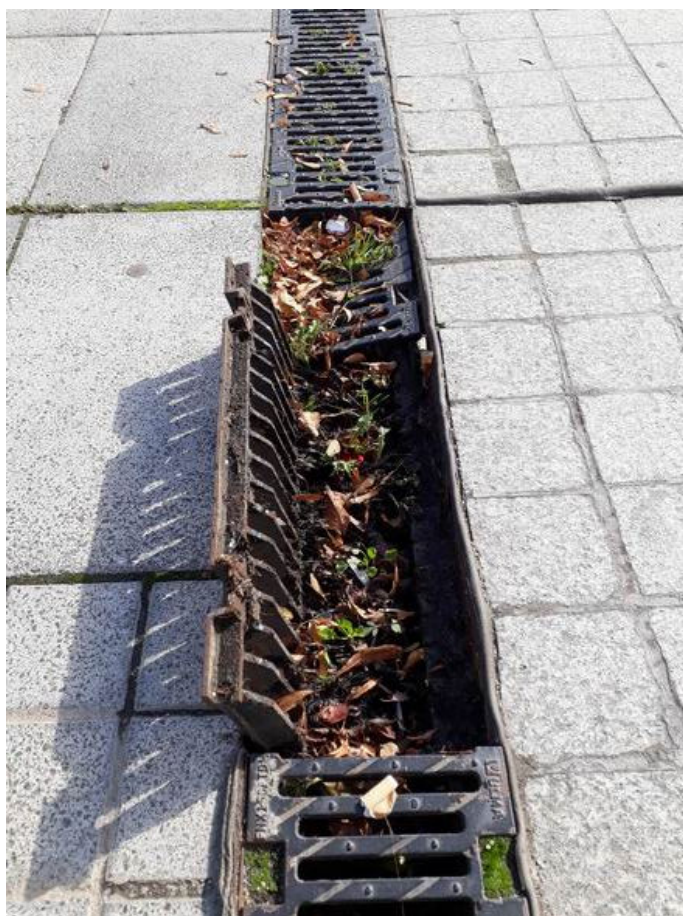
Rys. 15. Uszkodzenie rusztu uniemożliwiające położenie kraty
