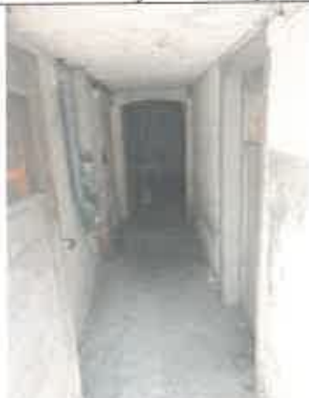
fot. nr 8 - piwnica
