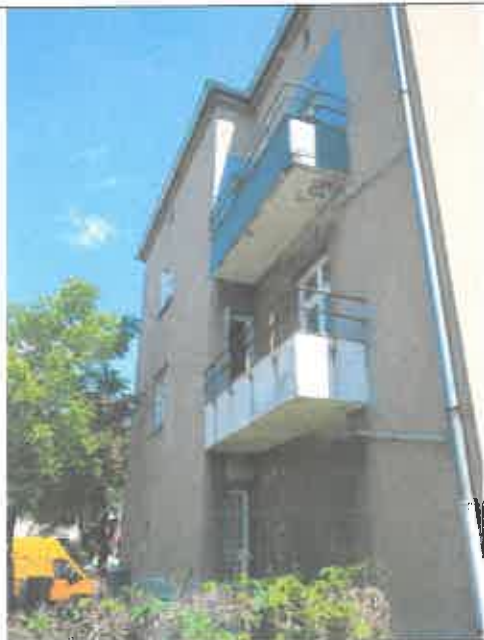
fot. nr 3 - bok prawy budynku
