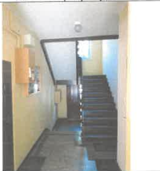
fot. nr 5 - klatka schodowa
