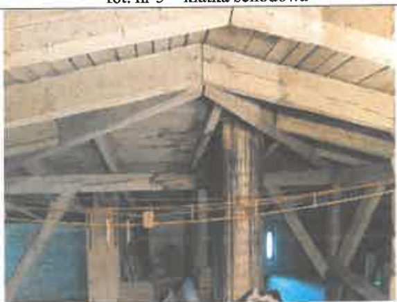
fot. nr 7 - strych
