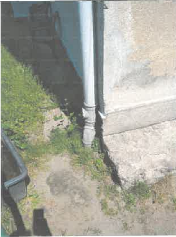
fot. nr 9 - odprowadzenie wód opadowych
