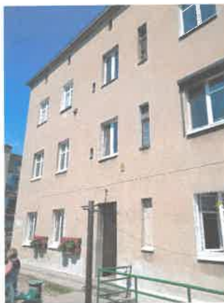
fot. nr 2 - tył budynku
