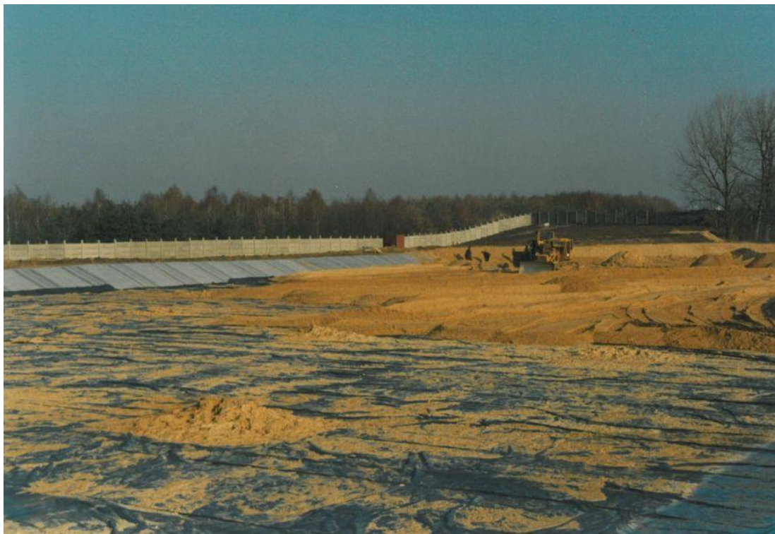
Fot. 4 fola PEHD, drenaż, obsypanie warstwą filtracyjną
