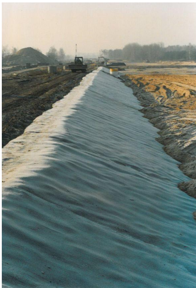
Fot. 2 ochrona wałów w postaci przegrody bentonitowej, warstwa filtracyjna na dnie
