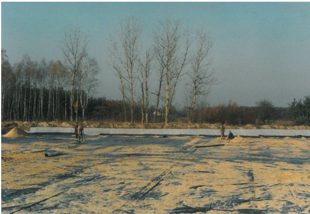
Fot. 8 folia PEHD, drenaż, warstwa filtracyjna
