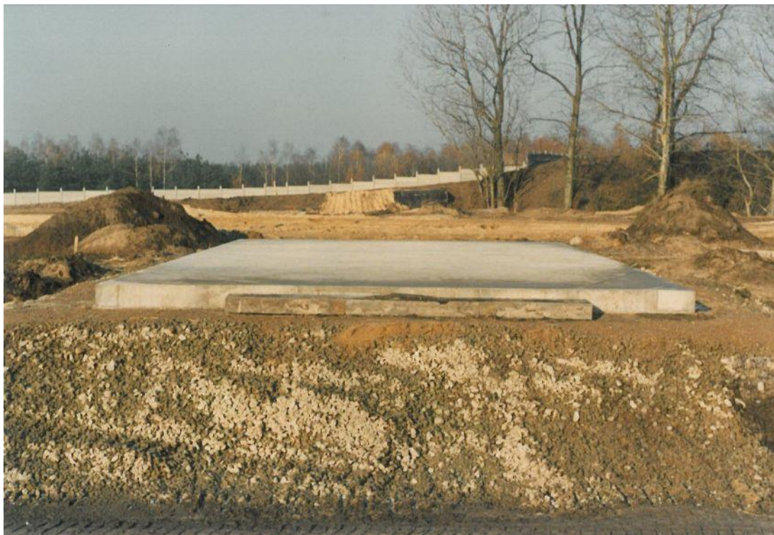
Fot. 6 Przejazd przez kanał – ochrona rur kanalizacji zbiorczej.
