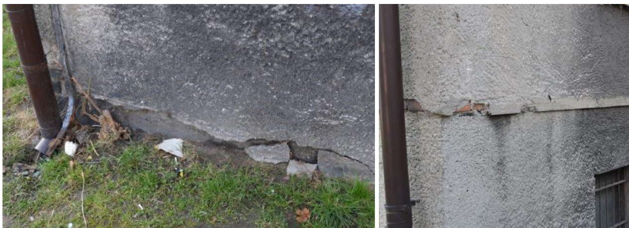
USZKODZENIA TYNKÓW COKŁU
