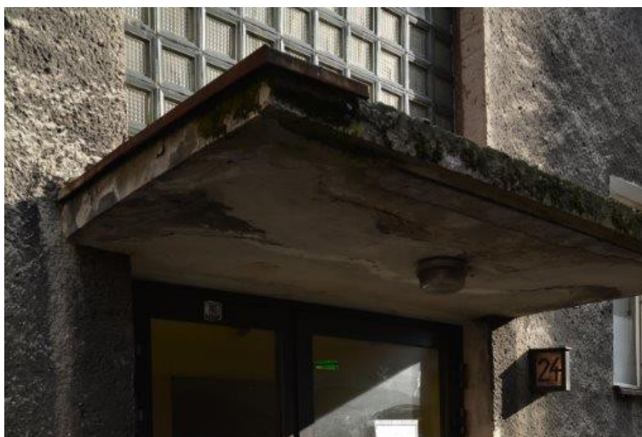
USZKODZENIA ZADASZENIA WEJŚCIA
