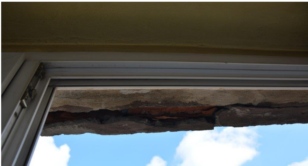
USZKODZENIA TYNKÓW NA NADPROŻACH
