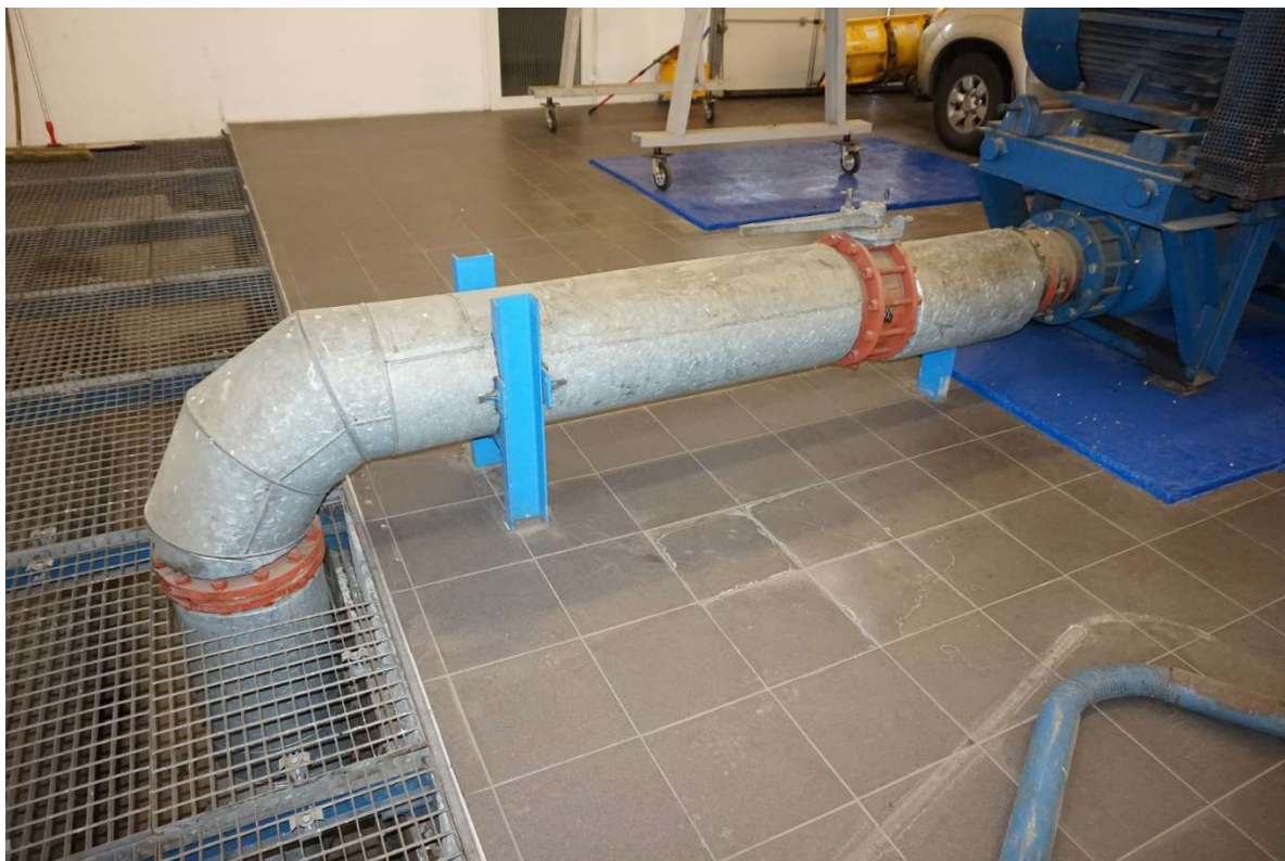
Rys. nr 2 Widok przyłącza rurowego.
