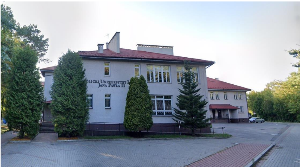
Fot. 2 Budynek KUL Stalowa Wola, ul. Ofiar Katynia 6a elewacja stan z 2019 r.
