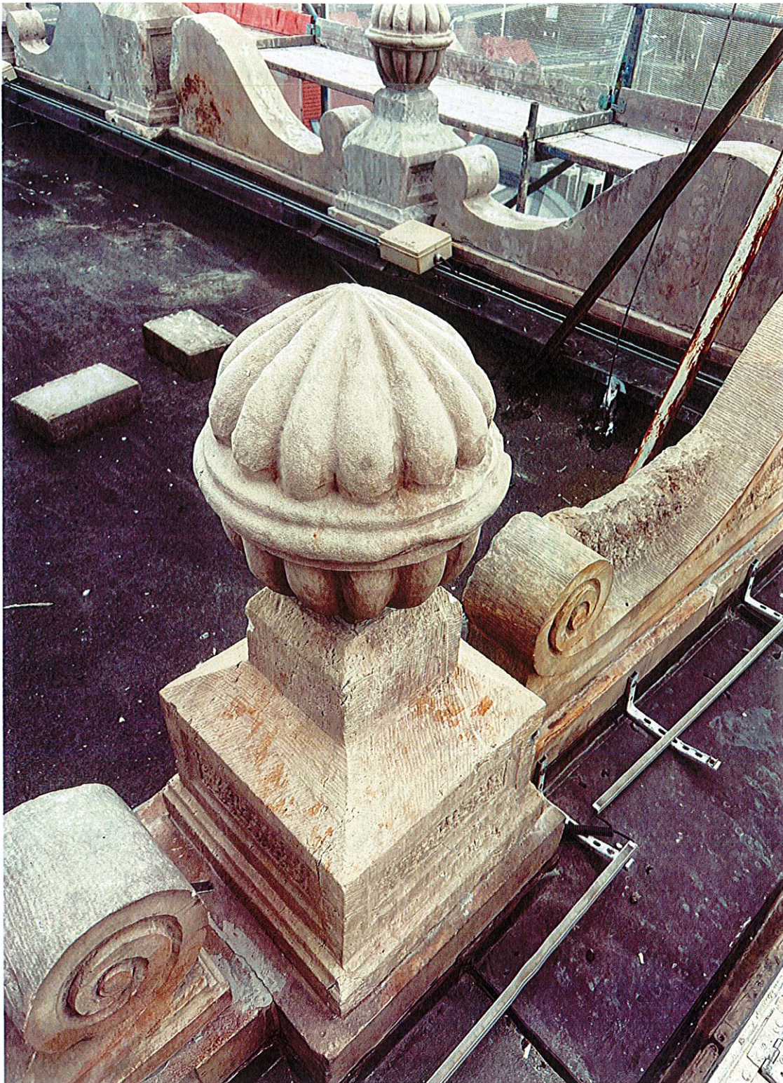
Rys. 4. Fragment kamiennej attyki wieńczącej skrzydło wschodnie – próba oczyszczania kamienia z nawarstwień mikrobiologicznych oraz zabrudzeń powierzchniowych
