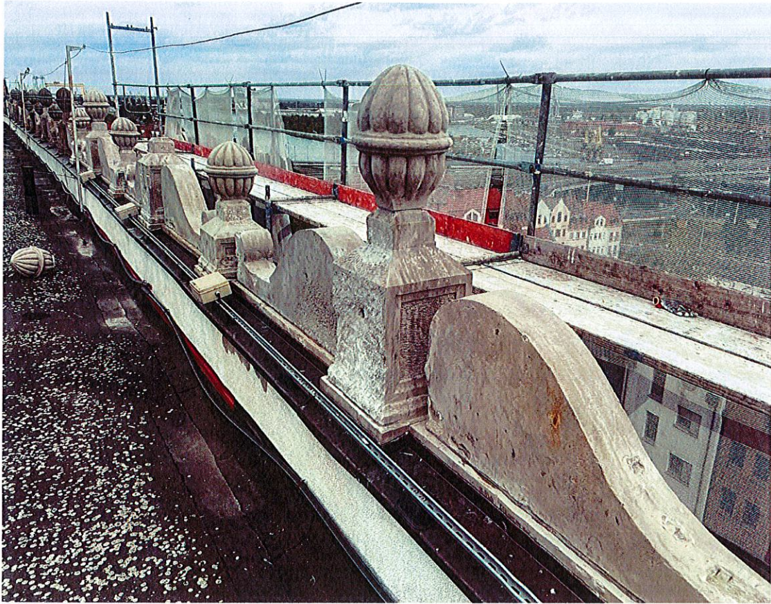
Rys. 5. Fragment kamiennej atyki wieńczącej skrzydło wschodnie – próba oczyszczania kamienia z nawarstwień mikrobiologicznych oraz zabrudzeń powierzchniowych
