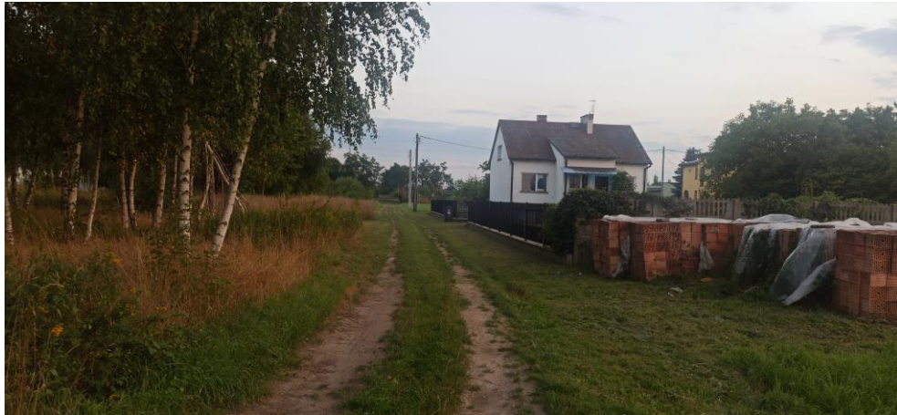
Zdjęcie 7 – Droga gruntowa – dojazd do ul. Kolejowej
