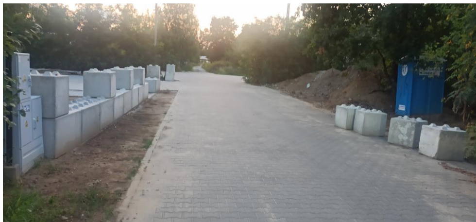
Zdjęcie – Teren przewidziany pod drogę za zabudowa magazynową
