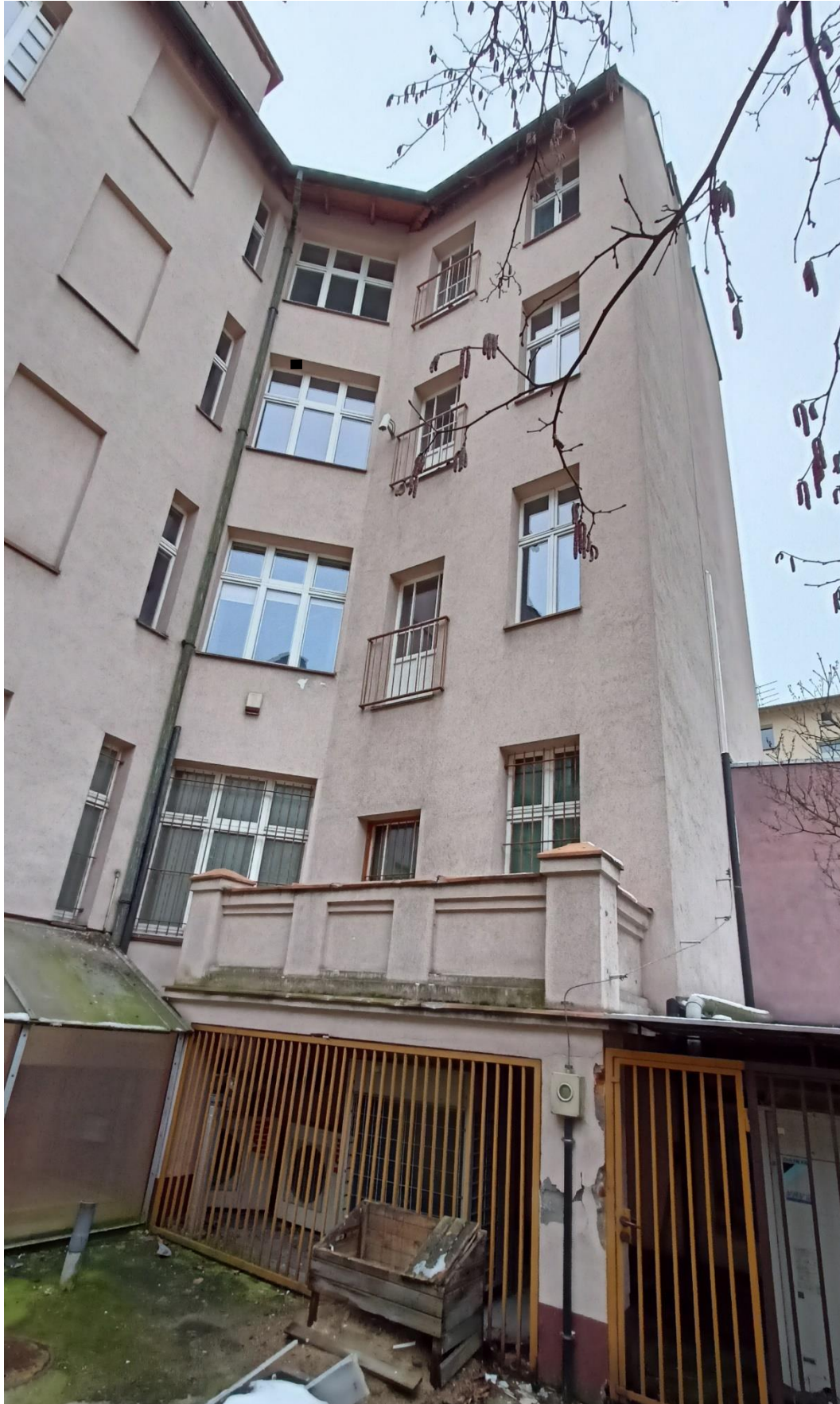
Fot. 4 Elewacja południowo-wschodnia
