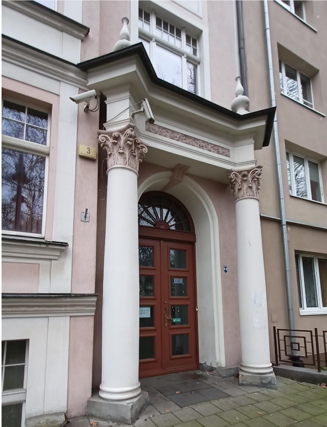
Fot. 2 Główne wejście do budynku (od strony ul. Słowackiego)
