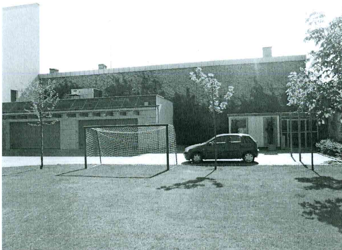
widok elewacji tylnej
