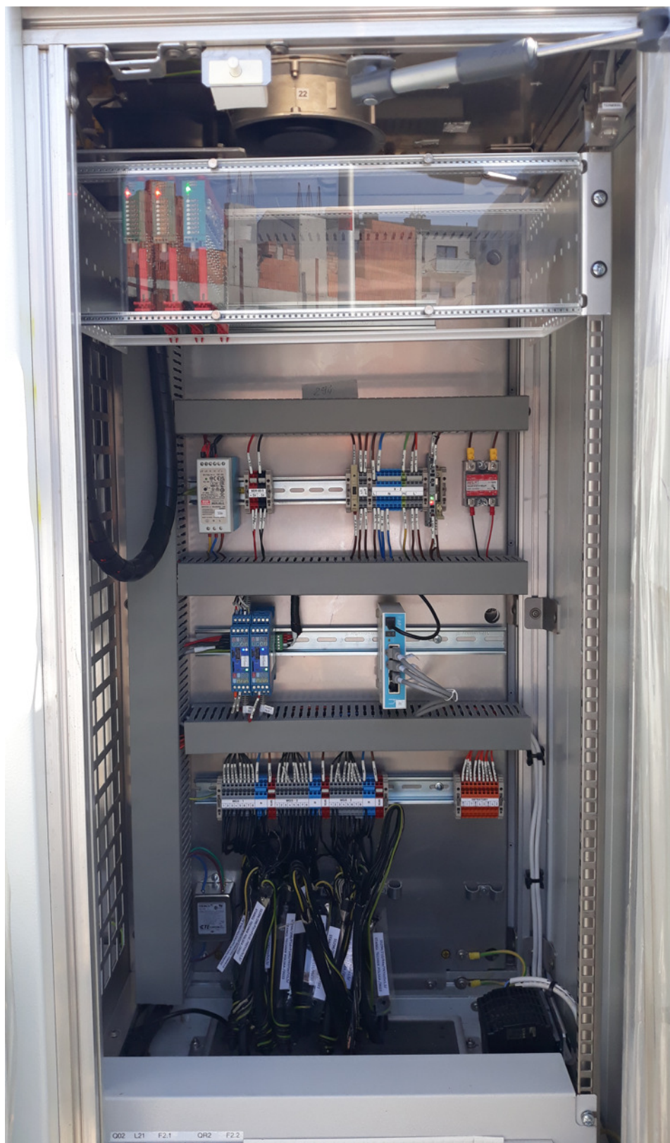
Istniejące wyposażenie przedziału sterownika sygnalizacji w szafie ITS I294
