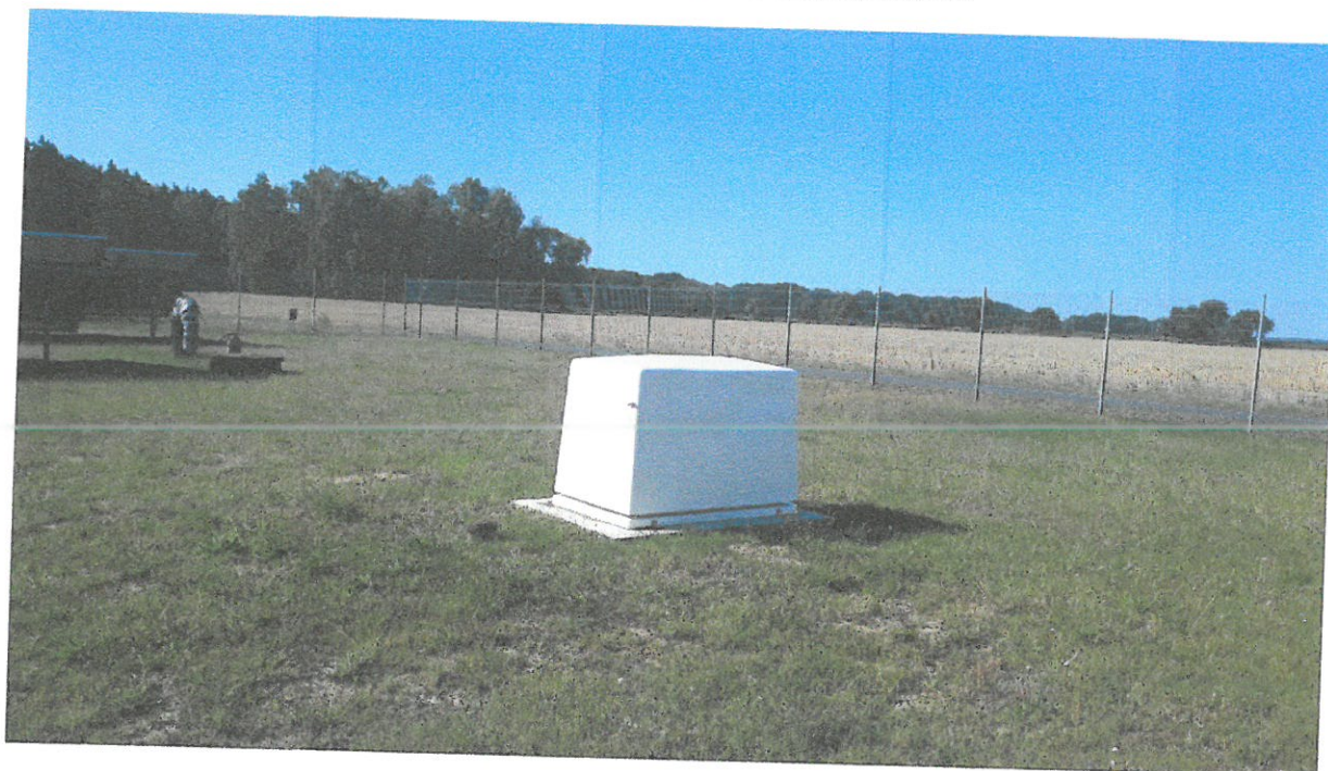
Istniejąca obudowa studni głębinowej – nie podlega modernizacji
