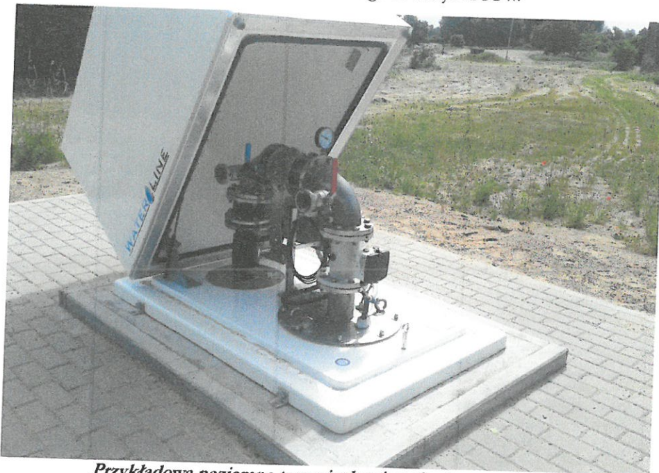
Przykładowa naziemna termoizolacyjna obudowa studni głębinowej
