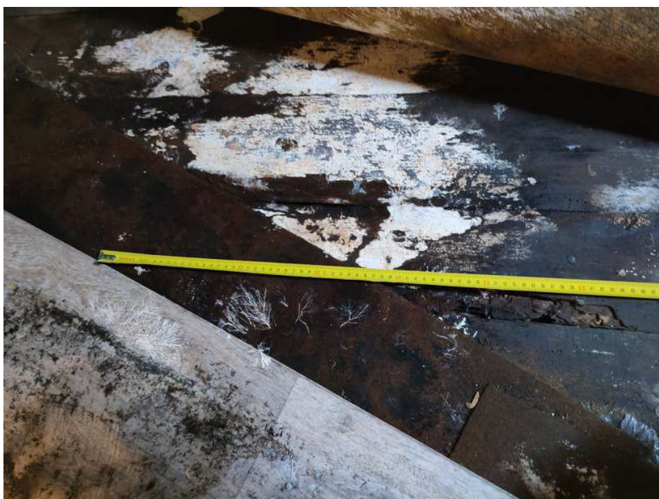
Fot. 4. W miejscu wskazanym na fot.3 na kondygnacji wyższej, stwierdzono zaawansowany rozwój grzyba pod wykładziną z PCV.
