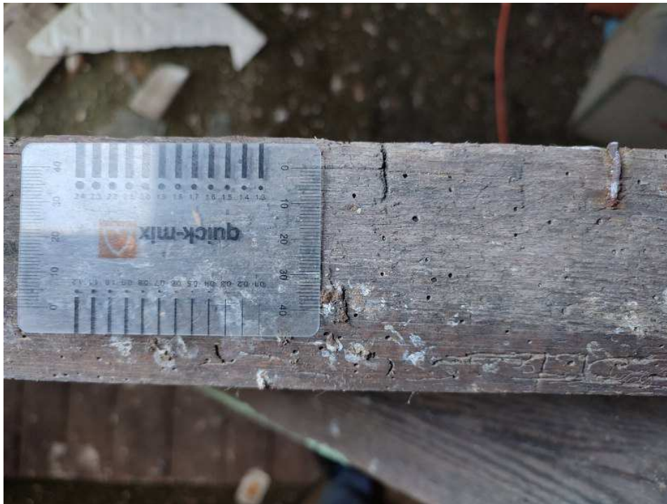
Fot. 7 Uszkodzenie zastrzałów w dolnym poziomie poddasza w wyniku działalności szkodników. Okrągłe otwory wlotowe wskazujące na działalność kołatka domowego.
