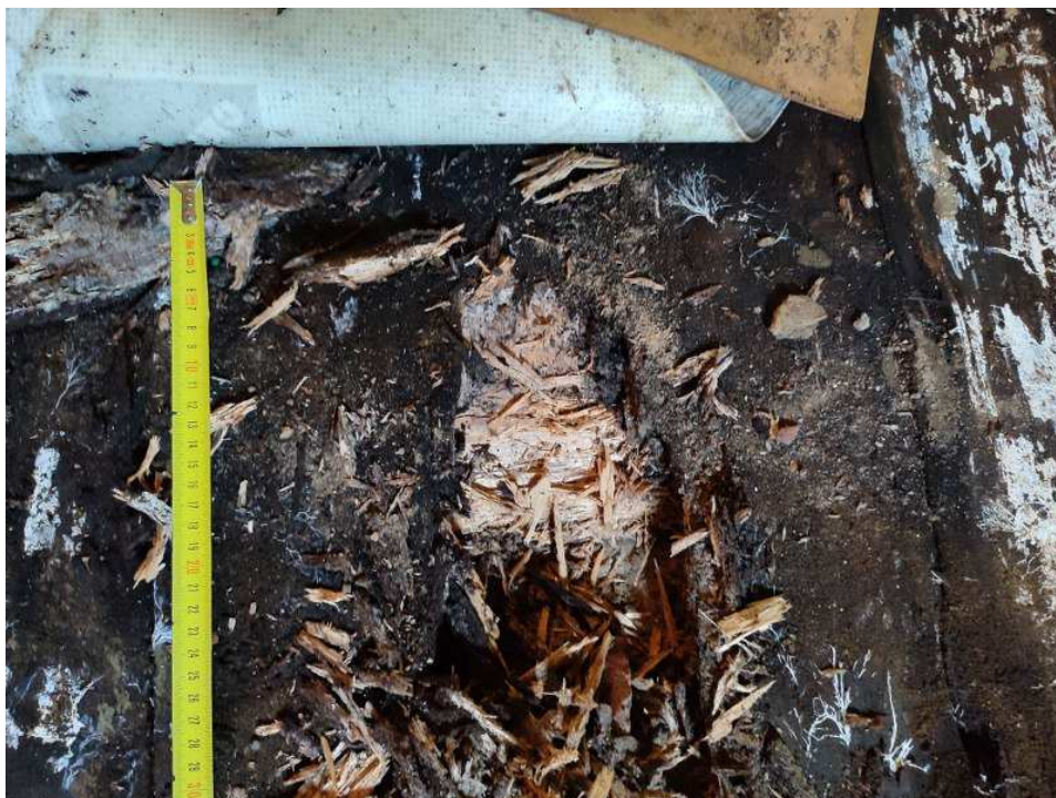
Fot. 5. Wykonano sprawdzenie struktury drewna w miejscu z fot.3 i 4. Stwierdzono zaawansowany rozkład drewna w całym przekroju.
