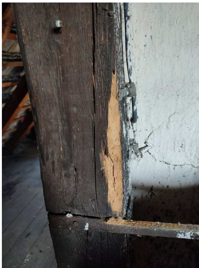
Fot. 18. Jeden ze słupów na poddaszu uszkodzony niemal w całej strukturze. Klasyfikacja do wymiany.
