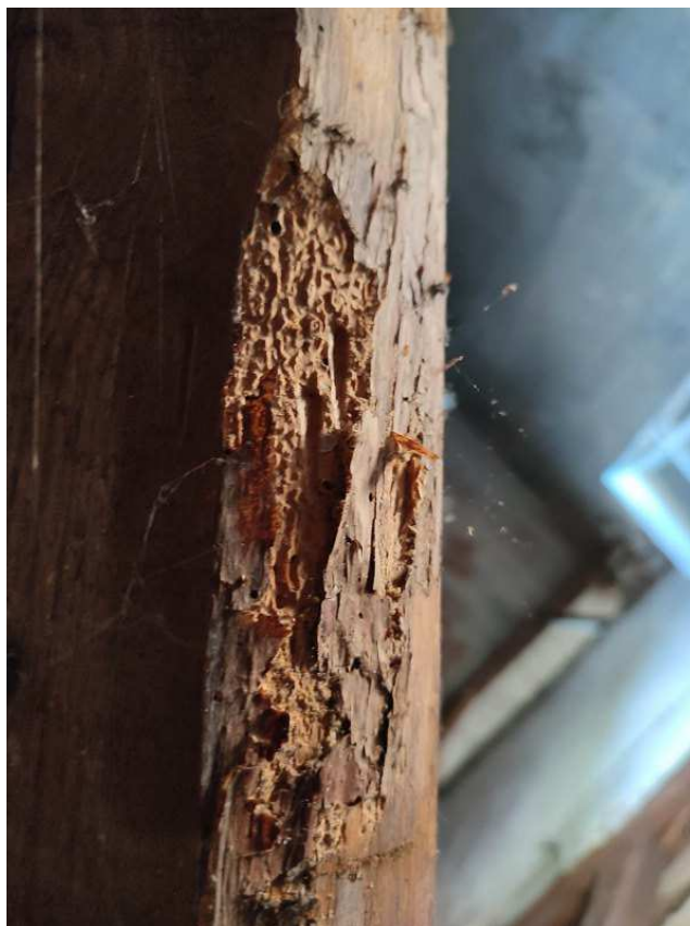
Fot. 13. Pojedyncze krokwie w poziomie drugiego poddasza porażone przez owady. Widoczne porażenie na głębokość ok. 1cm od lica elementu.
