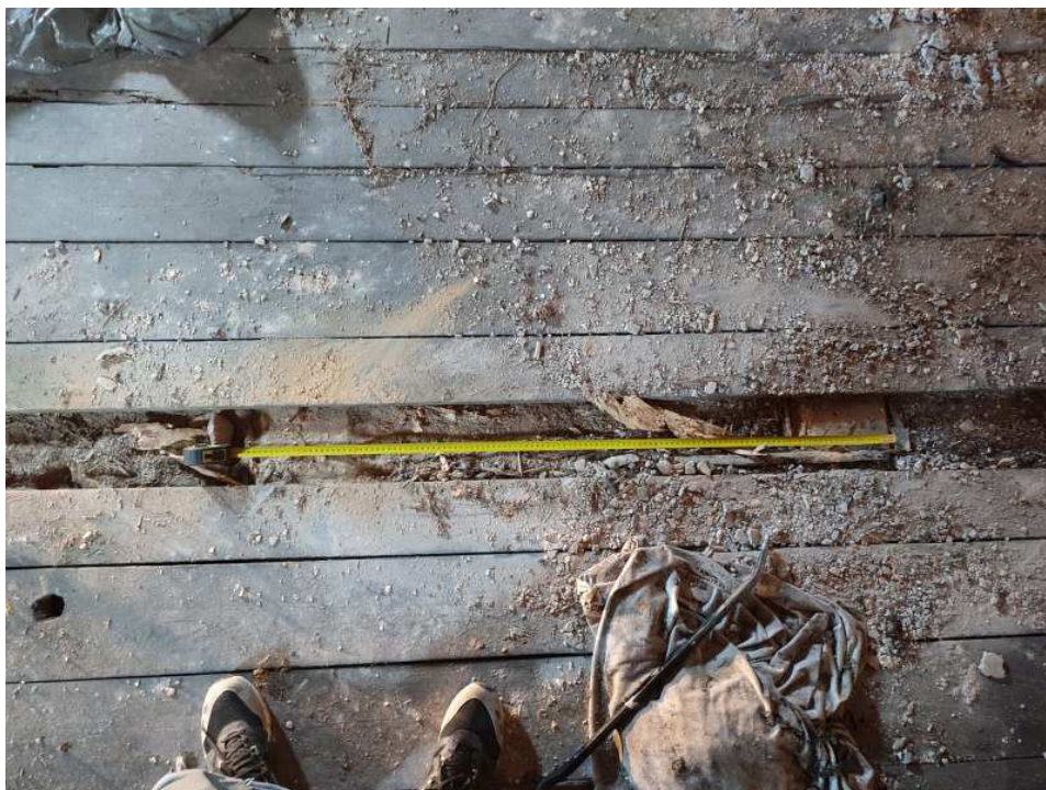
Fot. 15. Odkrywka podłogi belek stropowych w drugim poziomie poddasza. Deskowanie podłóg w całości skorodowane przez działanie szkodników oraz przez zawilgocenie.
