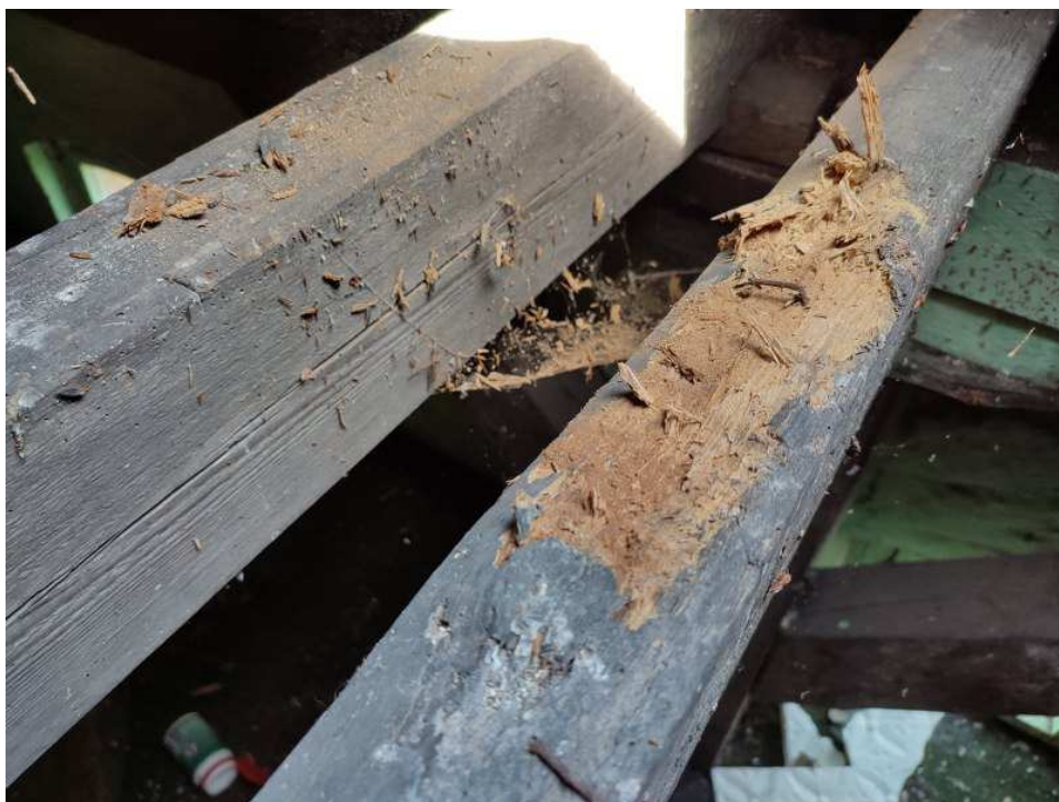
Fot. 8. Sprawdzenie struktury zastrzałów z fot.7 pokazało iż porażenie drewna jest bardzo głębokie, niemal w całości przekrój jest porażony.
