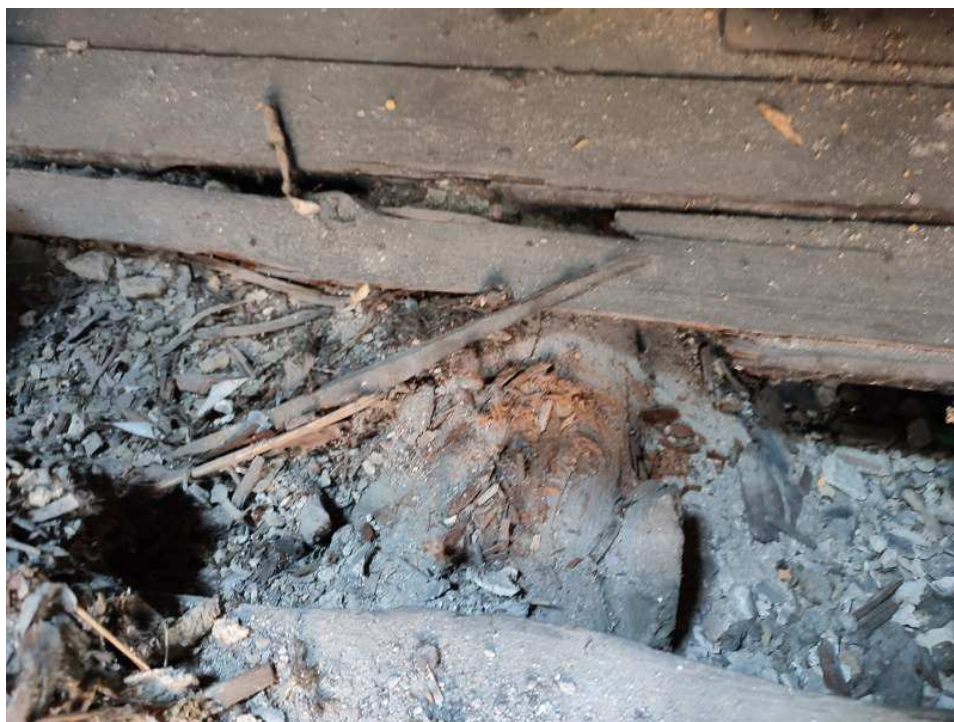
Fot. 14. Większość belek drewnianych w stropie pod drugim poziomem poddasza porażona przez szkodniki oraz w wyniku działania wody przez nieszczelny dach.
