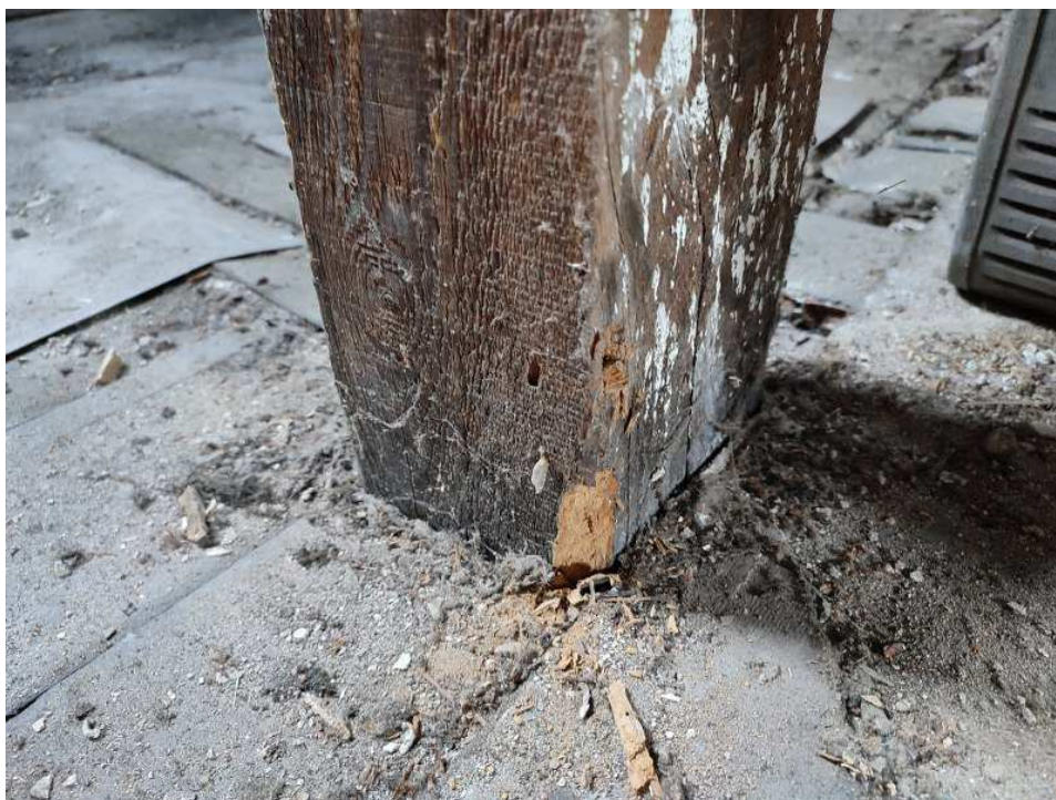
Fot. 17. Część słupów na poddaszu uszkodzona w obszarze oparcia na stropie. Porażenie do głębokości około 2cm od lica elementu.
