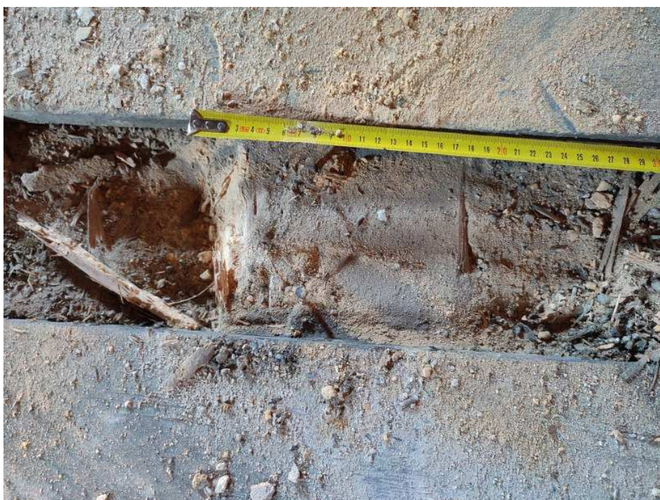
Fot. 16. Struktura belek drewnianych uszkodzona niemal w połowie przekroju elementu. Klasyfikacja do wymiany.
