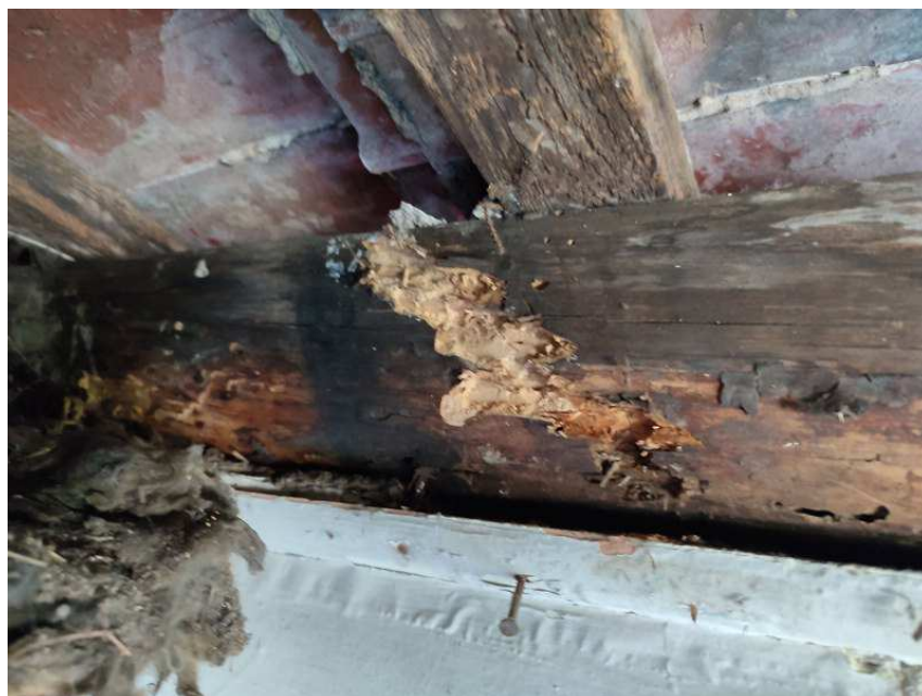
Fot. 2. W wykonanej odkrywce stwierdzono podłużne otwory oraz korozję drewna w wyniku działalności spuszczela pospolitego. Drewno porażone do ok. 2cm od lica krokwi.
