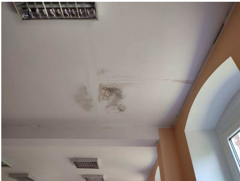
Fot. 3. Widoczne zawilgocenie sufitu w Sali spotkań na 1 piętrze. Powyżej na niższym poziomie poddasza bardzo intensywny rozwój grzyba oraz rozkład brunatny belek stropowych.
