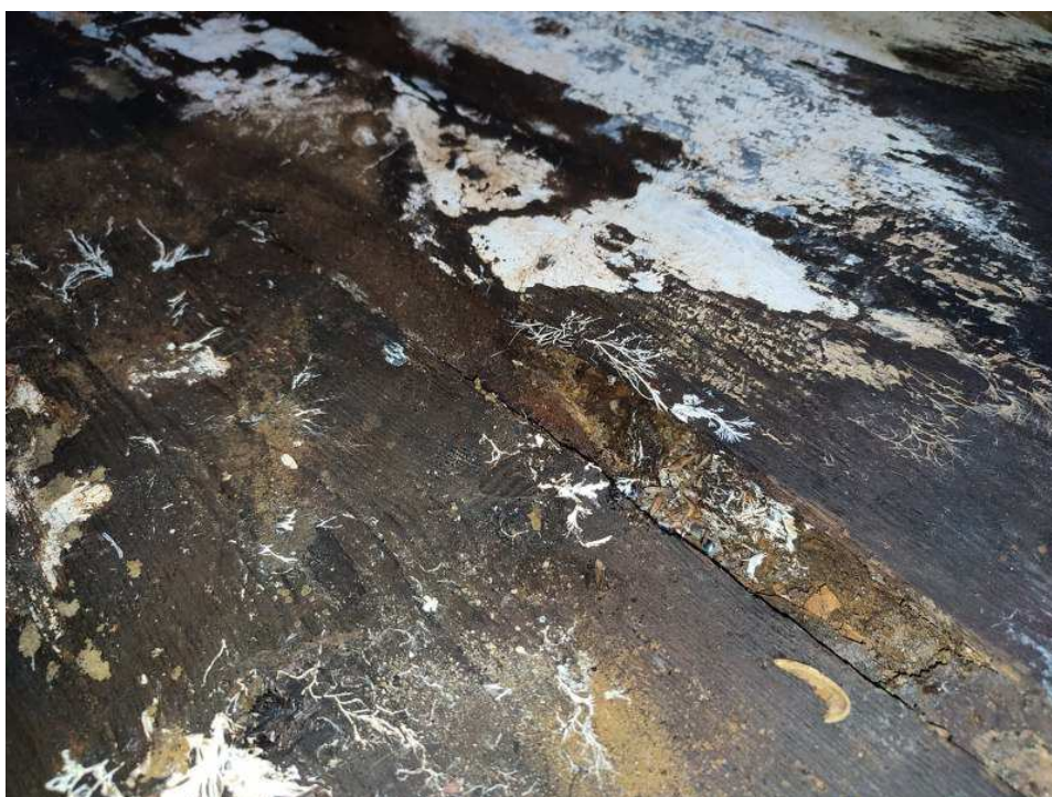
Fot. 6. W miejscu wskazanych na fot.3 i 4 podłoga drewniana całkowicie skorodowana biologicznie.
