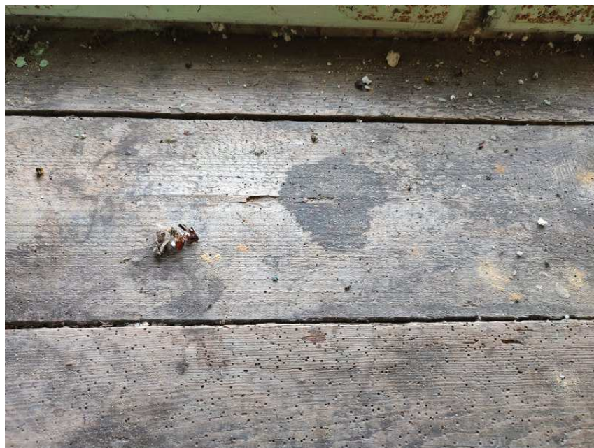
Fot. 11. Deski w parapetach i w deskowaniu podłóg w większości miejsc porażona przez owady. Na zdjęciu widoczne liczne otwory wlotowe.
