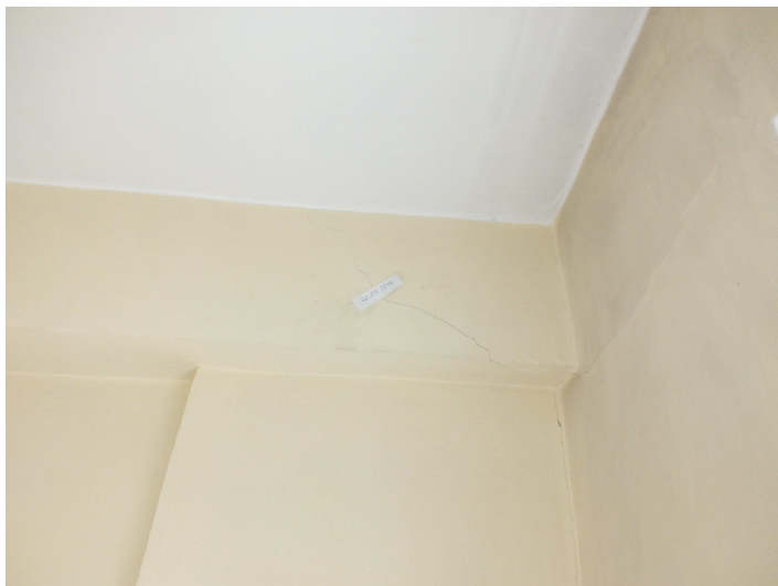
Fot. 5.3.5 Zarysowanie ramy w poziomie IV piętra.
