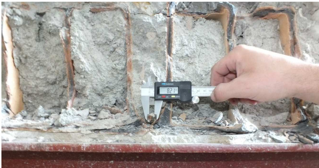
Fot. Z.2.5 Bezpośredni pomiar zbrojenia stropu w obrębie klatki schodowej cz.1
