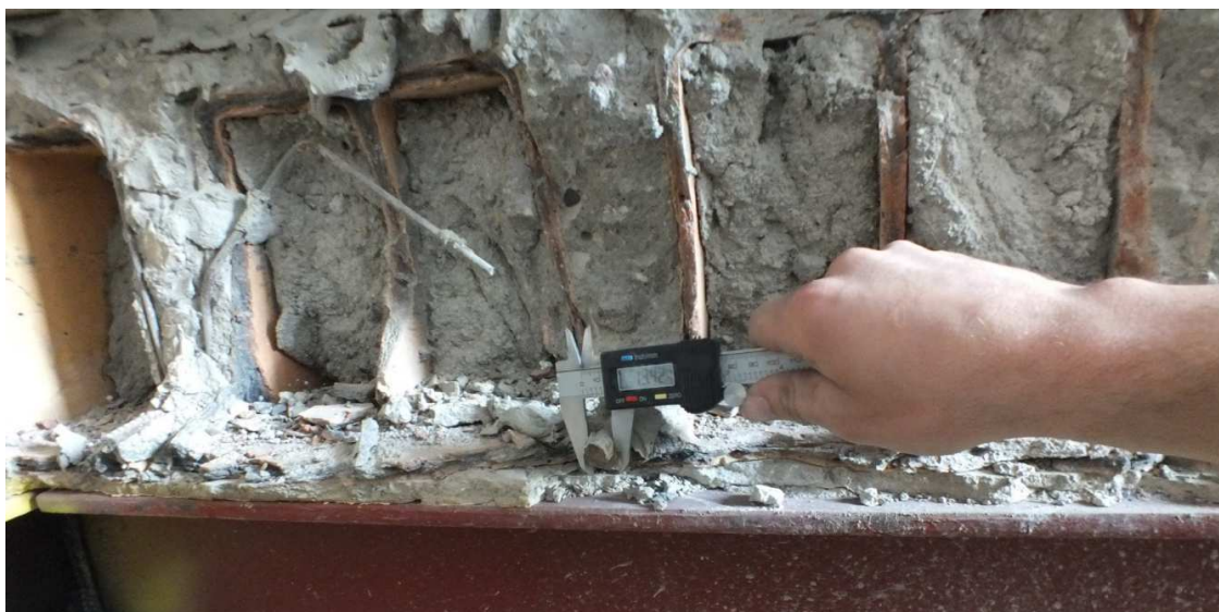
Fot. Z.2.6 Bezpośredni pomiar zbrojenia stropu w obrębie klatki schodowej cz.2
