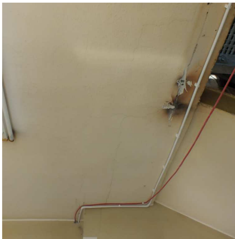
Fot. Z.1.17 Widok rysy poziomych na spoczniku nadbudowanej klatki schodowej świadczącej o braku dylatacji w obrębie klatki
