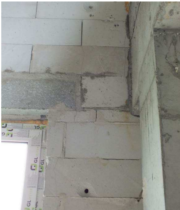
Fot.14. Widok rys ukośnych w obrębie nadproży
