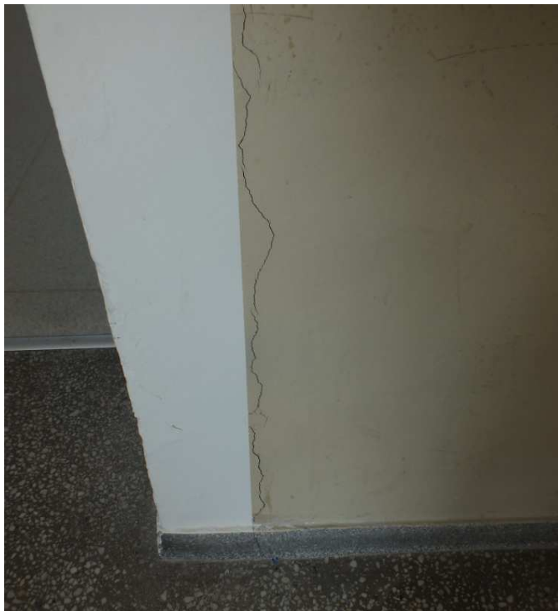
Fot. Z.1.16 Widok rysy pionowej świadczącej o braku dylatacji pionowej w obrębie klatki schodowej
