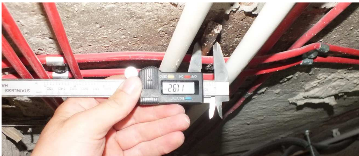
Fot. 5.3.3. Pomiar rzeczywisty zbrojenia przeszłowego stropu wykonany podczas oględzin
