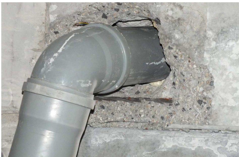
Fot. Z.1.22 Widok niewłaściwie wykonanego przejścia instalacyjnego przez płytę stropodachu
