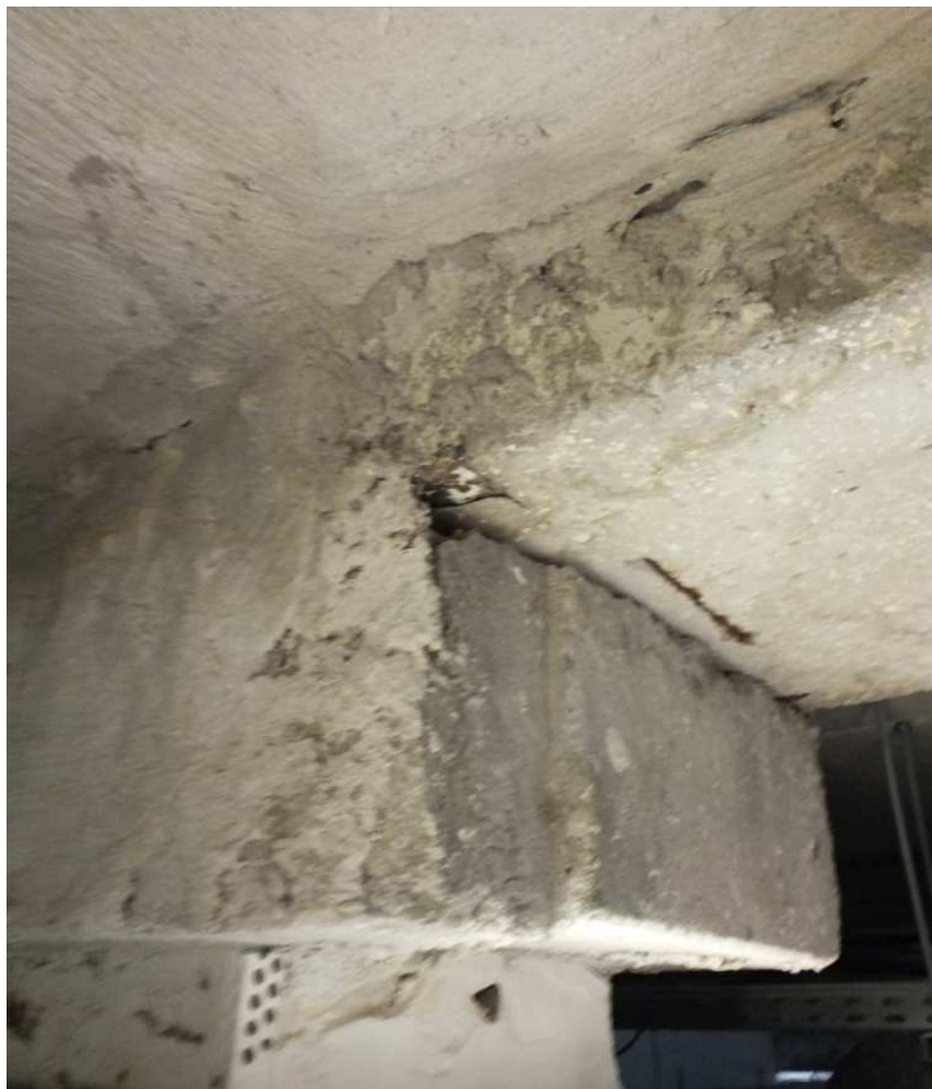
Fot. Z.2.12 Połączenie rygla z ramą prefabrykowaną typu H
