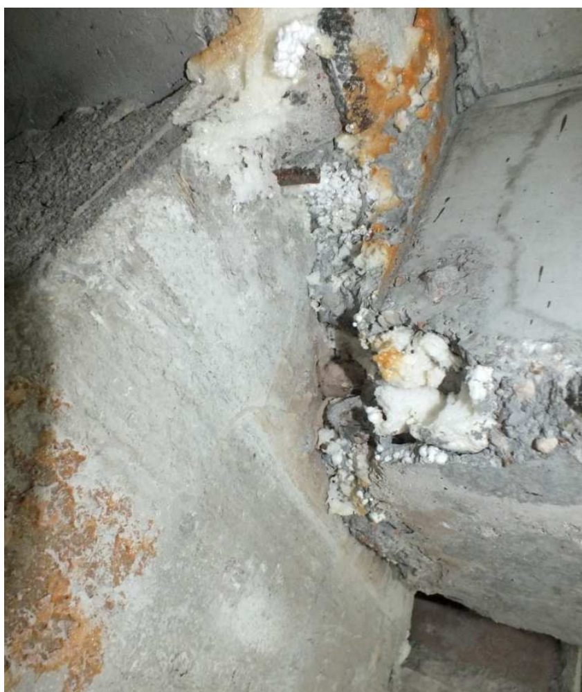
Fot. Z.2.15 Odkrywka obrazująca sposób łączenia rygla ramy w osi nr 9
