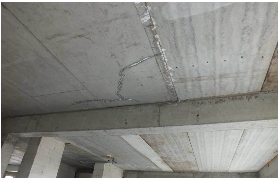
Fot. Z.1.5 Widok niedokładnego wykonania montażu płyt kanałowych i prowizorycznych prób naprawczych
