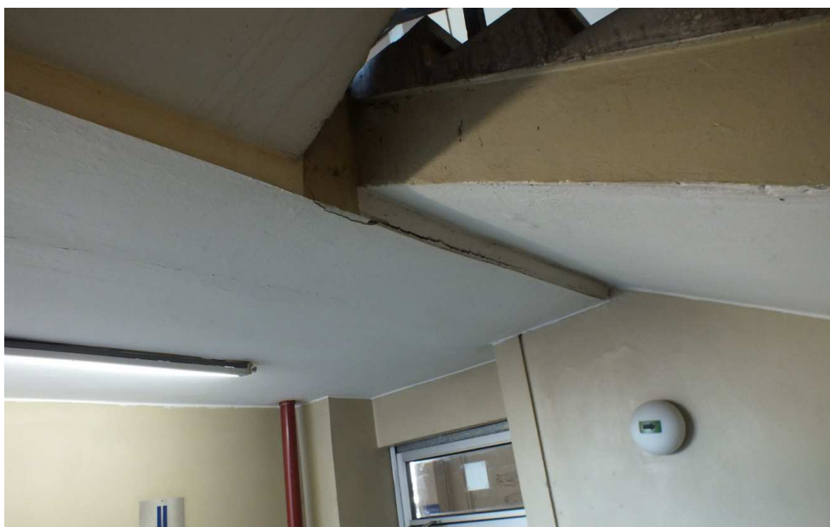
Fot. Z.1.19 Widok odspojenia na płycie spocznika między piętrowego schodów.
