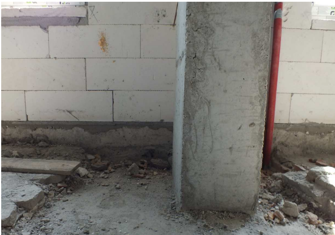
Fot. Z.1.6 Widok występujących raków w podstawie słupa świadczących o źle zawibrowanej mieszance betonowej
