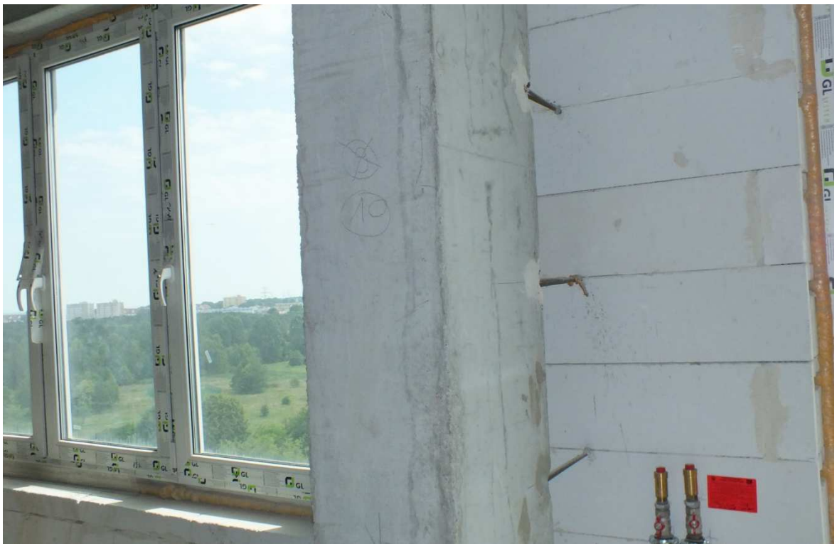
Fot. Z.1.8 Widok błędnie wykonanego zbrojenia dystansowego ścian w obrębie słupa.
