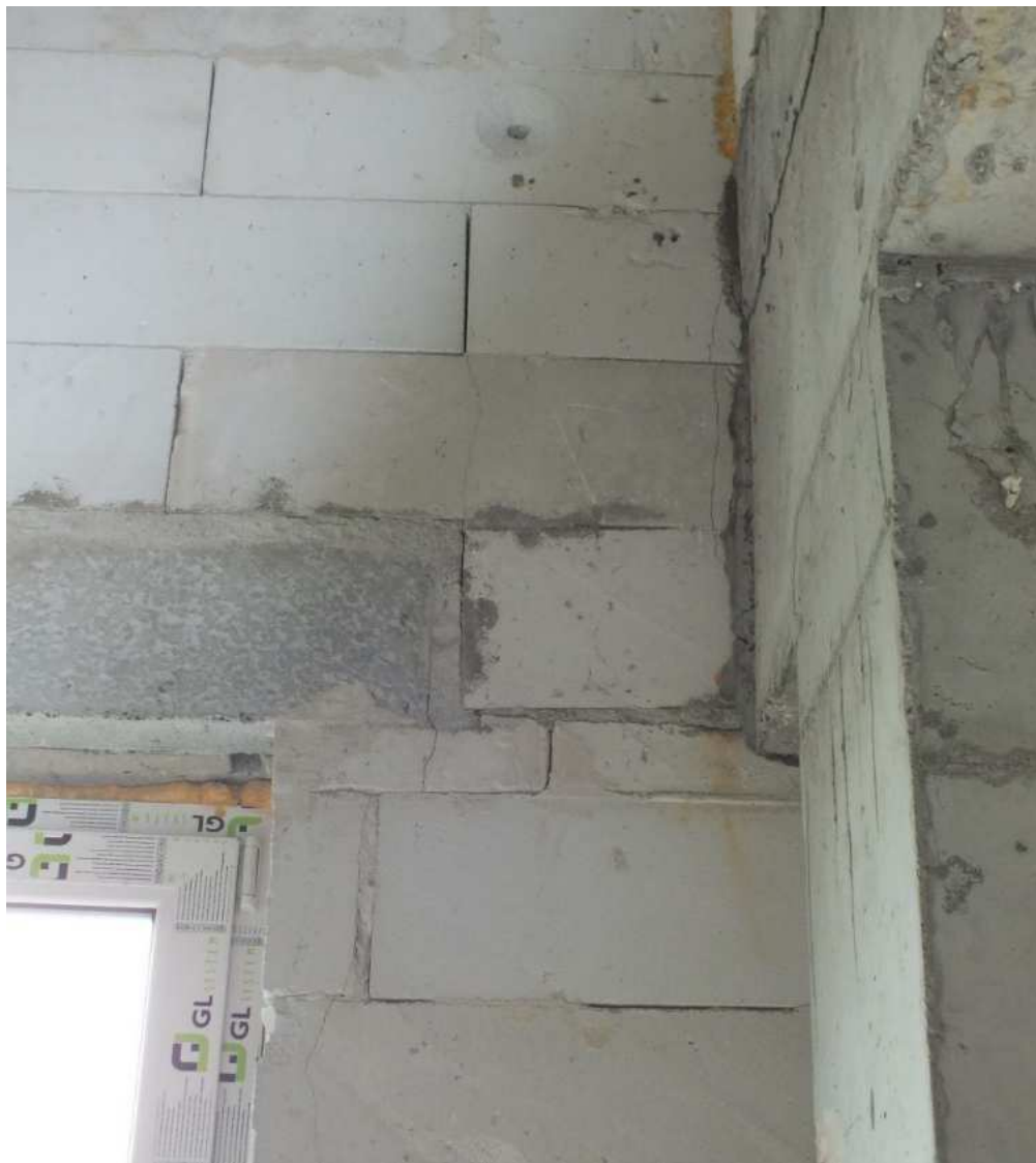
Fot. Z.1.10 Widok rysy w obrębie naroży uskołu płyty stropodachu
