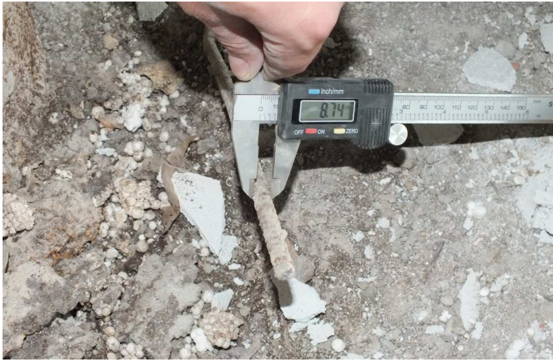
Fot. Z.2.16 Bezpośredni pomiar zbrojenia podporowego zbrojenia wielkopłytkowego stropu na bazie stropu Akerman w strefie podporowej
