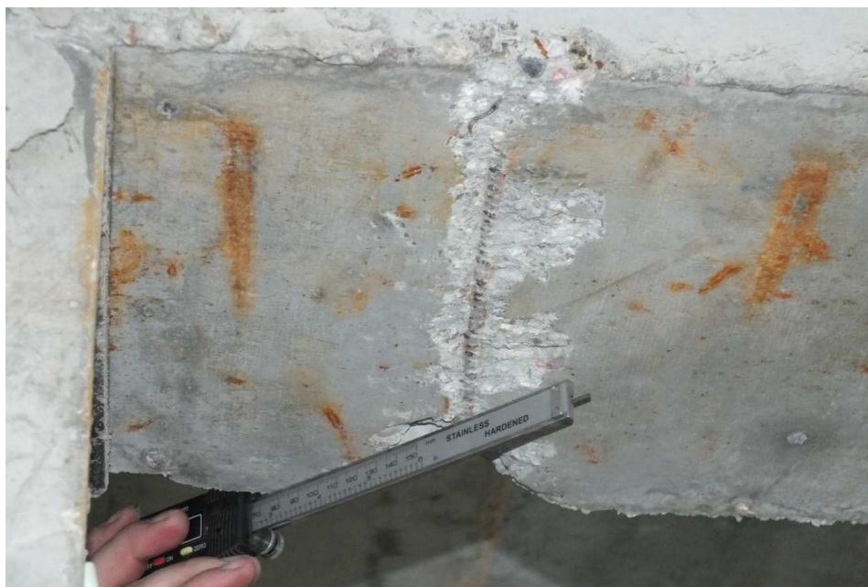
Fot. Z.2.14 Odkrywka obrazująca brak otuliny rygla ramy w strefie przypodporowej
