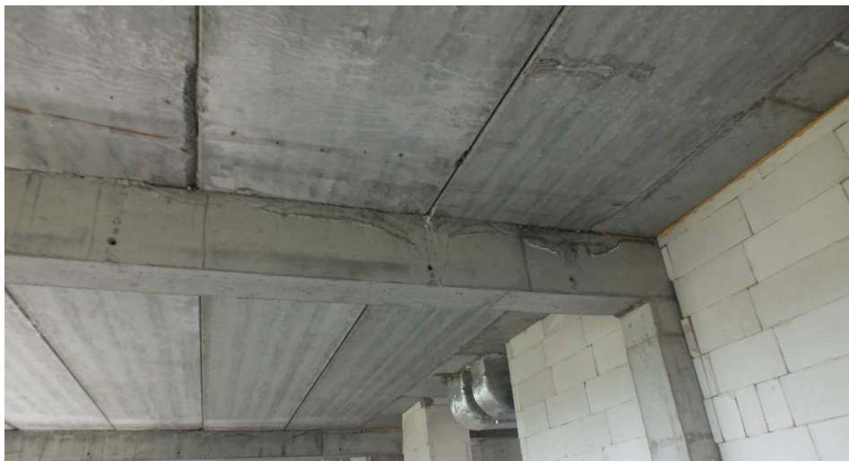
Fot. Z.1.21 Widok zacieków na ryglu ramy obrazujący skalę nieuszczelności pokrycia
