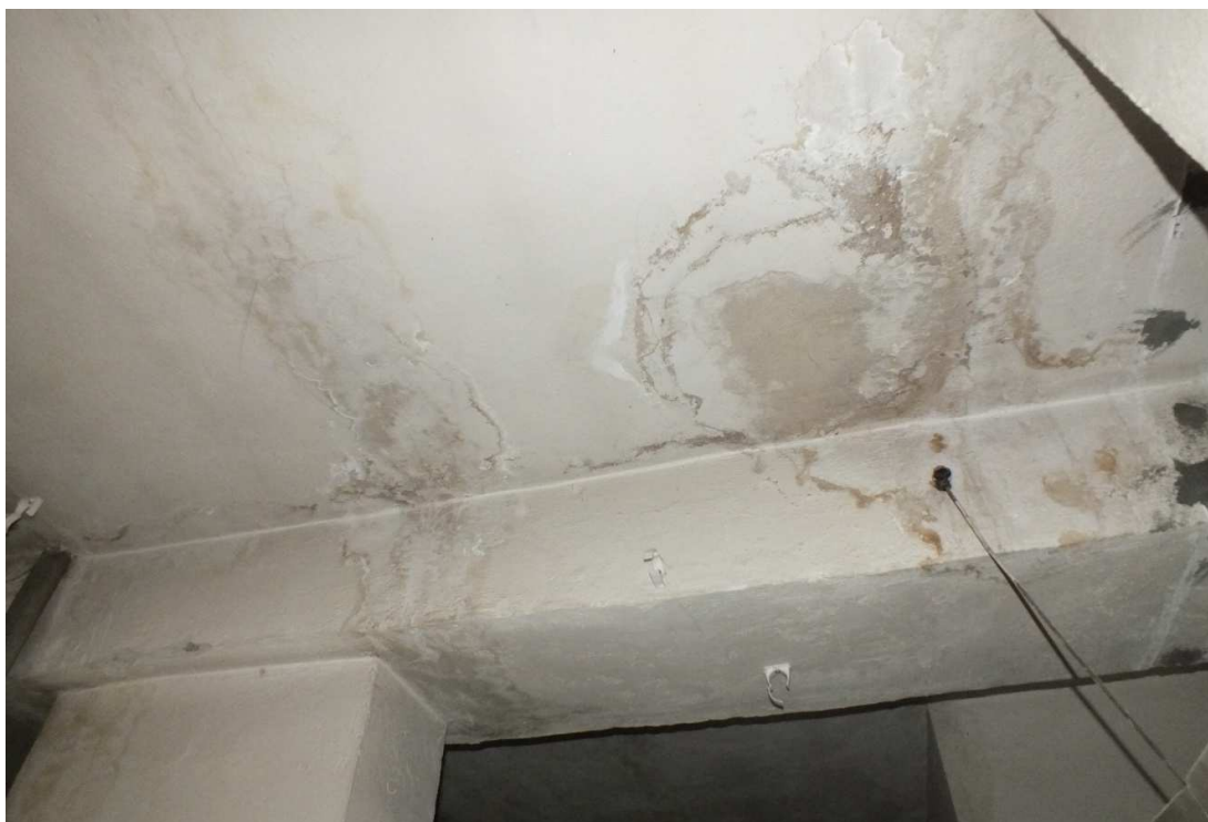
Fot. Z.1.23 Widok zawilgocenia stropodachu na części wykonanej jako pierwotna w poziomie VII piętra
