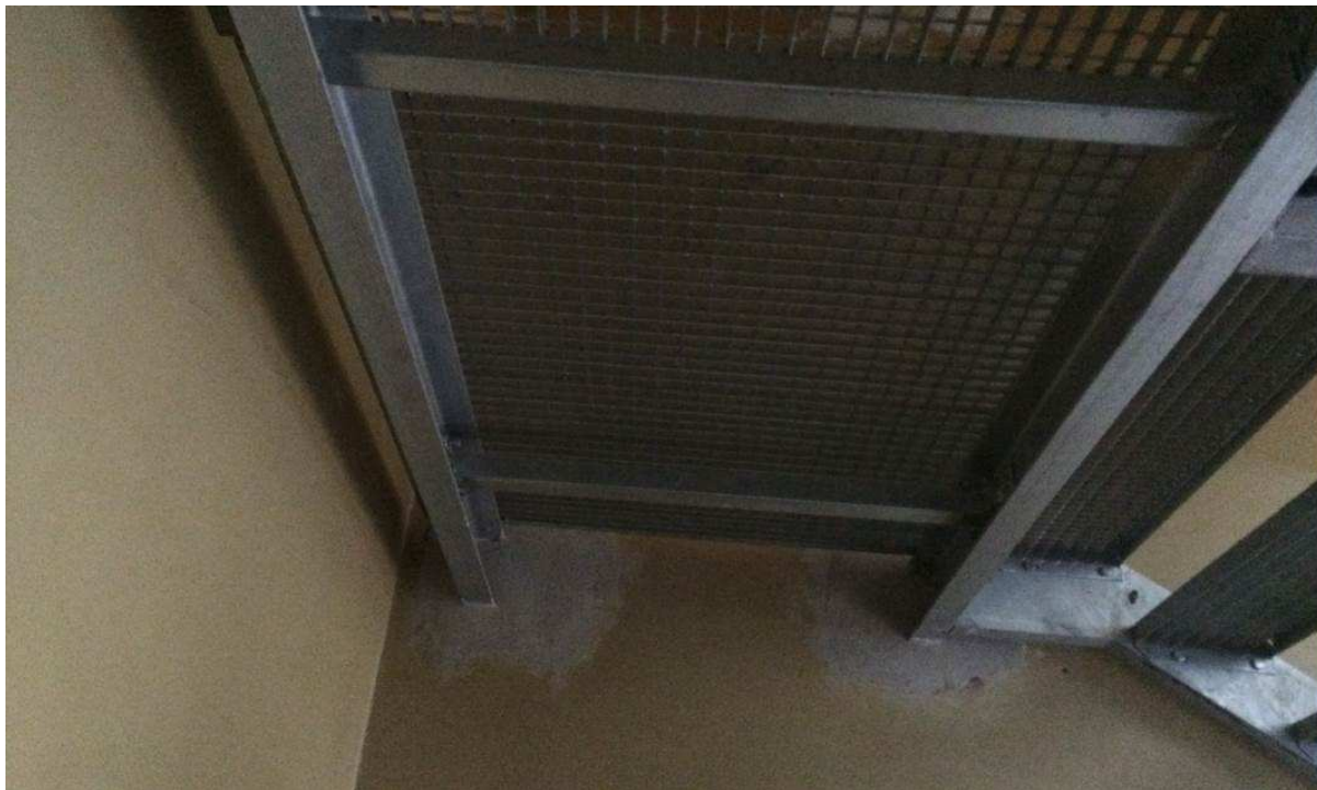
Fot.16. Widok mocowania belek spocznika pośredniego w ścianie murowanej
