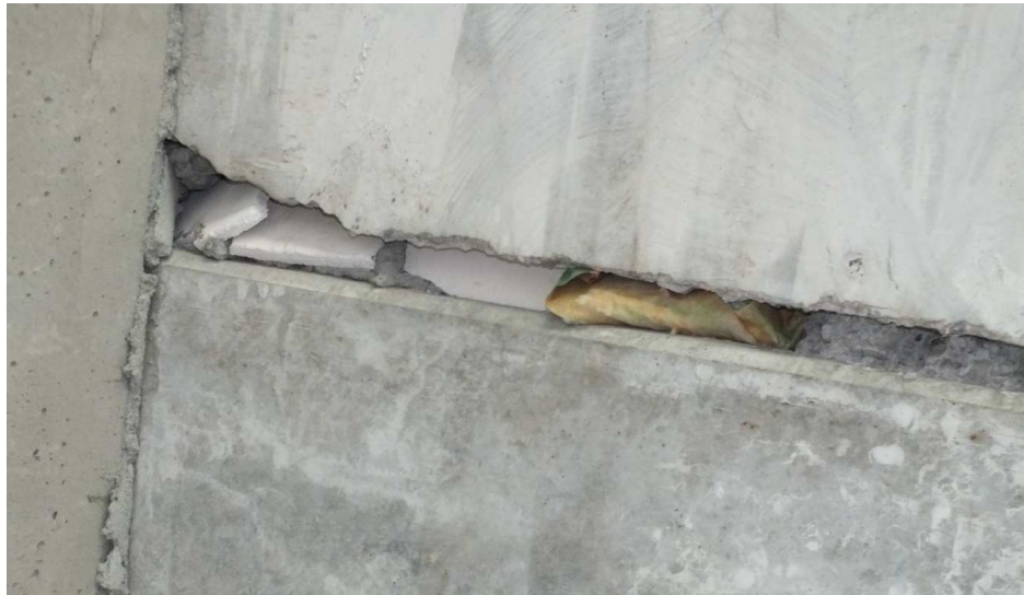
Fot. Z.1.20 Widok niestarannie wykonanego styku prefabrykowanych płyt sprężonych
