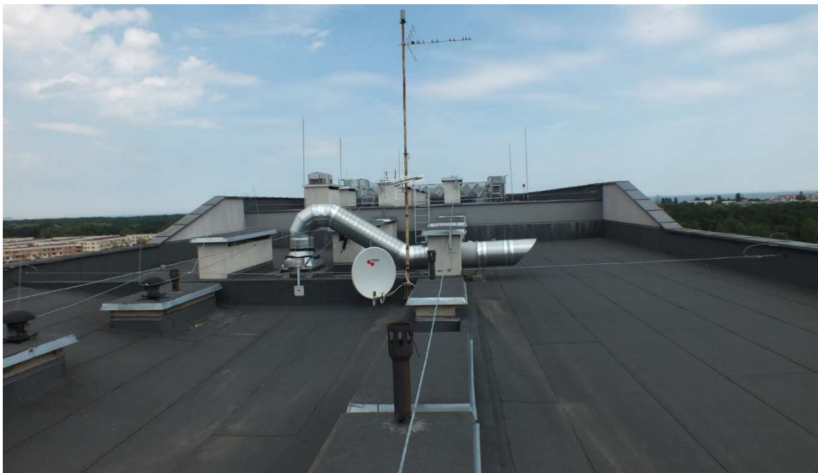
Fot. Z.1.15 Widok stropodachu z widocznymi pionami wentylacyjnymi oraz urządzeniami technicznymi budynku w części północnej
