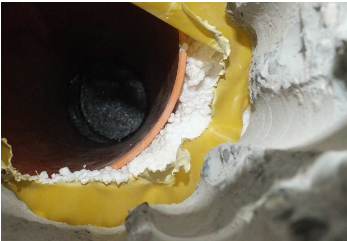
Fot. Z.2.9 Widok przebiecia instalacyjnego przez płytę sprężoną potwierdzający zastosowanie styropianu jako warstwę formującą izolację termiczną stropodachu
