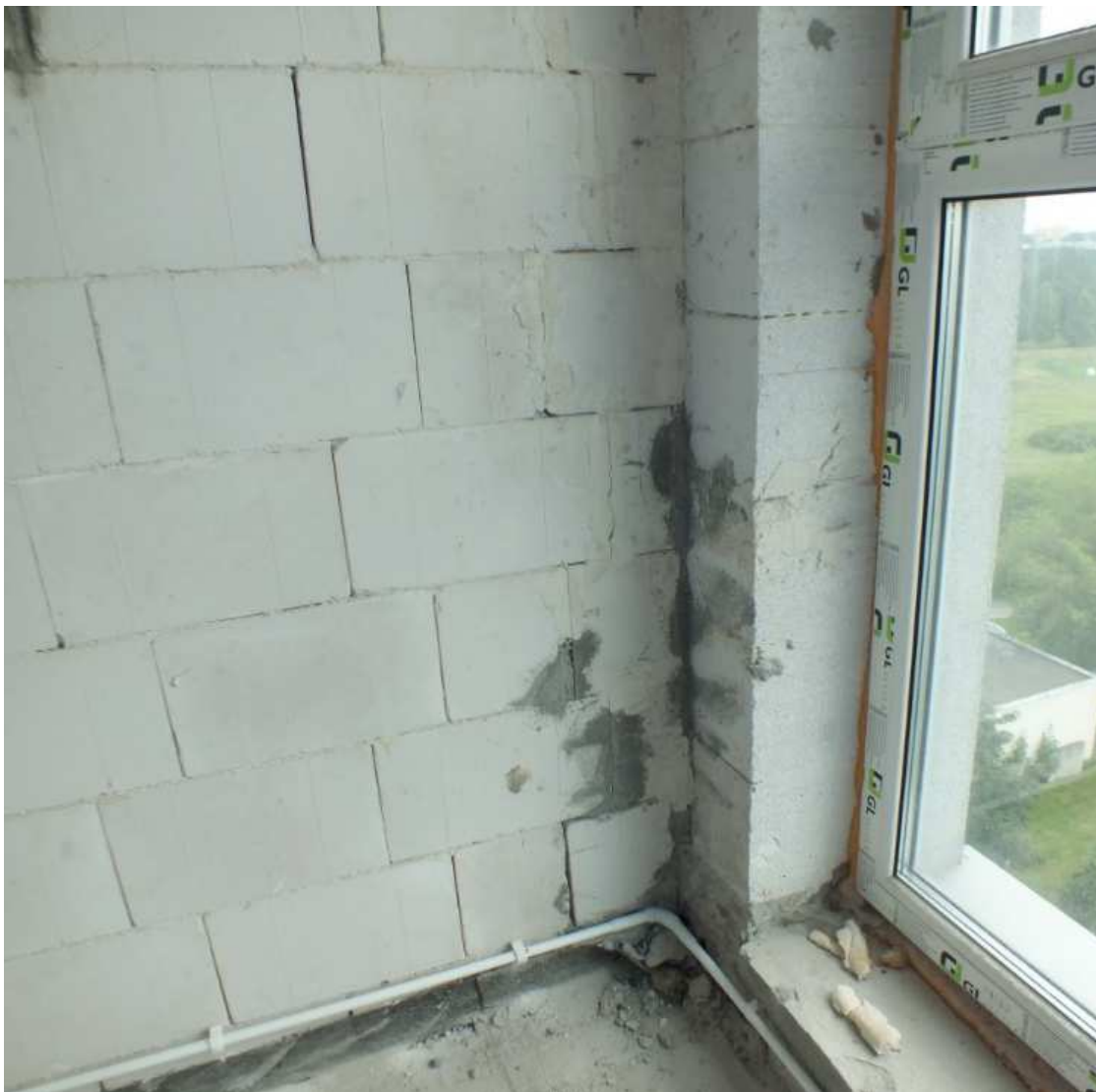
Fot. Z.1.12 Widok rys i odspojień w obrębie ściany osłonowej i ściany poprzecznej klatki schodowej z widocznymi śladami prób naprawczych
