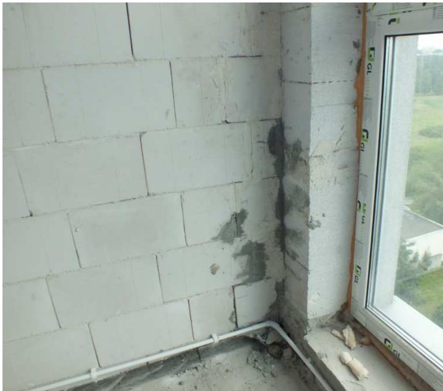
Fot.13. Widok połączenia ścian prostopadłych w obrębie osi A/1
