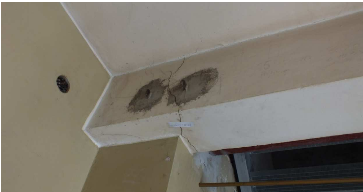
Fot. Z.1.18 Widok pionowej rysy na belce żelbetowej świadczącej o jej ścięciu w skutek przekroczenia dopuszczalnych naprężeń ścinających
