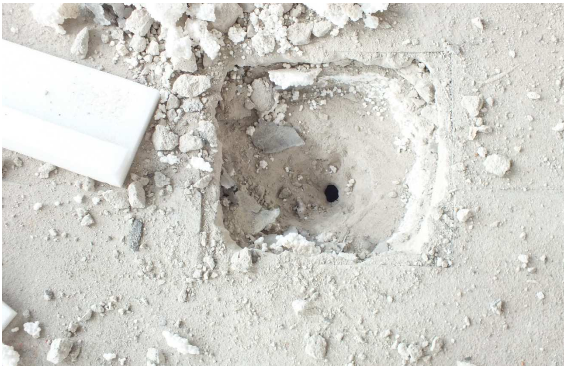
Fot. Z.2.3 Odkrywka stropu gęsto-żebrowego nad oddziałem kardiochirurgii dziecięcej potwierdzająca wysokość pustaka ceramicznego
