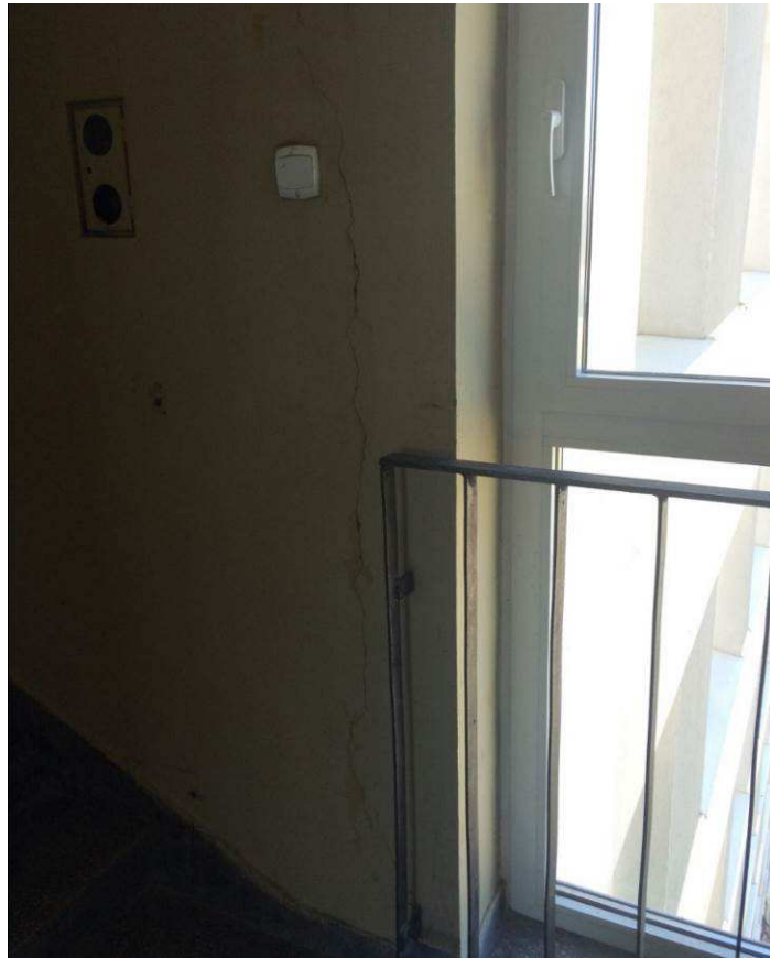
Fot.18. Widok rysy pionowej w miejscu braku poprawnie wykonanej dylatacji
