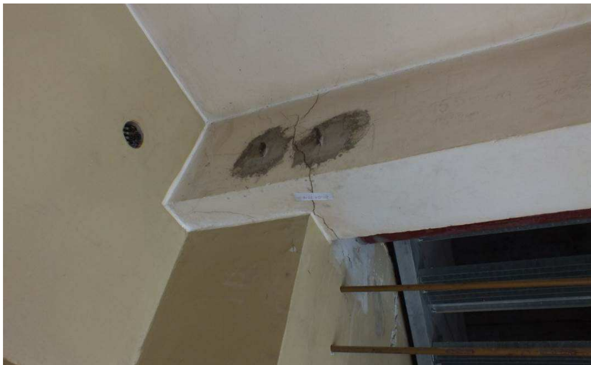
Fot.17. Widok ścięcia belki żelbetowej w osiach D/10-11
