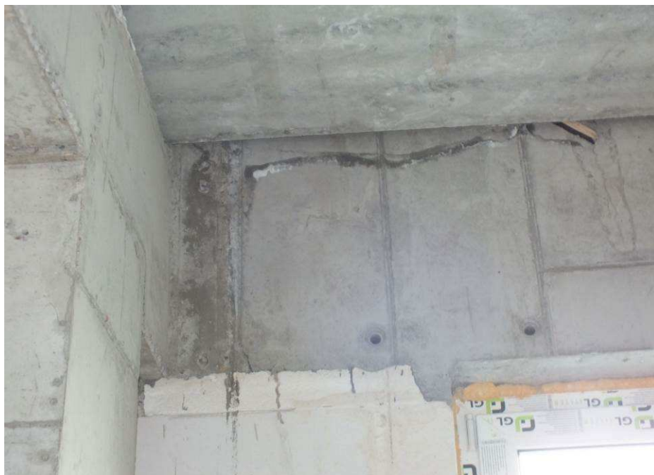
Fot. 9. Widok połączenia etażowego ramy żelbetowej i wieńca żelbetowego.
