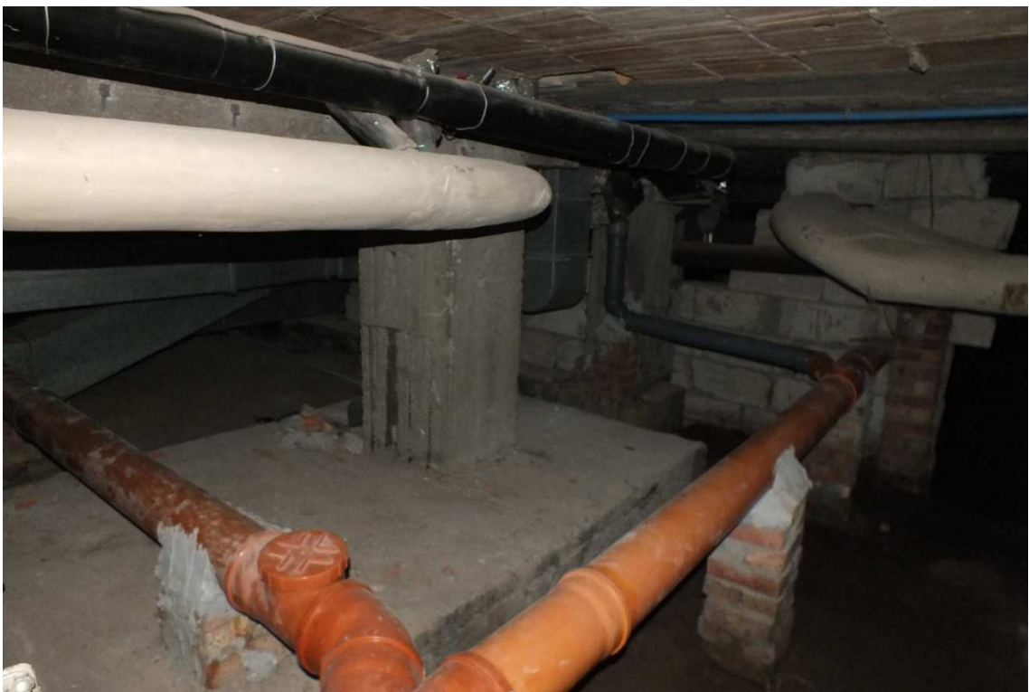
Fot. Z.2.17 Widok rozpoznanego układu posadowienia budynku w postaci płyty dennej i ław fundamentowych. Pod ramami typu H wykonane są stopy kielichowe.
