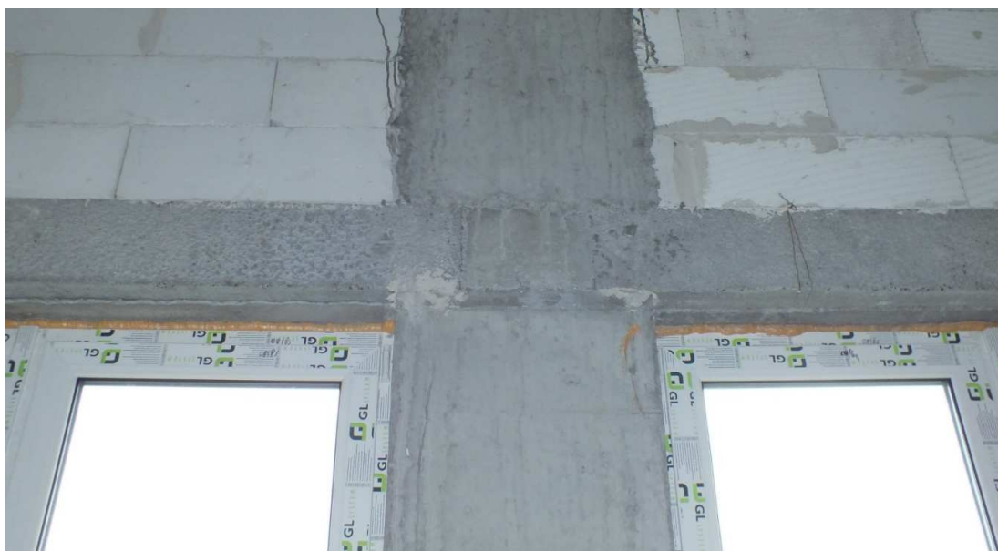
Fot. Z.1.11 Widok wykonania filara międzyokiennego w części wyższej nadbudowanego piętra VII
