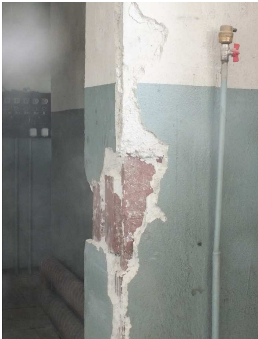
Fot. Z.2.11 Odkrywka dokumentująca rozpoznanie istniejących ram typu H
