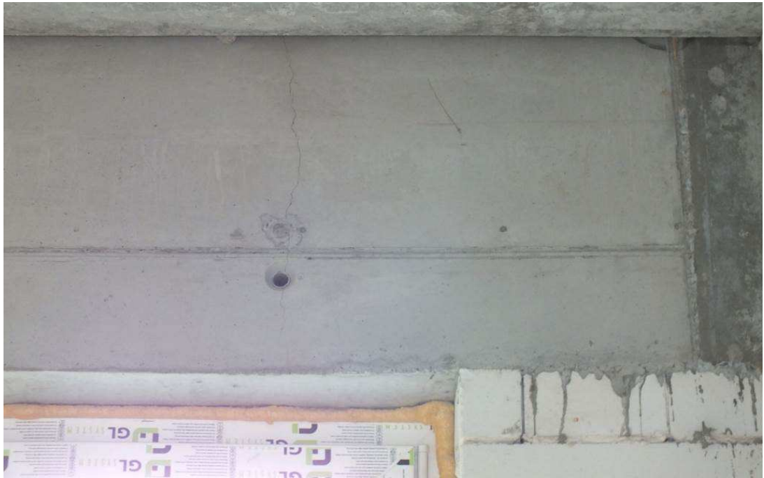
Fot.7. Wieniec żelbetowy w obrębie osi 10- widok rysy pionowej w narożu okiennym
