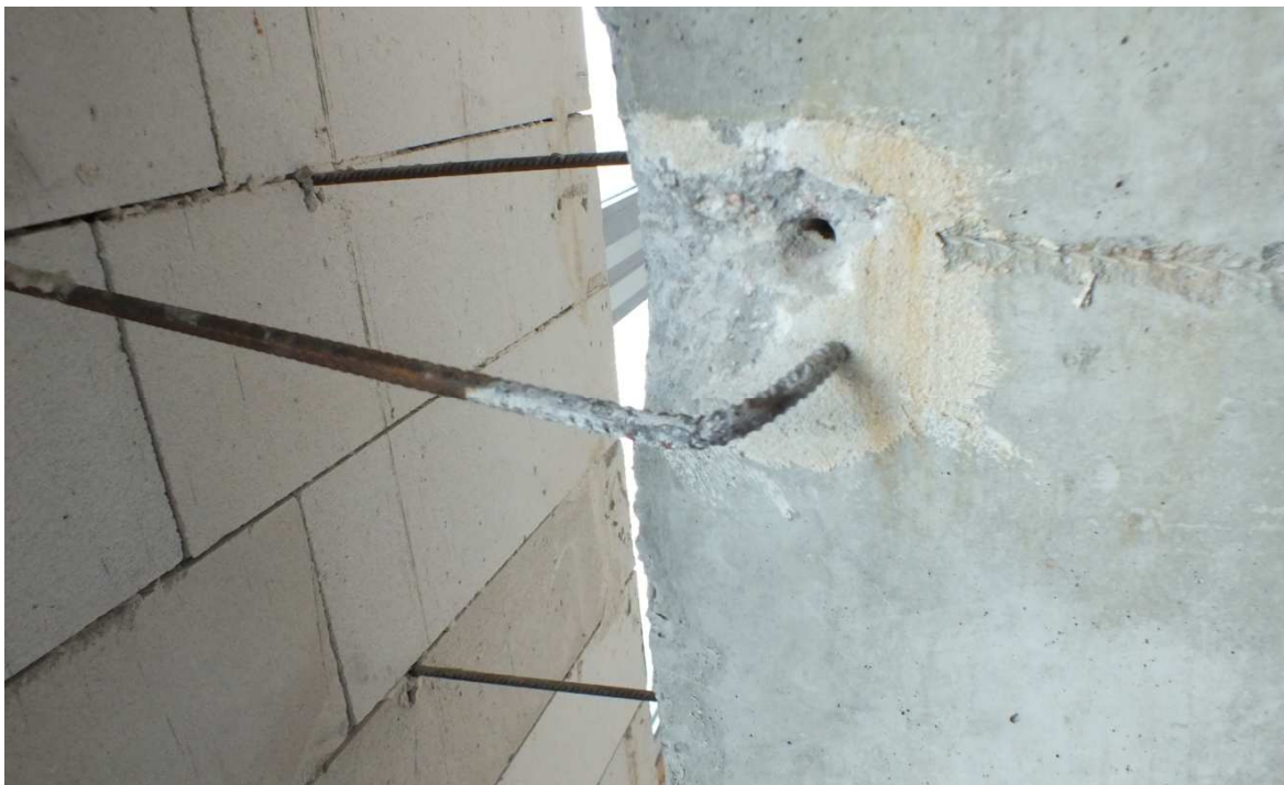
Fot. Z.2.8 Odkrywka pręta dystansowego łączącą ścianę zewnętrzną ze słupem skrajnym ramy żelbetowej
