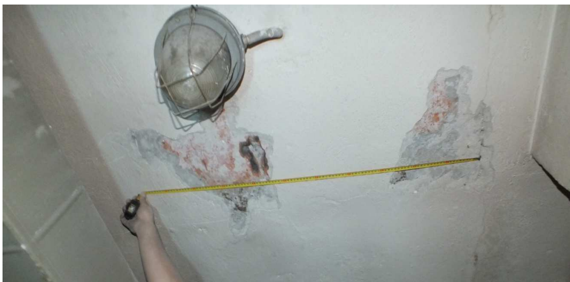
Fot. Z.2.13 Odkrywka potwierdzająca system wielopłytkowych stropów prefabrykowanych na bazie stropu Akerman
