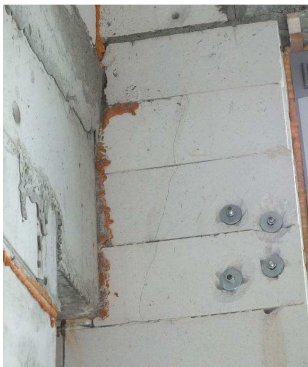
Fot.10. Widok detalu mocowania elewacyjnych krat dekoracji- widoczne rysy wskrośne ściany murowanej.
