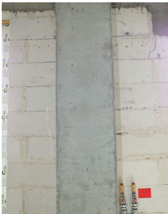
Fot.12. Widok słupa w osi A/9 z widocznymi brakami prętów dystansowych
