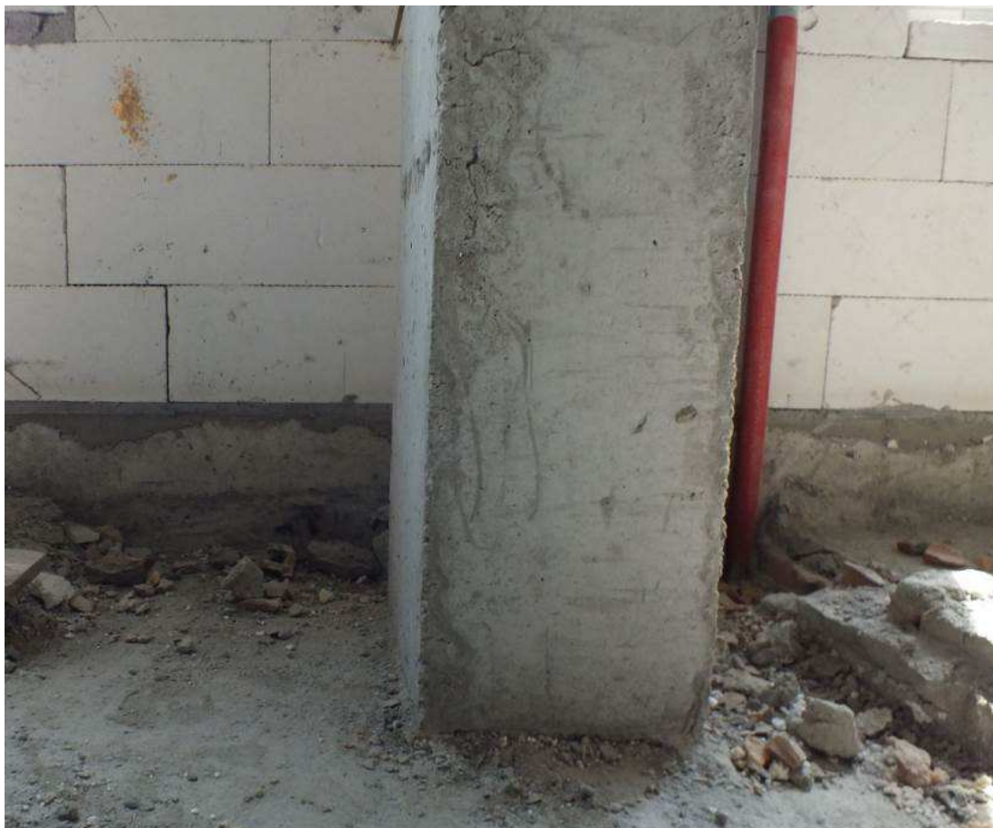
Fot.6. Stłup skrajny ramy żelbetowej z uwidocznionymi rakami powierzchni betonowania
