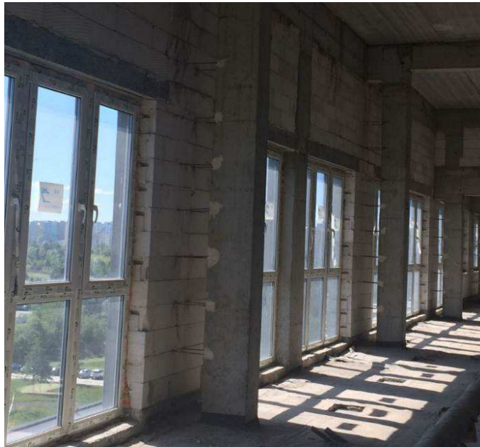
Fot.11. Widok strzępi stalowych mocujących ściany zewnętrzne do słupów
